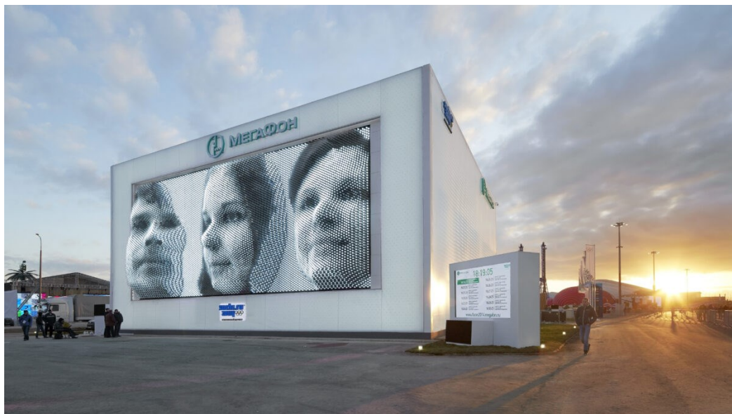
Figura 2. Esempio di display fisico. MegaFon Pavilion , realizzato per le Olimpiadi invernali di Sochi del 2014. Più di diecimila attuatori erano in grado di riprodurre i volti degli spettatori, fotografate con speciali fotocamere 3D.
