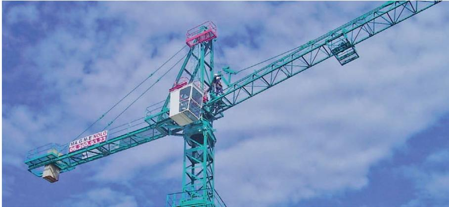
Figura 39 - Installazione in quota del braccio e collegamento dei tiranti [45]
