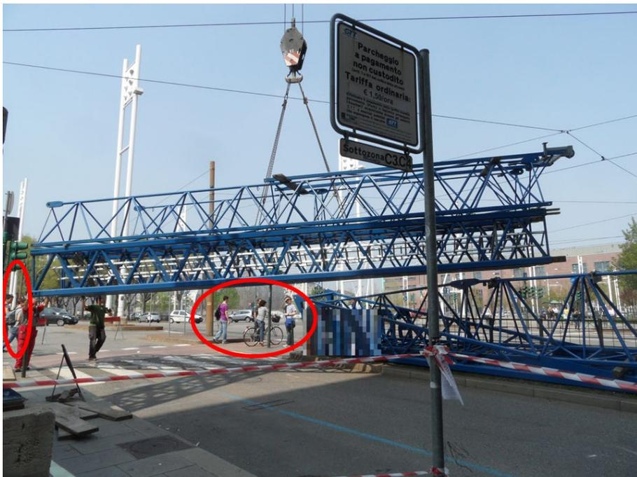
Figura 50 - Sollevamento e scarico di elementi della gru in prossimità di terzi, con mancata regolazione del transito pedonale
