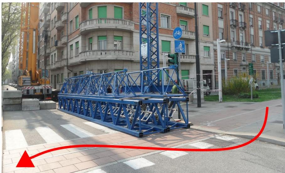
**Figura 47 - Possibilità di transito di persone estranee al cantiere in prossimità dell'area di carico/scarico materiali**
