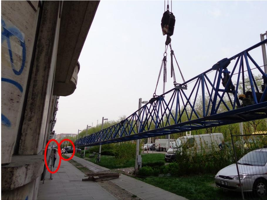
Figura 49 - Sollevamento del braccio in prossimità di terzi, con mancata regolazione del transito pedonale
