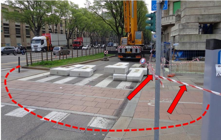
**Figura 46 - Insufficiente segregazione dello spazio lavorativo e inadeguato metodo di recinzione (semplice nastro segnaletico biancorosso)**
