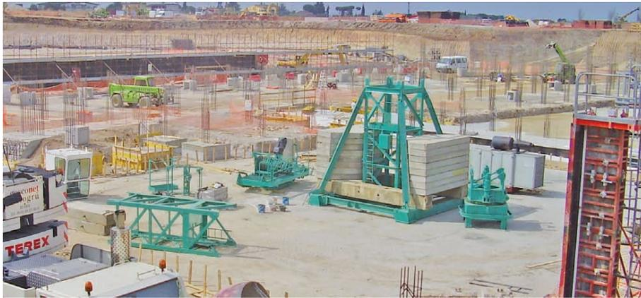
Figura 33 - Carro di base in posizione con zavorre [45]
