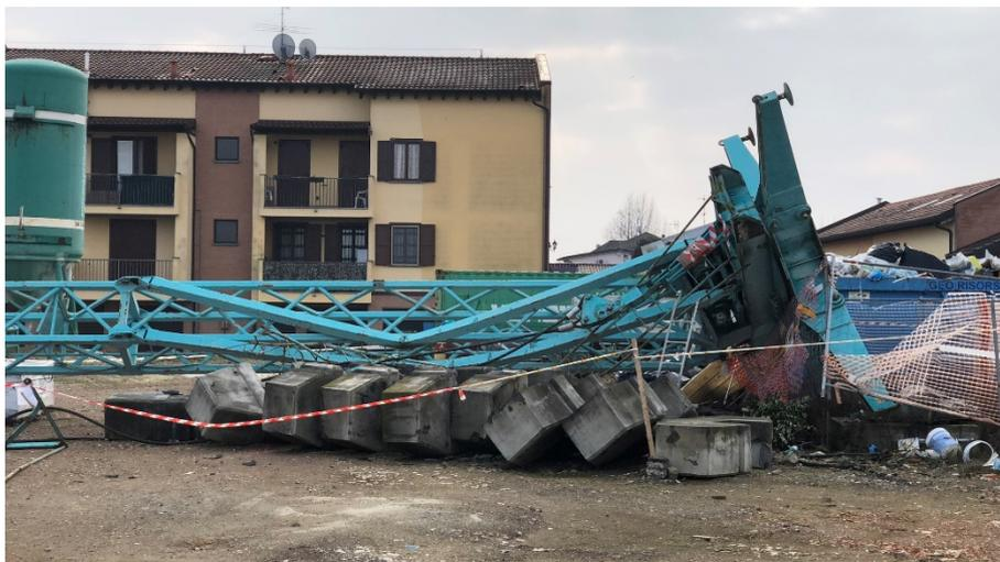
**Figura 20 - Particolare del carro di base e zavorre**
