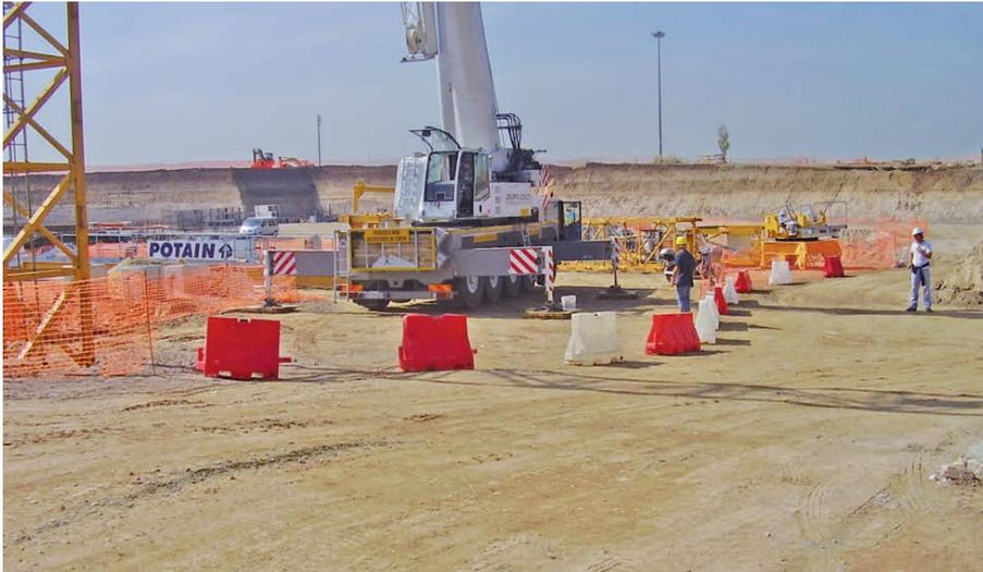
Figura 32 - Posizionamento autogrù e allestimento area di lavoro [45]
