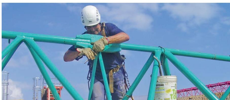
Figura 38 - Montaggio a terra del braccio [45]
