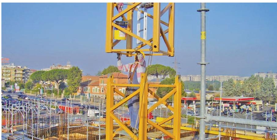
**Figura 36 - Fissaggio dell'elemento alla torre [45]**
