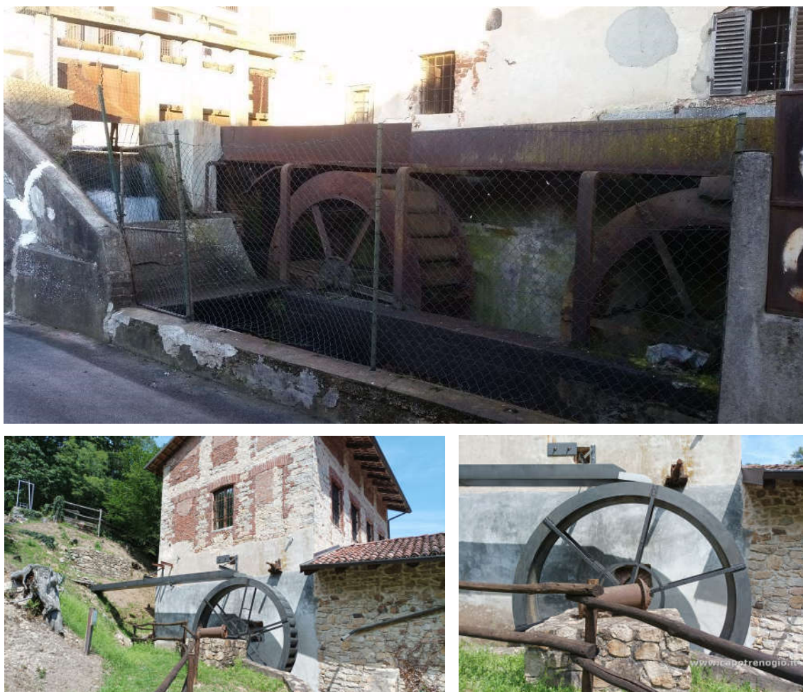
Figura 48: Dall'alto, condizione da stato di fatto delle giranti del mulino Querio lungo il prospetto Ovest; in basso, ex mulino Susta di Soprana, oggi museo. Dettaglio del restauro della canaletta e della girante funzionante.
