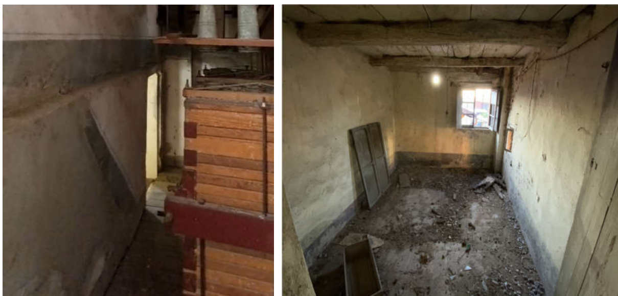
Figura 22: A sinistra, decorazione pittorica della parete al secondo piano da cui si è presunta l'antica presenza di una rampa di scale, successivamente rimossa per far posto al solaio ligneo e al plansichter che si nota in primo piano; stanza abbandonata a seguito del suddetto intervento di installazione del macchinario, della quale è impedito l'accesso.
