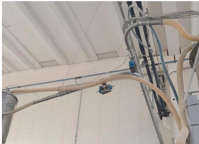
*Figura 2.62: Tubazione doppia dei big bag delle linee "Linea 1" e "Linea 3" nella parte superiore*
