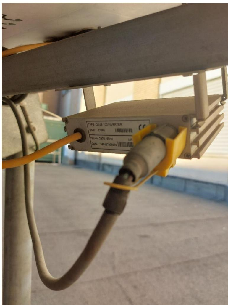
Figura 4-8: Inverter di modulo OK4E-100 con connessioni lato DC (sinistra, cavo giallo) e lato AC (destra, connettore e cavo grigio).
