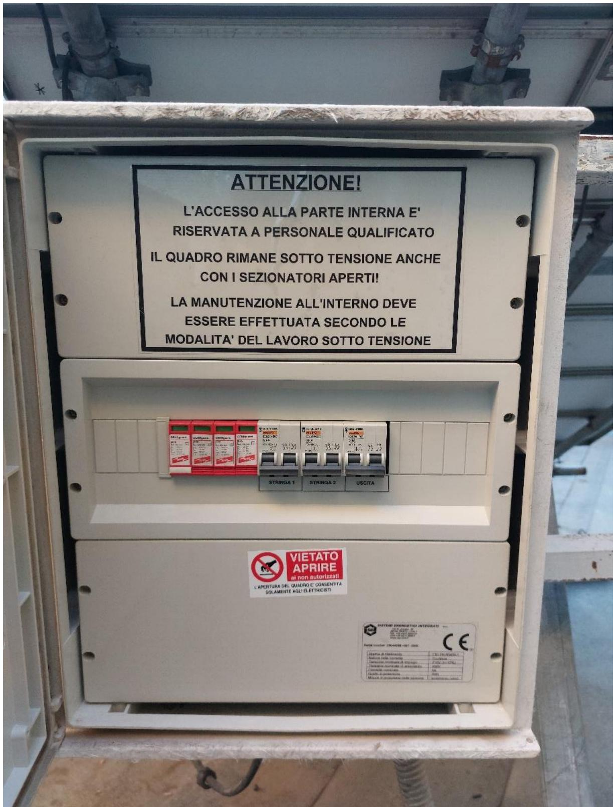
Figura 4-4: Quadro di parallelo stringhe dell'impianto centralizzato. Sono visibili gli SPD e gli interruttori magnetotermici.
