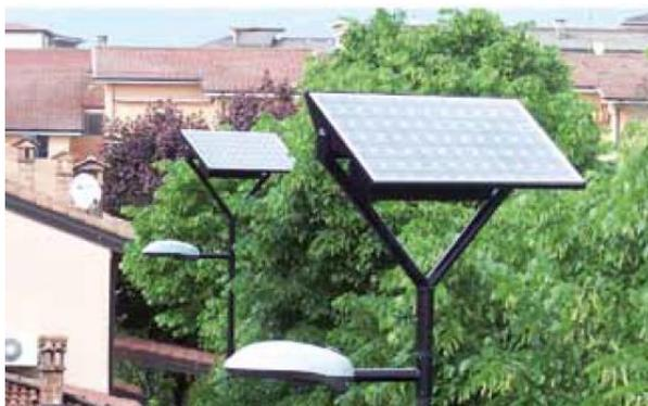
Figura 1-20: Moduli FV per l'alimentazione *stand-alone* di lampioni. [2]
