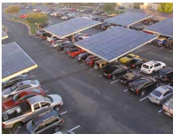
Figura 1-23: Moduli FV sulle pensiline di un parcheggio. [2]
