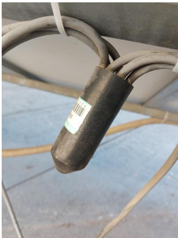
Figura 4-9: Scatola di collegamento in parallelo del gruppo di 6 inverter.
