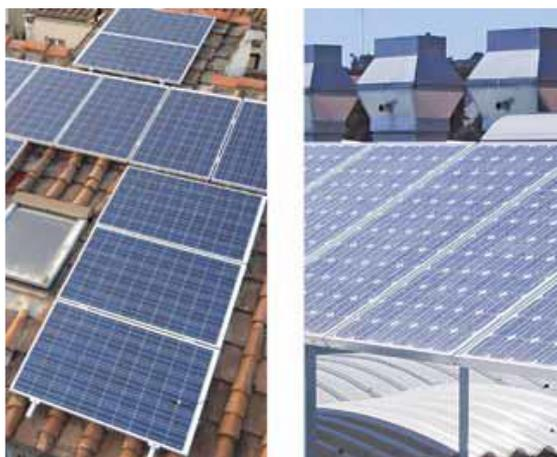
Figura 1-22: Impianti fotovoltaici installati su tetti di edifici residenziali e industriali. [2]
