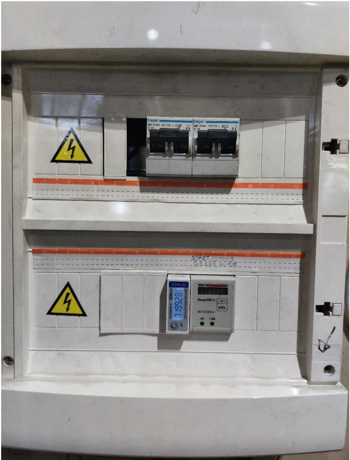
Figura 4-10: Quadro dell'impianto con inverter di modulo. In alto gli interruttori dei gruppi di inverter, in basso il contatore Modbus e un contatore analogico dismesso.
