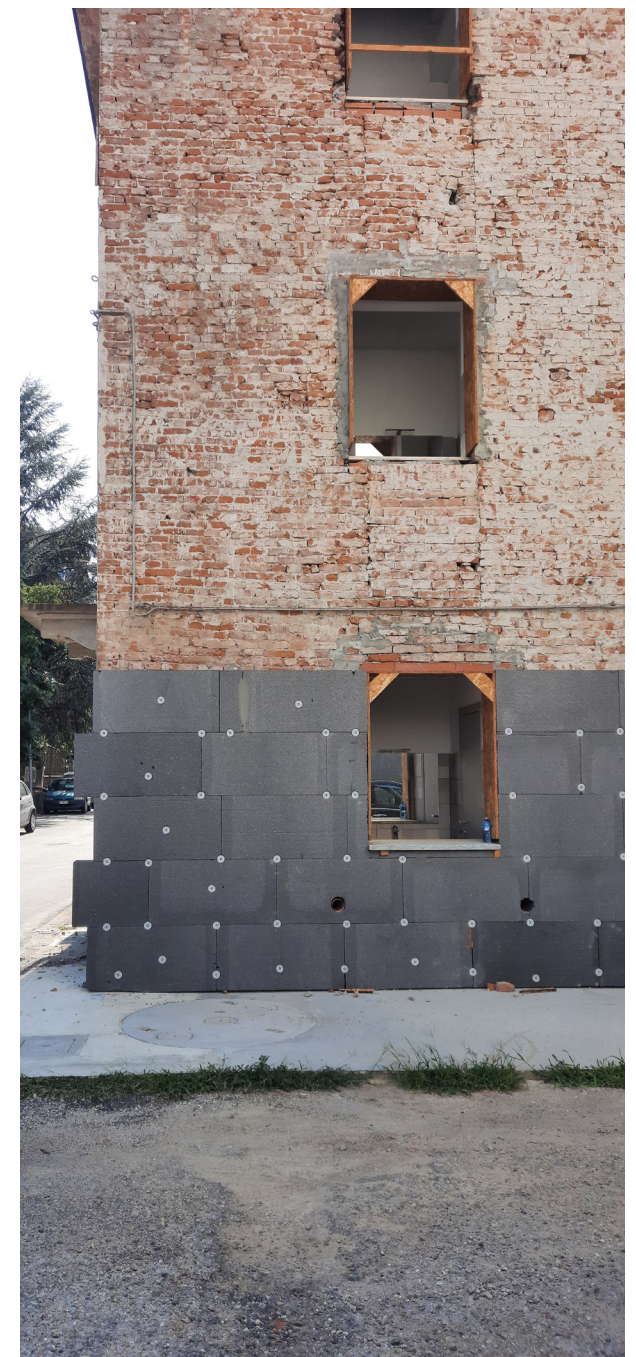
Fig.2.26: Immagine da un cantiere, realizzazione del cappotto termico.
