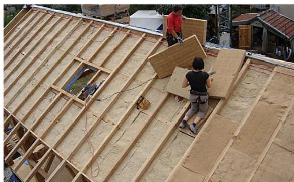
Figura 3.08 - Isolamento della copertura con pannelli in fibra di canapa
