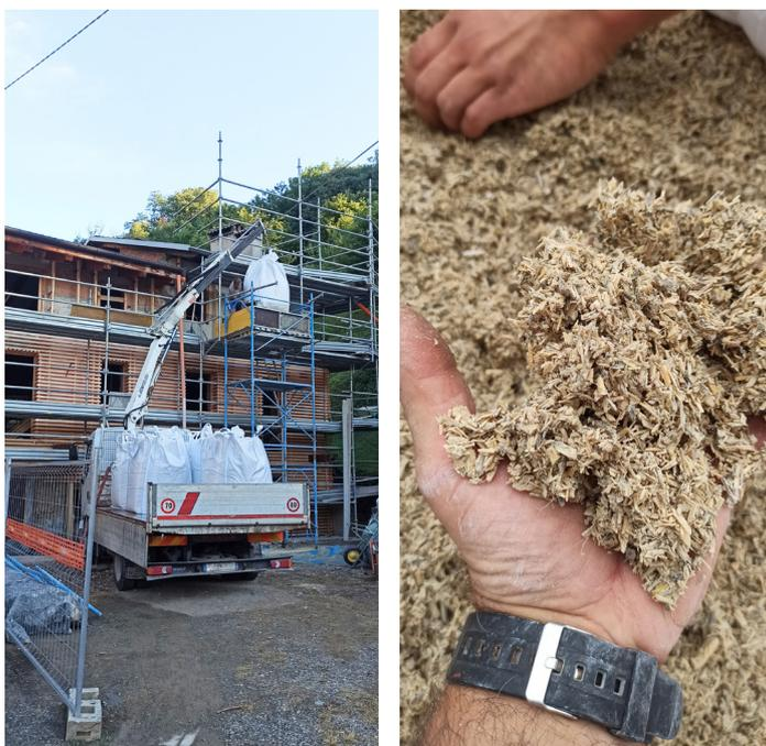
Figura 4.09 - Da sinistra: arrivo della miscela in big bags e consistenza della miscela in calce e canapulo.
