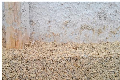
Figura 1.15 - Applicazione del conglomerato in calce e canapulo
