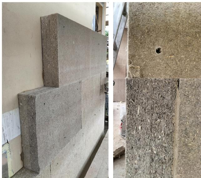
**Figura 4.15 - Sfasamento dei giunti e alternanza dello sporto in corrispondenza degli angoli**
