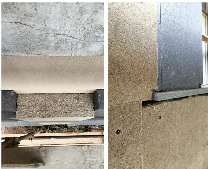
Figura 4.20 - Da sinistra: accostamento tra pannelli in fibra di canapa e in EPS e innesto con il davanzale
