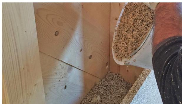
Figura 2.11 - Riempimento di un'intercapedine in calce e canapa
