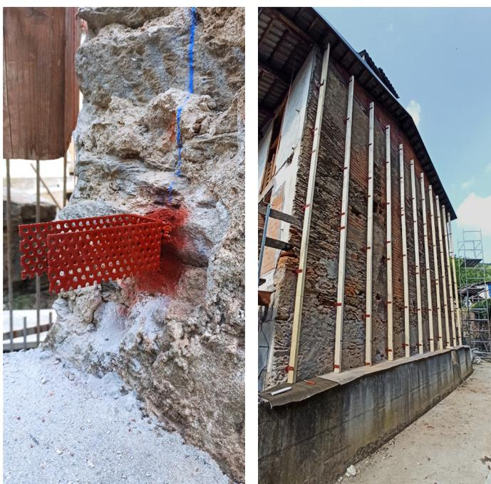
Figura 4.07 - Da sinistra: elementi di ancoraggio, posizionamento e fissaggio dei montanti verticali.
