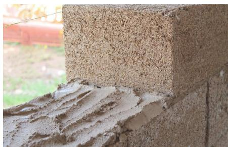
**Figura 1.17 -** Applicazione del mattone in calce e canapulo
