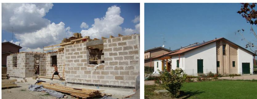
Figura 2.02 - Realizzazione dell’involucro esterno della prima abitazione costruita in canapa e calce
