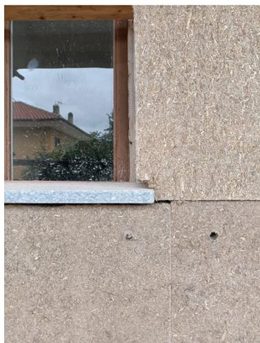
Figura 3.09 - Isolamento a cappotto in pannelli in fibra di canapa
