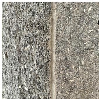
**Figura 4.16 - Fuga tra i pannelli con dimensione inferiore a 2 mm.**
