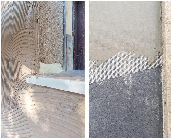
Figura 4.21 - Da sinistra: Rasatura dei pannelli in fibra di canapa ed EPS
