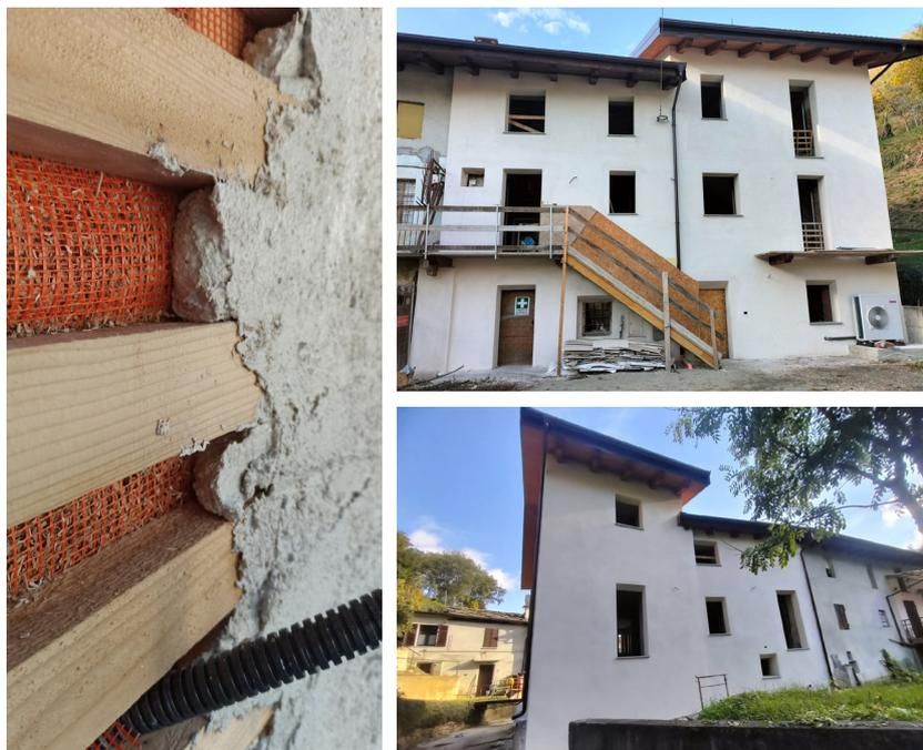
Figura 4.11 - Da sinistra: applicazione dello strato di termointonaco
