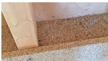
**Figura 1.20 -** Applicazione della lastra in calce e canapulo
