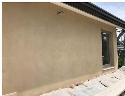
Figura 2.14 - Intonaco in calce e canapa
