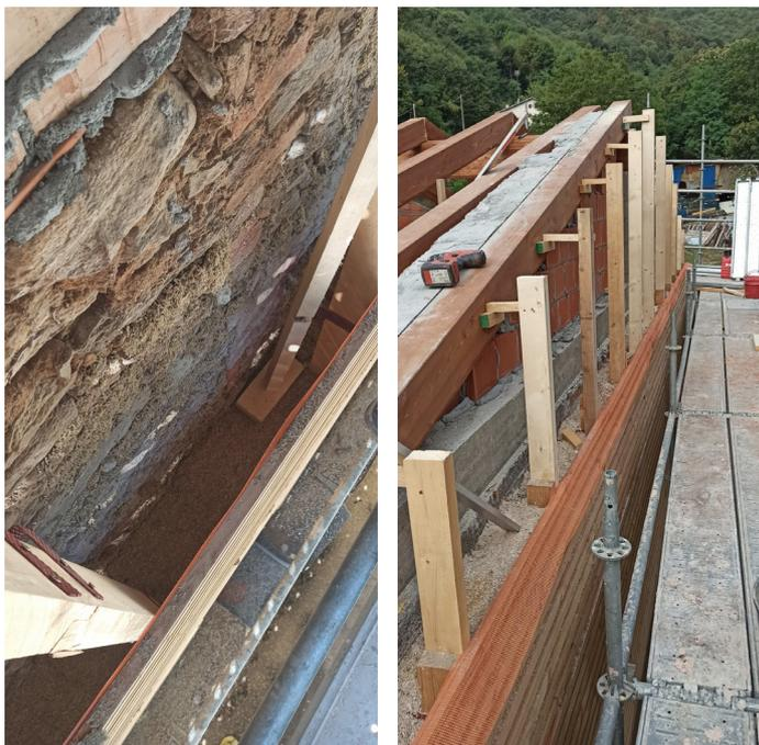
Figura 4.10 - Da sinistra: compattazione della miscela con il “pestello” e completamento della parete
