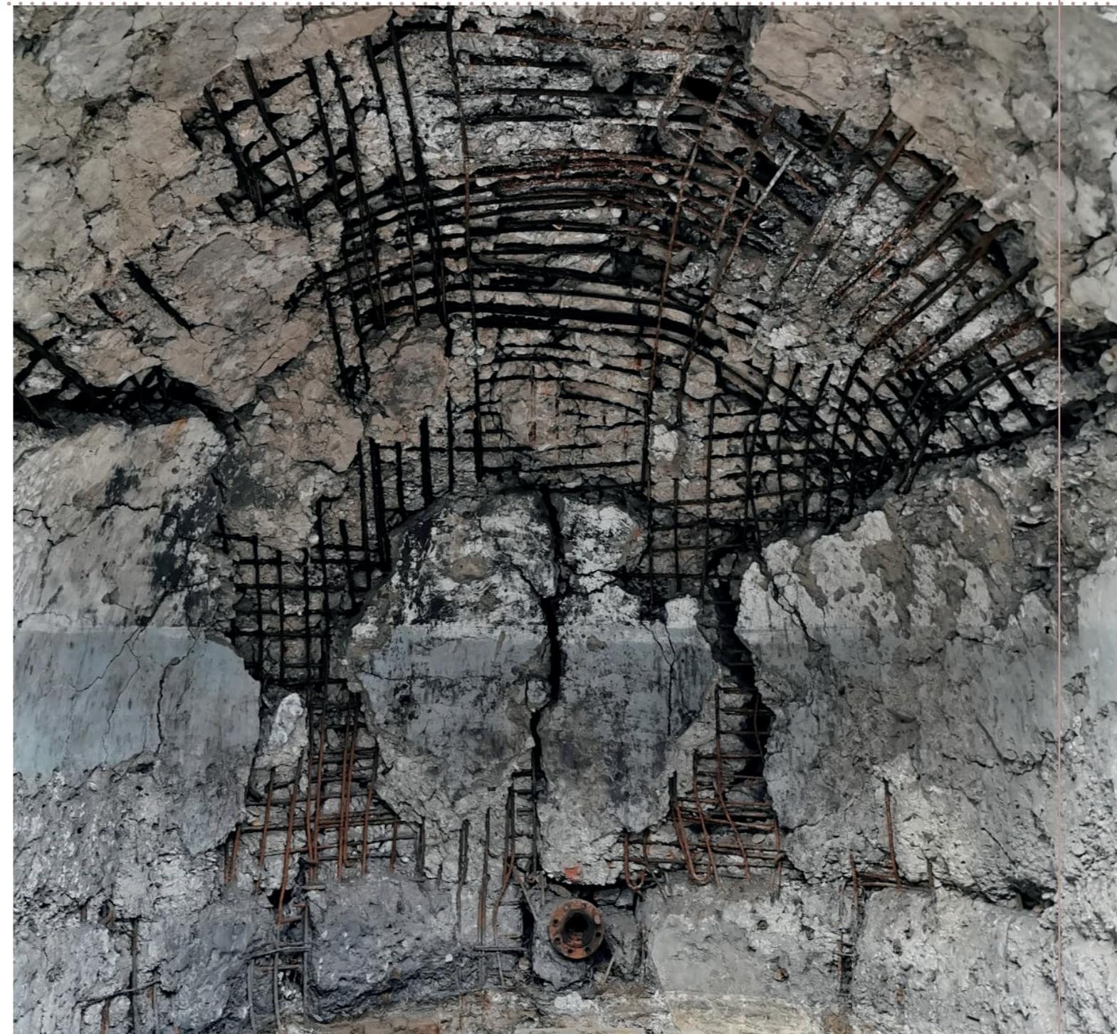
Fig. 3.16. Grotta per impastatrici con i danni causati dall'esplosione (tappa 14 del percorso museale)
