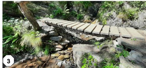
3 Attraversamento del Rio Comba del Duc con residuo muro in pietre a secco
