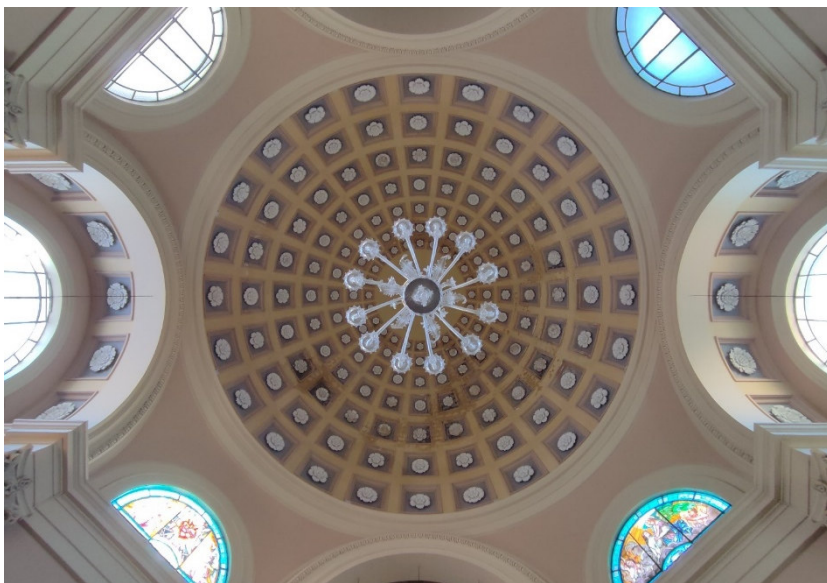
Figura 29. Vista dell'interno della cupola della chiesa di S. Maria della Porta, Lecce
