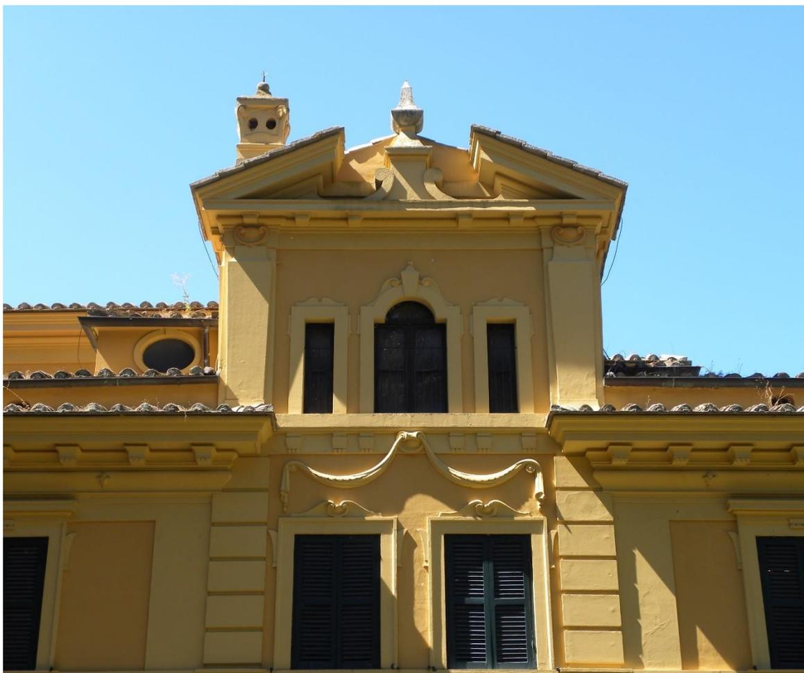
Fig. 41. Particolare della torretta: il frontone è interrotto abilmente per accogliere la guglia.
