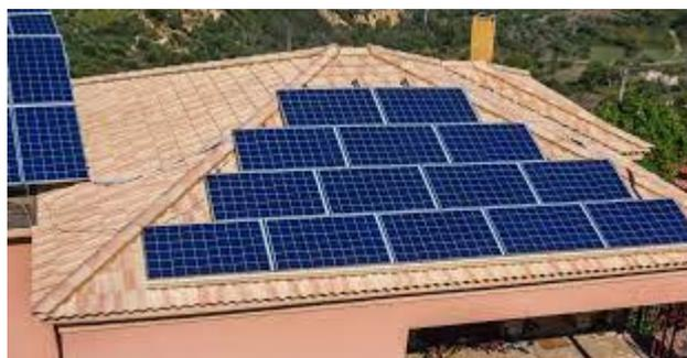
Figura 27\_Esempio di parco fotovoltaico domestico (potenza installata pari circa a 3kW)
