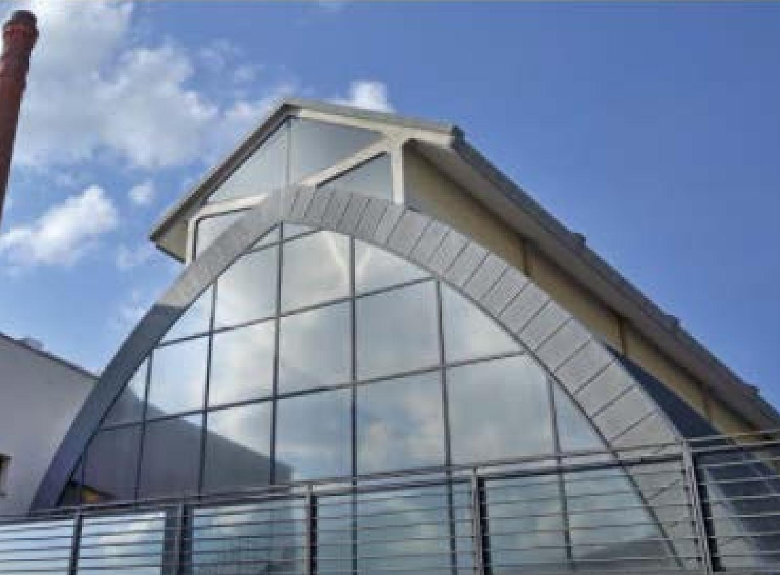
Il magazzino industriale a copertura parabolica è stato ideato in Italia intorno agli anni 20 del '900, con la realizzazione del silos per clinker di Casale Monferrato dell'ingegner Luigi Radici, che sostituisce la tradizionale copertura a campana con una volta parabolica.
