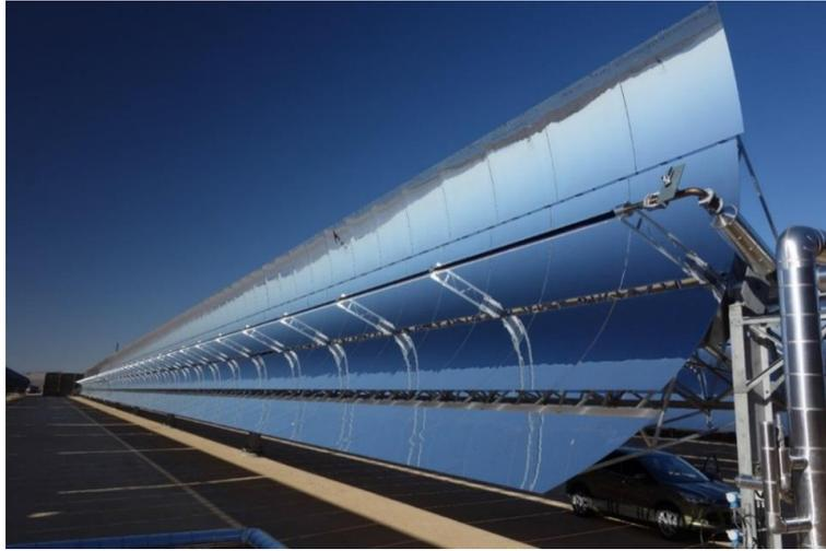
FIGURA 1.20 - CONCENTRATORE SOLARE PARABOLICO LINEARE [25]
