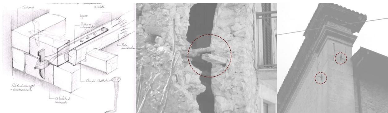
Figure 75: Left: "*radiciamenti*" (Cangi, 2009); Middle: Pure wooden "*radiciamenti*" in Villa Sant'Angelo (Carocci et al, 2021); Right: The use of "*radiciamenti*" with metal anchors in Chiesa di San Flaviano (Carocci et al, 2021).
