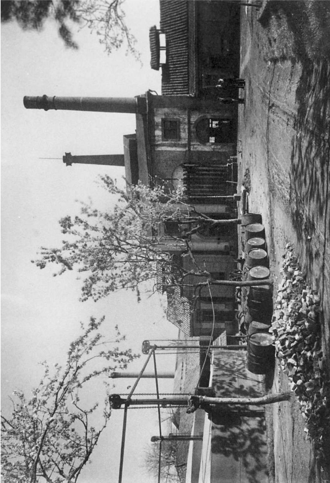
Fig. 9 Usina a Gaz di Pinerolo. La foto, che non ha datazione, può essere fatta risalire alla fine del XIX secolo. Sullo sfondo, a Sud, il fabbricato forni (attuale fabbricato C) nella sua originaria volumetria con la presenza di due camini di cui quello posto dietro al fabbricato sopravvissuto sino ai primi anni '50, sulla sinistra in primo piano un gasometro. (Pinerolo, Archivio storico della Città)
