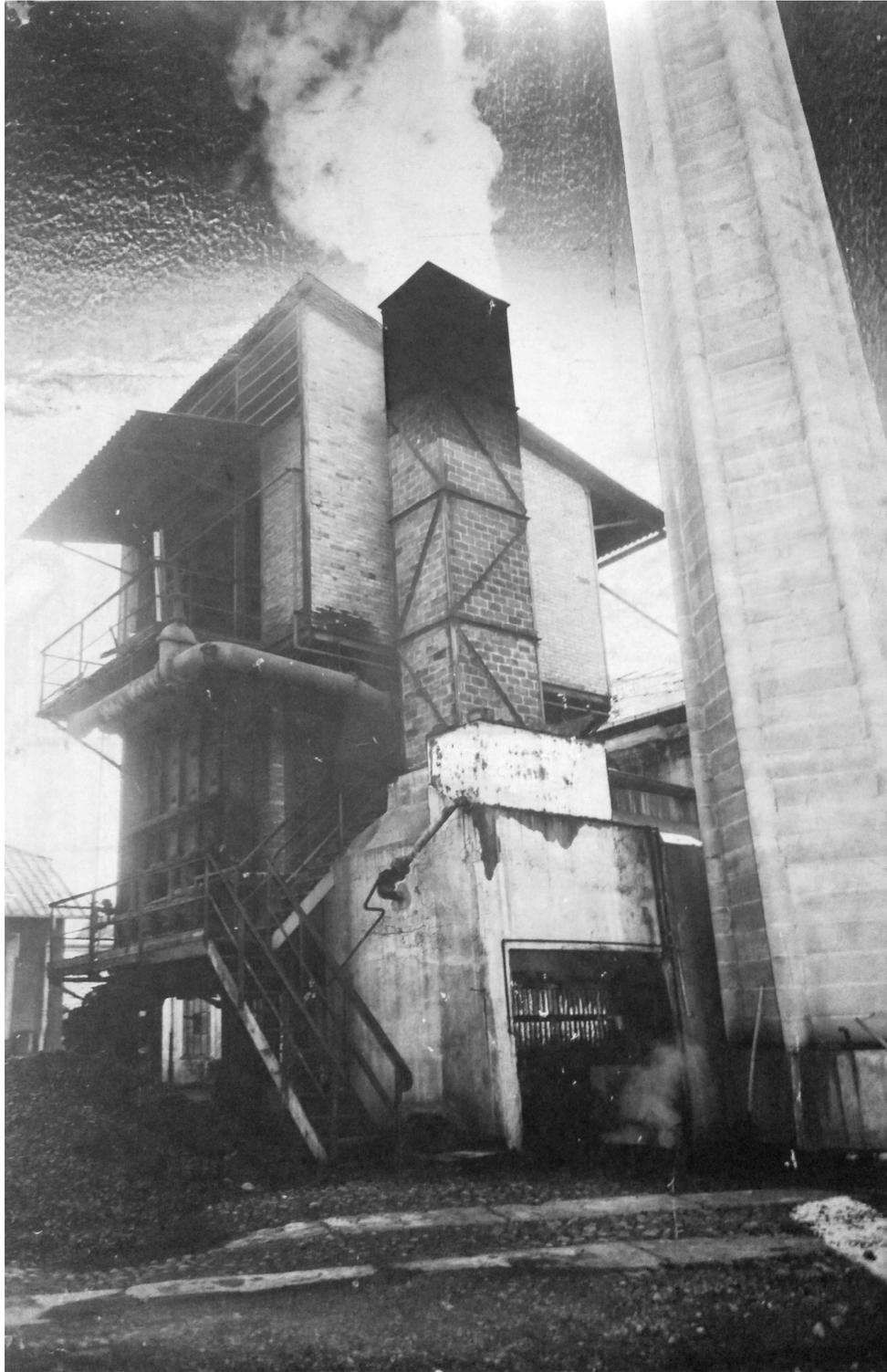
Fig. 54 Forno a quattro camere verticali a distillazione discontinua e camino - Capacità massima produttiva giornaliera di mc 4.500 a 4.000 kcal/mc, 1953-54.
