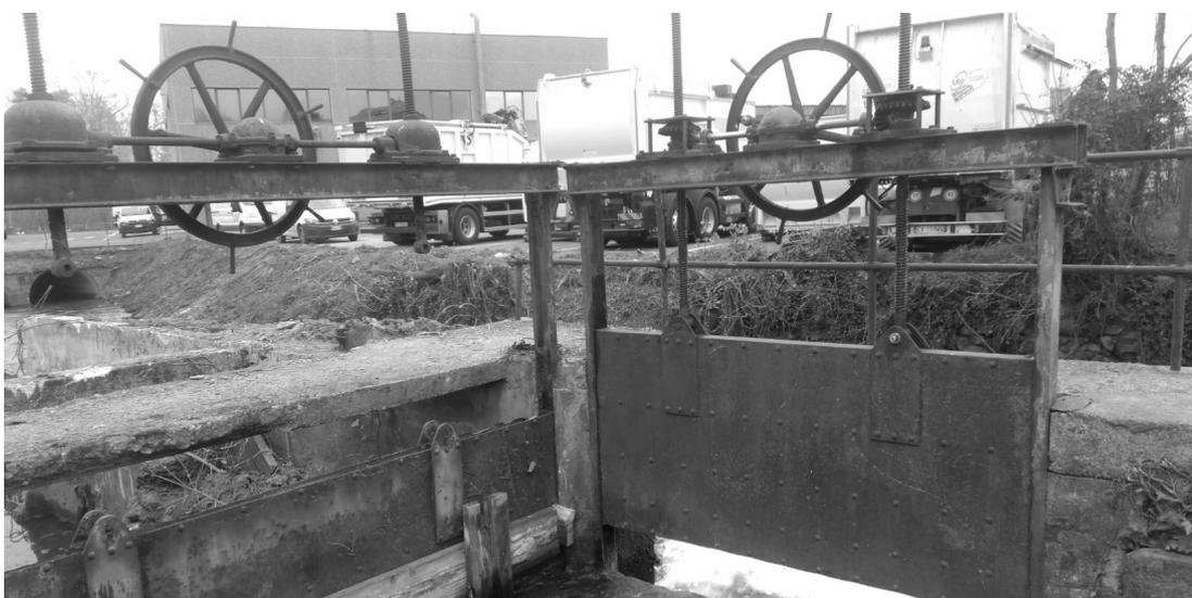
Fig. 15 Sistema di chiuse del Canale Moirano in prossimità dell'Acea (Foto 14)
