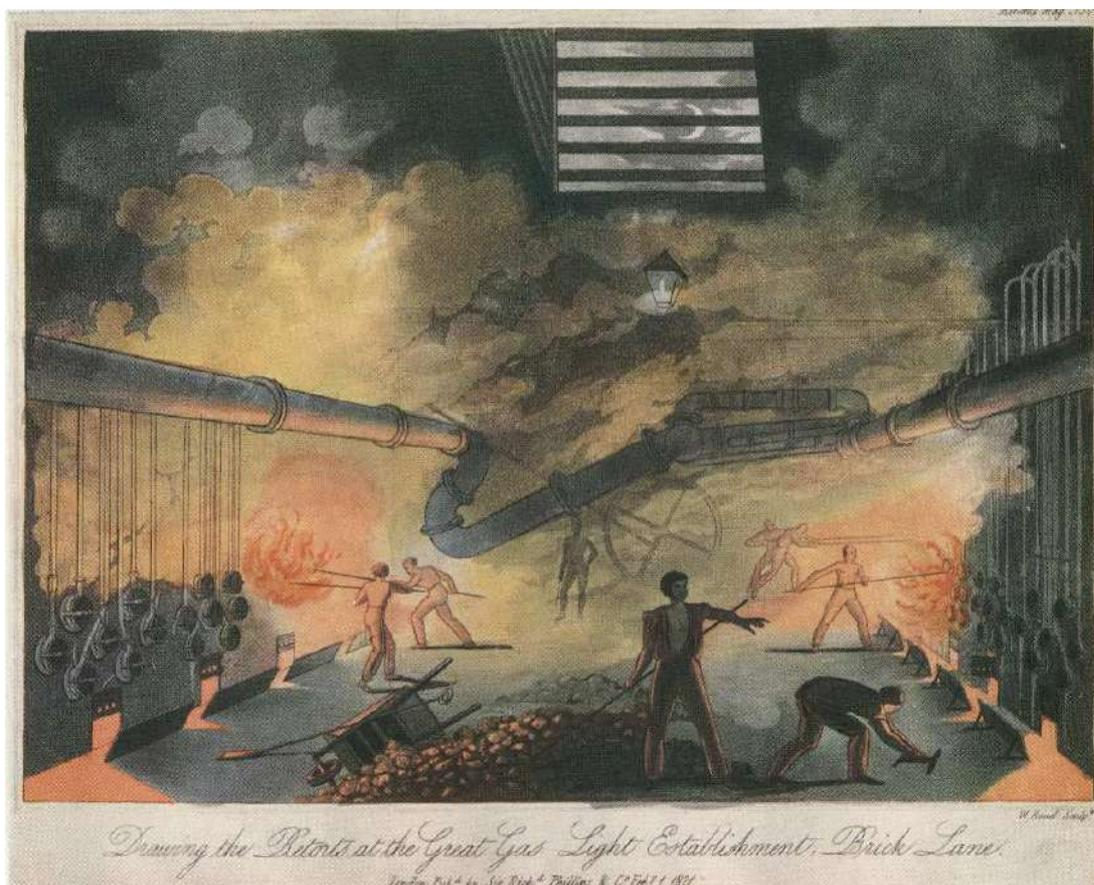
Fig. 3 Disegno dei forni e delle storte nello stabilimento del Gas Luce a Brick Lane, Londra 1821
