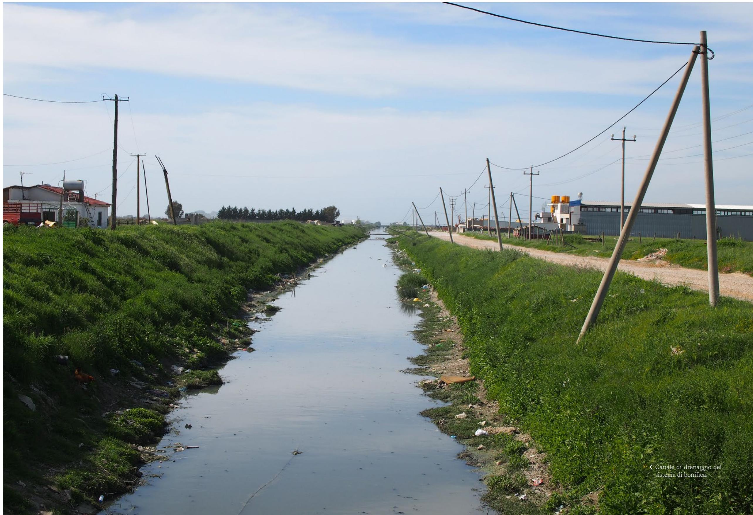
◀ Canale di drenaggio del sistema di bonifica.
