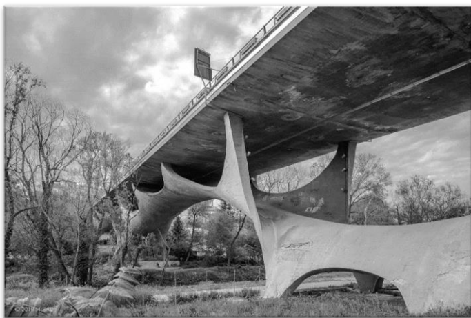
Figura 1.12 – Ponte sul Basento a Potenza.
