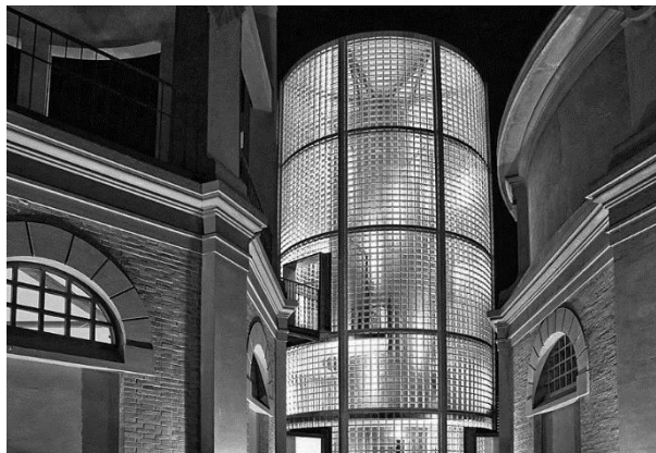
Figura 3.26 – Torre vetrata inserita ex novo, in adiacenza alla torre del serbatoio esistente, funge da corpo di distribuzione verticale.
