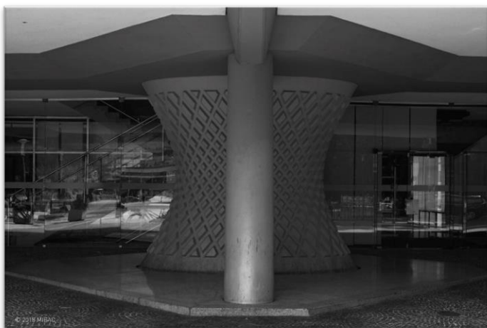
Figura 1.11 – Dettaglio di un pilastro in cemento armato del Palazzo della Ragione a Trento.
