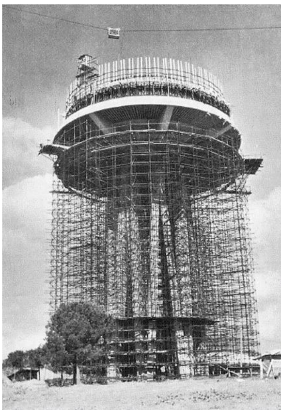
Figura 2.4 – Torre piezometrica dell'EUR in fase di costruzione.
