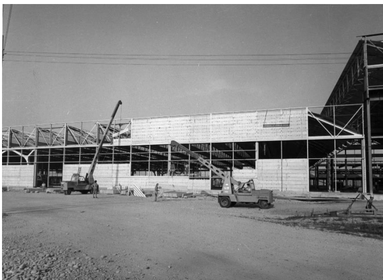
Figura 3.9 - Uno dei corpi di fabbrica in costruzione. Si evidenzia l'orditura metallica e il rivestimento in facciata, realizzato con pannelli prefabbricati.
