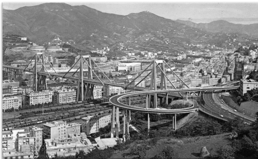
Figura 1.8 – Veduta complessiva del viadotto sul Polcevera a Genova.
