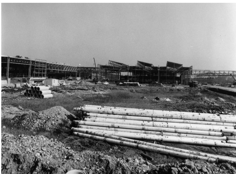
Figura 3.10 – I capannoni principali ad orditura metallica in fase di costruzione. Si evidenzia la copertura a shed, tipica dei capannoni industriali per garantire una buona illuminazione naturale.
