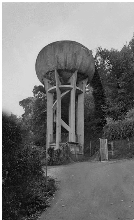
Figura 2.1 – Serbatoio pensile di Monte Porzio Catone.
