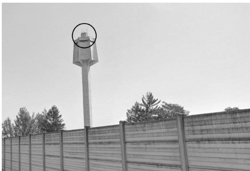
Figura 3.18 – Il serbatoio pensile visto da Via Borghetto. Si evidenzia in figura la presenza di vecchie strutture di supporto alle antenne.
