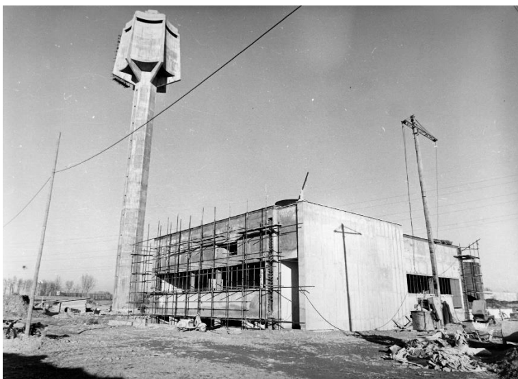
Figura 3.13 – Il serbatoio pensile. Nelle vicinanze, la cabina elettrica ad alta tensione in fase di costruzione.
