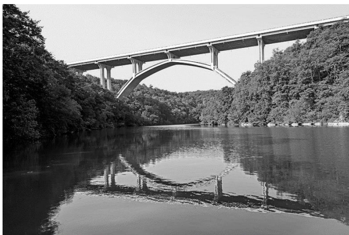
Figura 3.16 – Il ponte G. Romita sull'Arno per l'Autostrada del Sole, 1962-1964.
