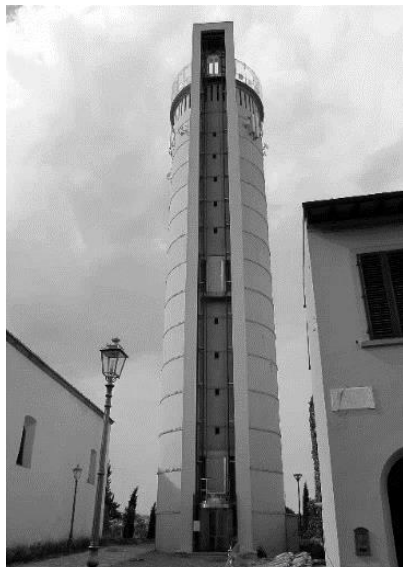
Figura 3.22 – Vista esterna della torre dei Chianti. L'opera è stata totalmente ristrutturata, per riadattarsi alle nuove funzioni. Esternamente, un ascensore ex novo, che conduce alla terrazza panoramica.
