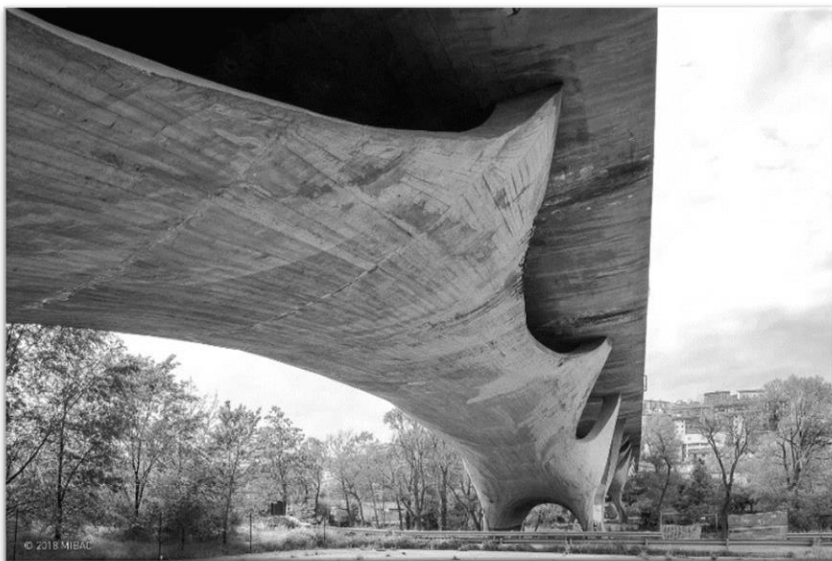
Figura 1.13 – Dettaglio della struttura in cemento armato del Ponte sul Basento a Potenza.
