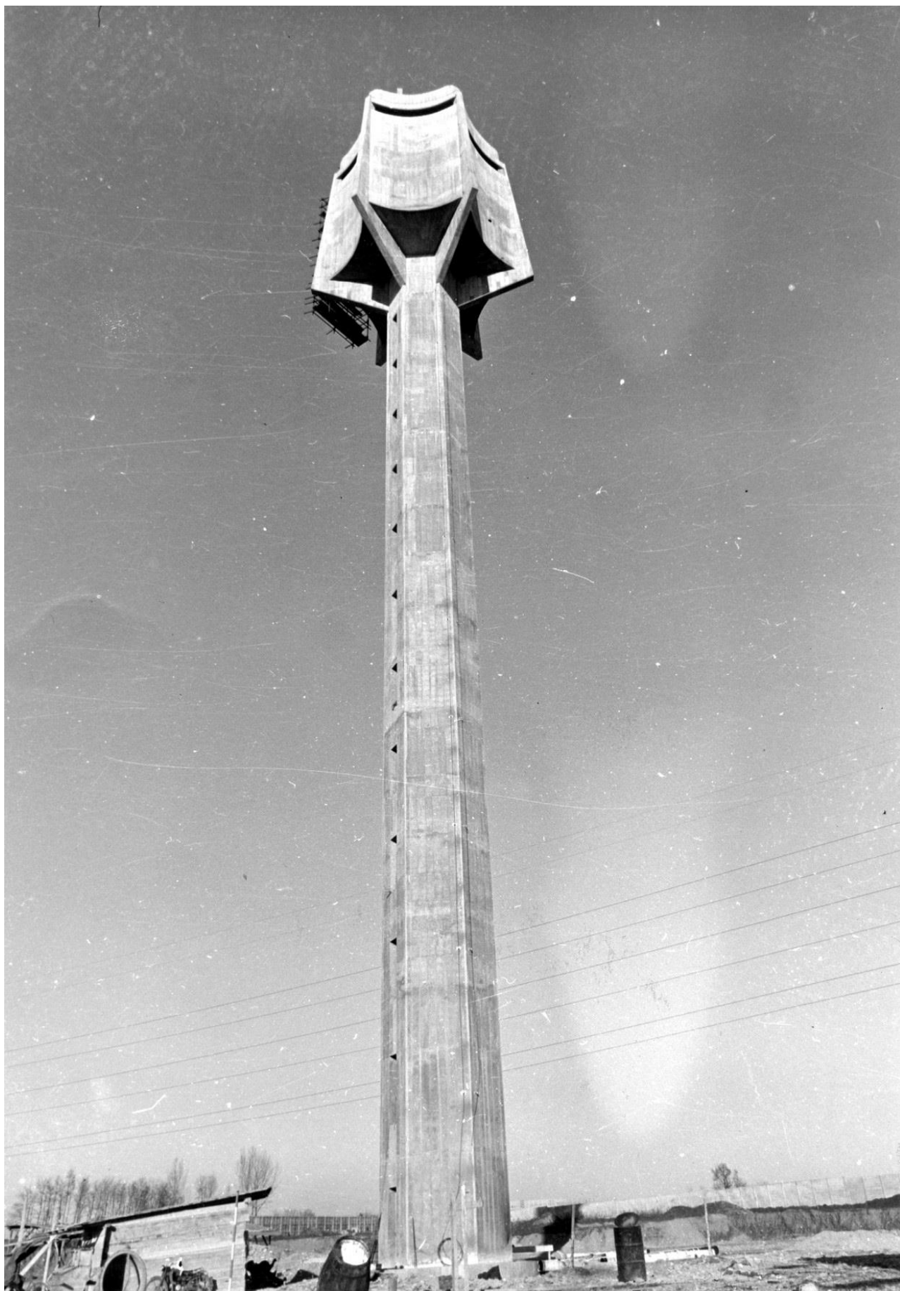
Figura 3.15 – Vista dell'opera di Silvano Zorzi. Il serbatoio pensile è in fase di ultimazione.
