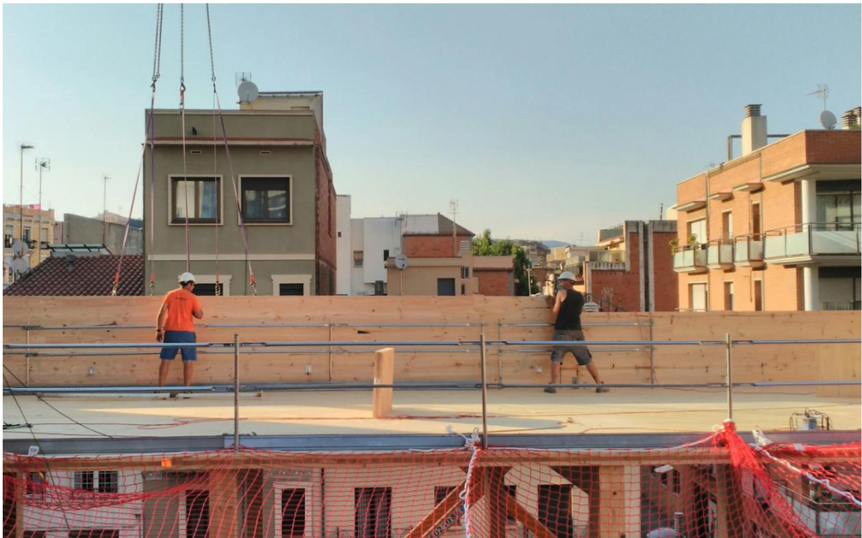
Fig. 53. Moduli prefabbricati assemblati in cantiere
