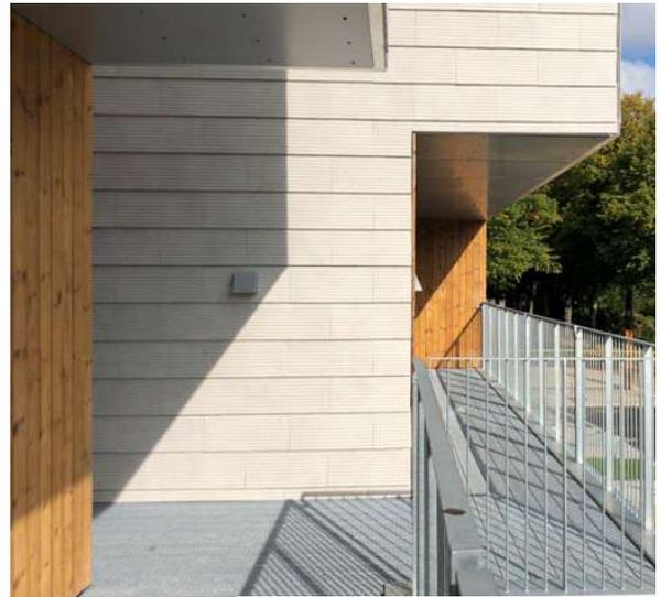
Fig. 40. Rivestimento in ardesia ceramica
