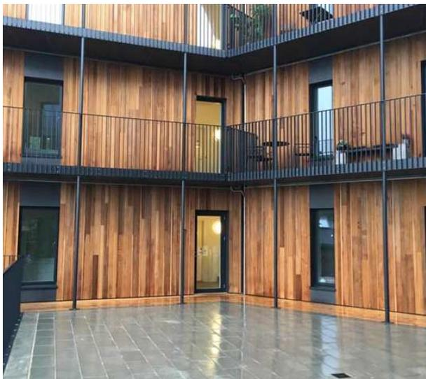
Fig. 39. Rivestimento in legno su corte interna
