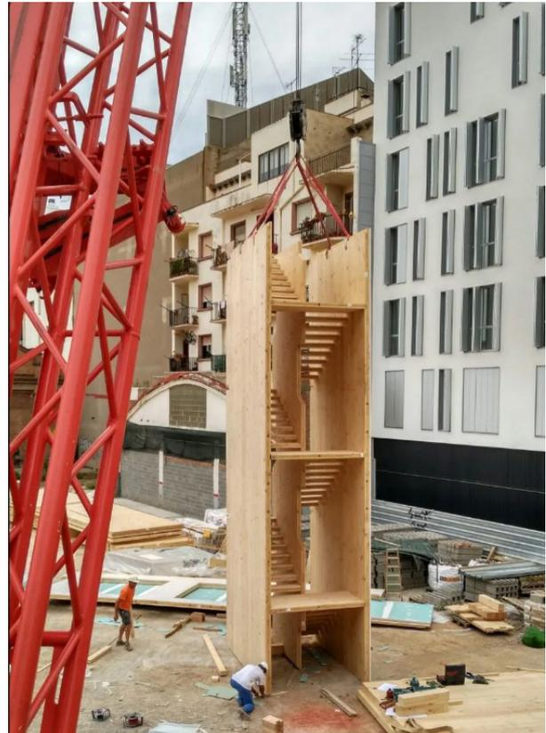
Fig. 52. Il modulo prefabbricato della scala
