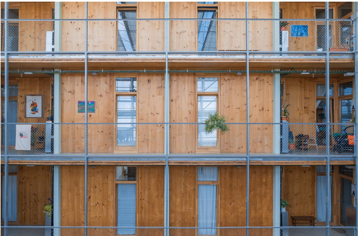
Fig. 50. Particolare dell'affaccio interno con il legno usato come materiale di rivestimento principale.
