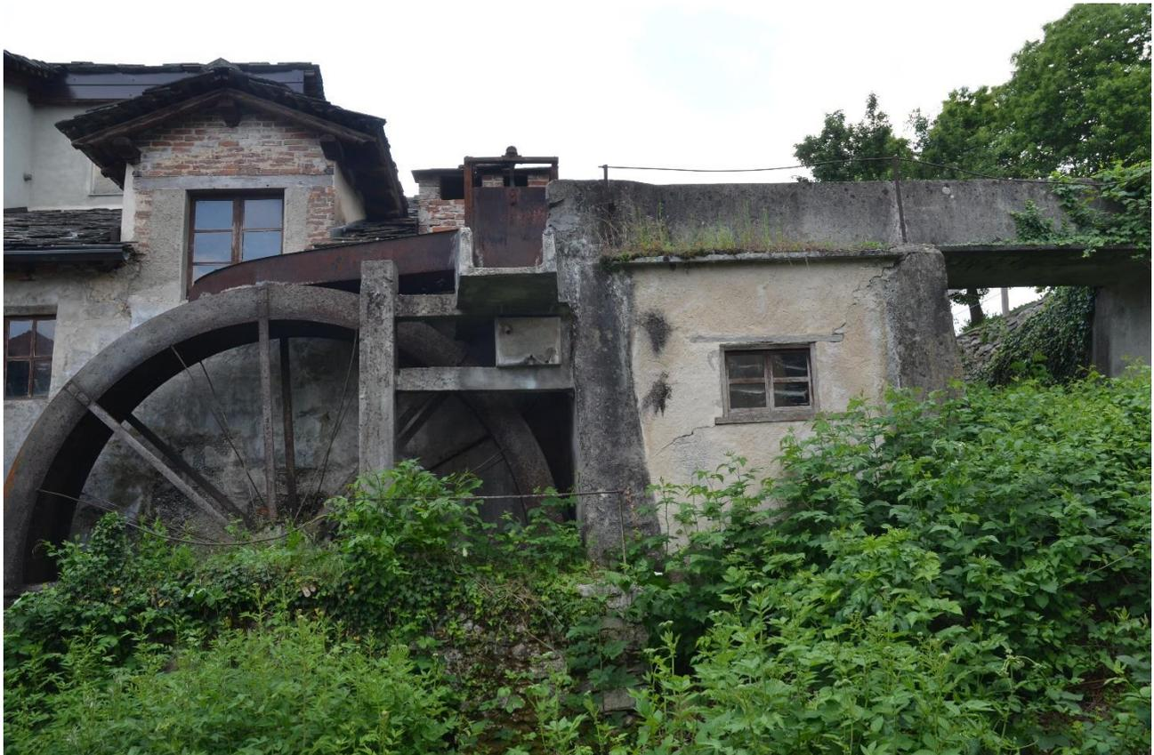
Fig. 2.13 – canale di adduzione e ruota idraulica
