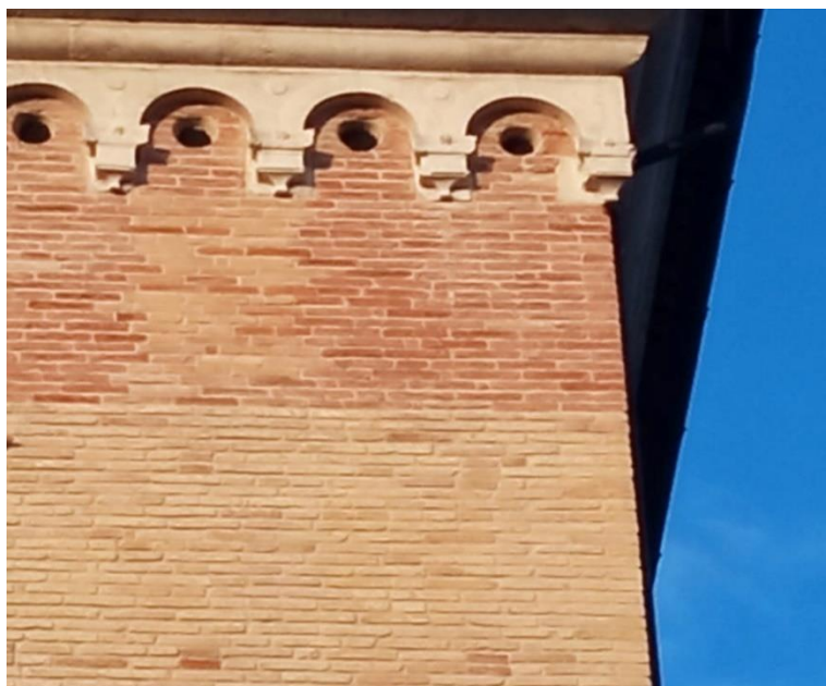
Fig. 166 – Stacco di colorazione tra il laterizio del blocco facciata e la successiva sopraelevazione. Fotografia dell'autore, 2022.
