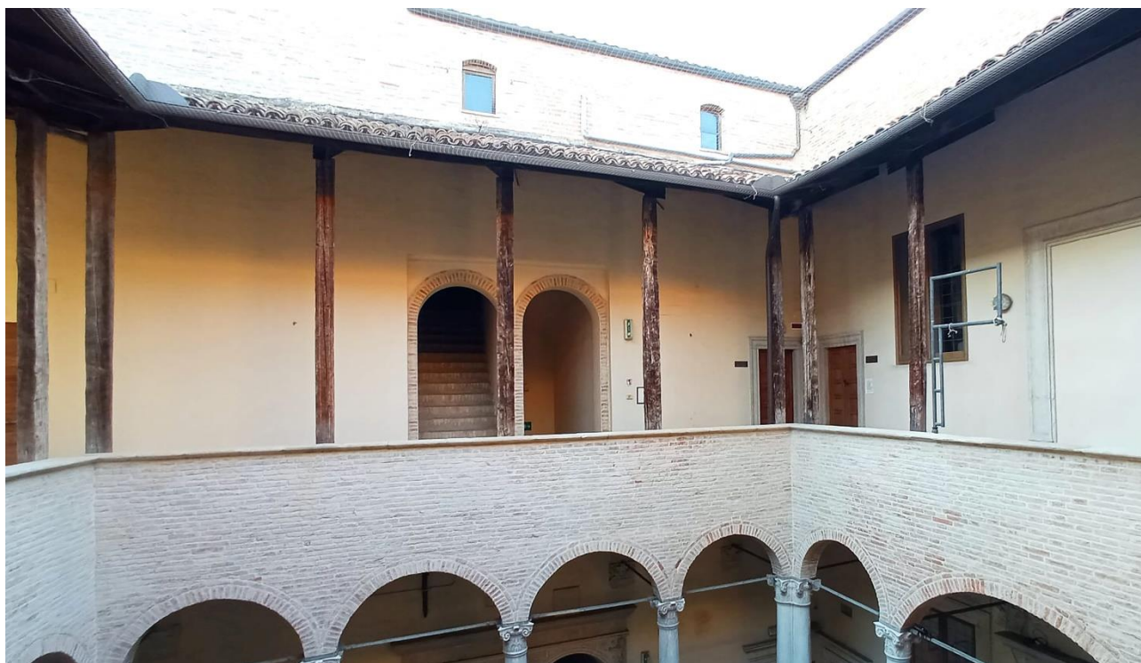
Fig. 188 – Soluzione lignea per il loggiato al secondo piano del cortile, 1930-1938. Fotografia dell'autore, 2022
