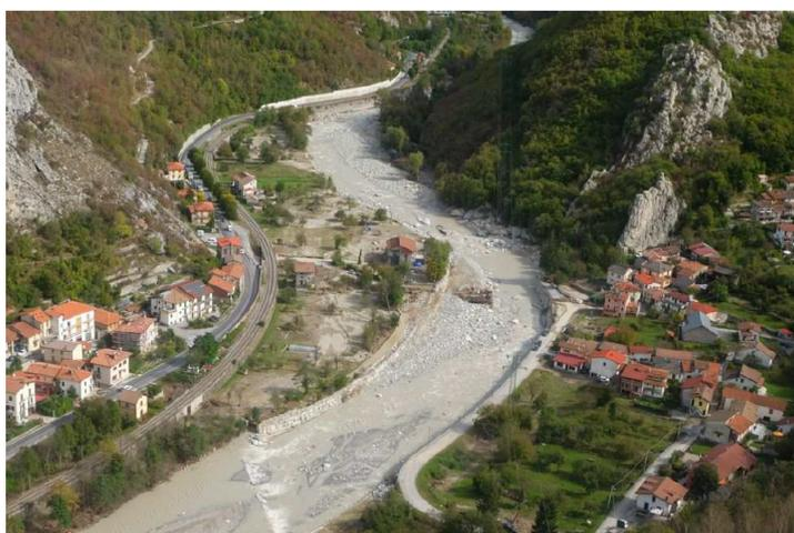
**Figura 2.17:** Collasso di un ponte a Ormea loc. Barchi (Rapporto evento alluvione 2-3 Ottobre 2020, ARPA Piemonte)
