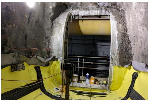
*Figura 2.15 - Impermeabilizzazione bench XP - segmental lining (Forrestfield Airport Link) [13]*
