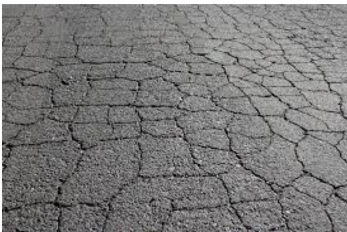
*Figura 7 - Rottura a fatica di una pavimentazione*
