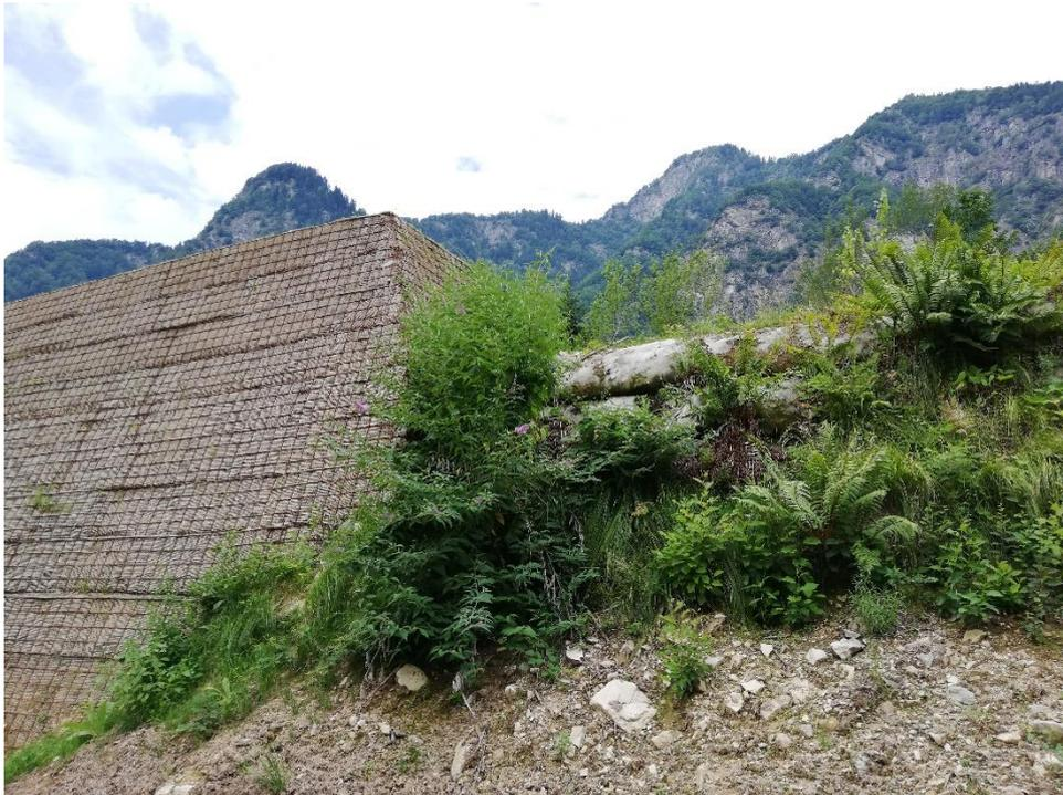
*Figura 62 – Differenza di altezza tra il rilevato preesistente (a destra) ed il prolungamento (a sinistra), vista da monte; foto scattata durante il rilevamento di campagna del 14 luglio 2022*
