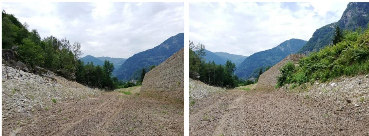
*Figura 69 – Rilevati paramassi in terra rinforzata, rilevato in materiale sciolto e vallo; foto scattate durante il rilevamento di campagna del 14 luglio 2022*
