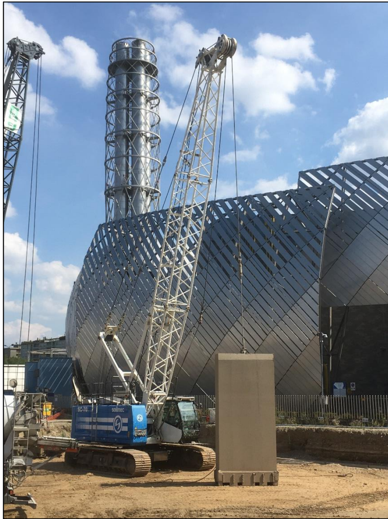
Figura 8.8: scalpello per diaframmi attaccato ad un sollevatore
