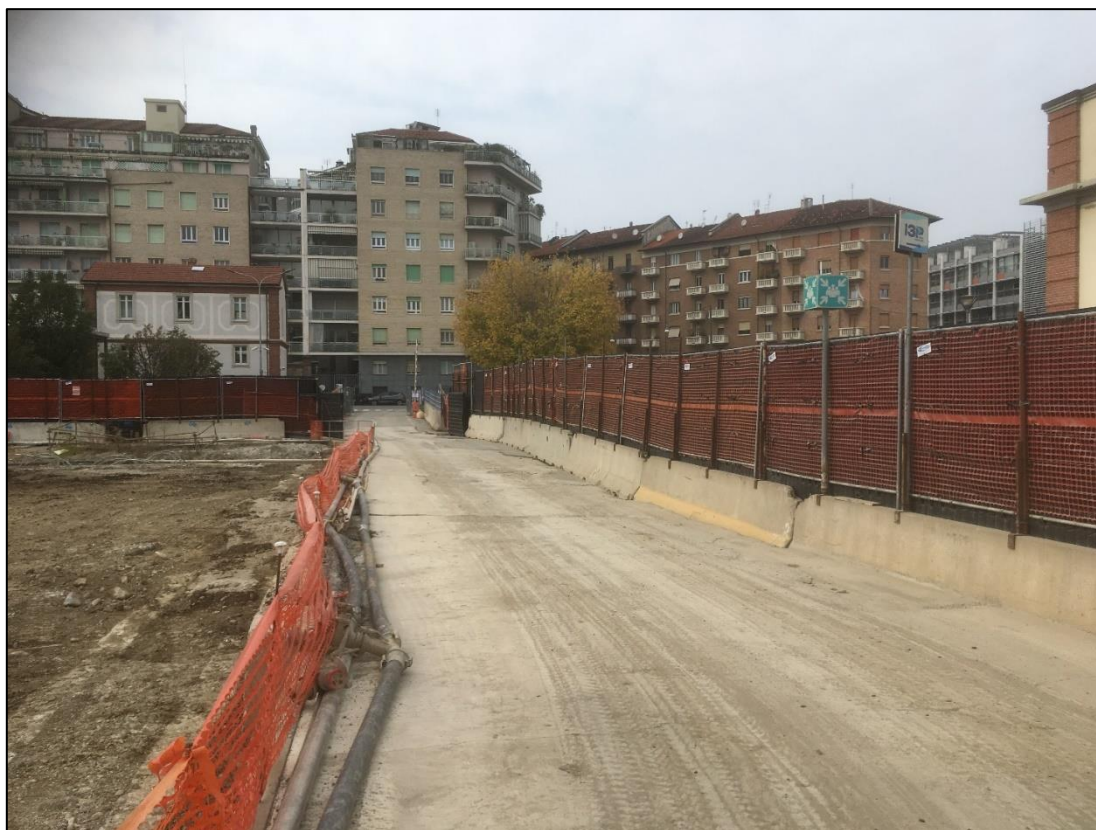
Figura 16.13: viabilità interna al cantiere e ingresso da Via Boggio
