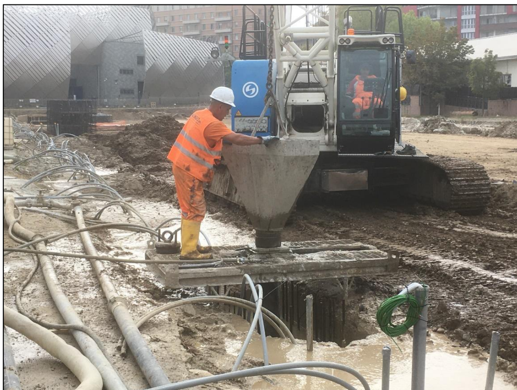
Figura 6.11: particolare dell'imbuto utilizzato per facilitare l'inserimento del calcestruzzo all'interno del tubo-getto
