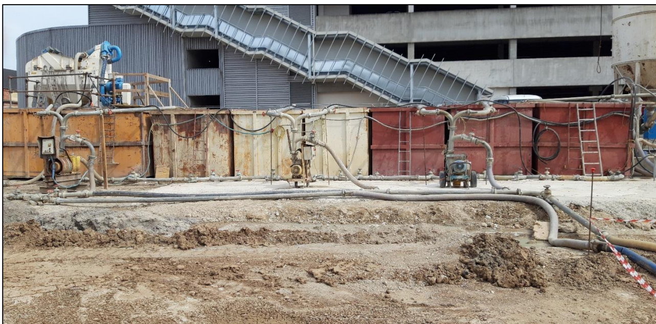
Figura 6.3: varie vasche contenenti le miscele fango bentonitiche, tubazioni del sistema a circuito chiuso e dissabbiatore (in alto a sinistra)
