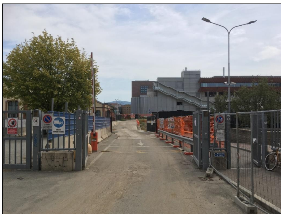
Figura 5.2: accesso al cantiere dal lato di Via Boggio
