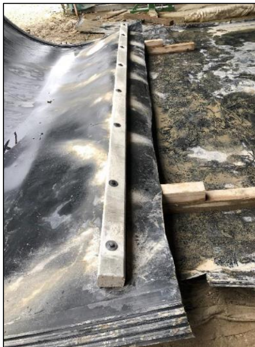
Figura 2.12: zavorra montata sul telo di HDPE
