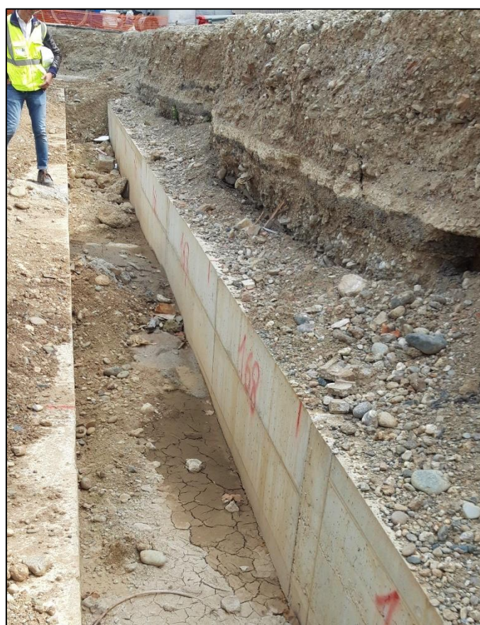
Figura 16.8: dettaglio cordoli guida con scritte le numerazioni dei vari setti
