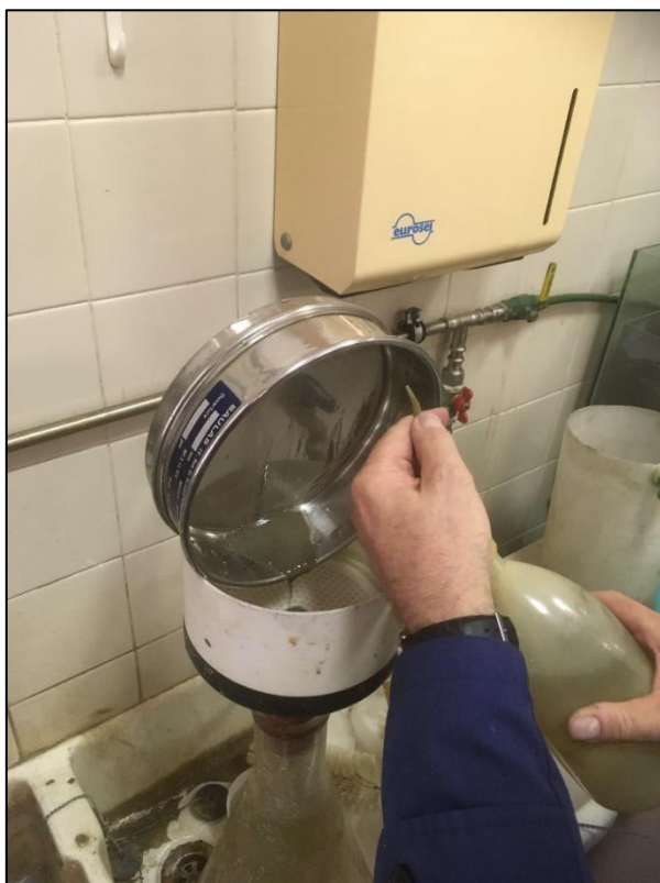
Figura 11.11: raccolta della sabbia sul filtro
