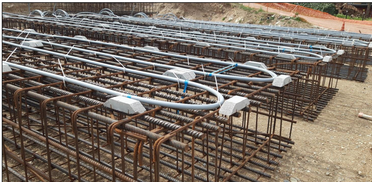
Figura 16.6: dettaglio gabbie di armatura
