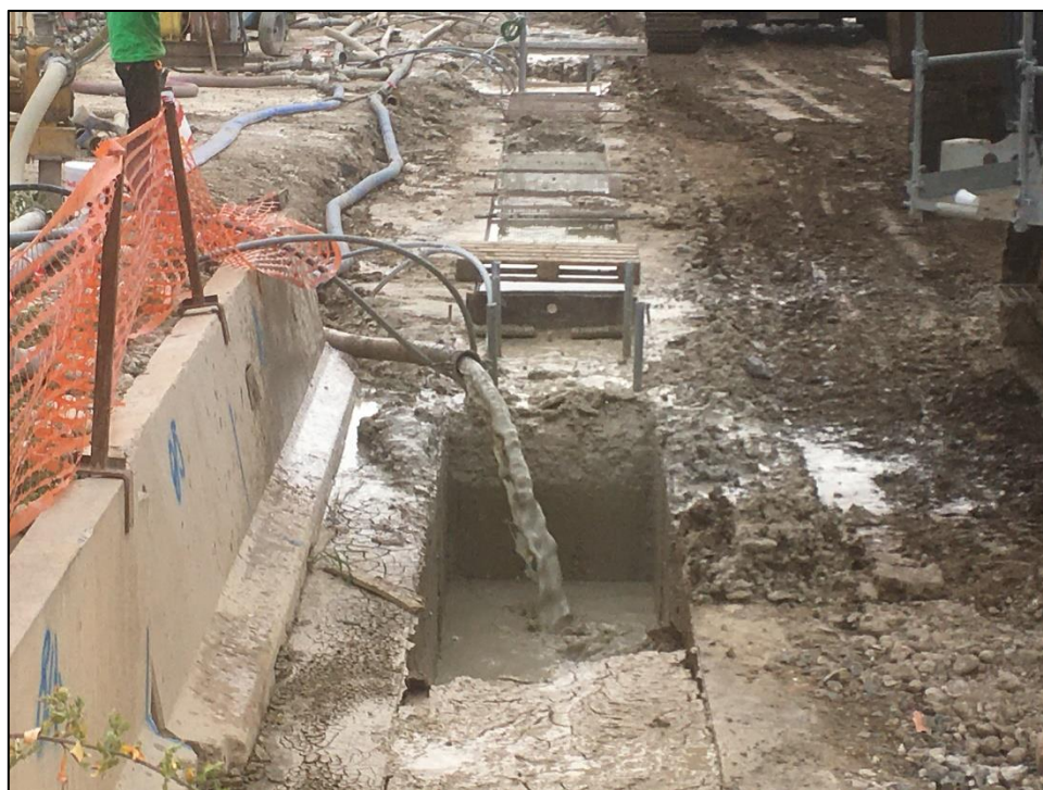
Figura 6.2: iniezione della miscela fango bentonitica per mantenere la stabilità dello scavo
