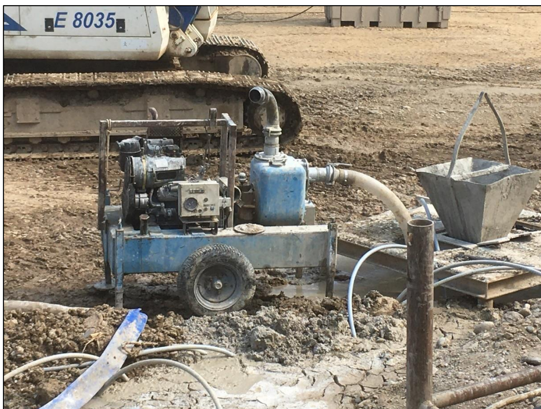
Figura 6.10: pompa utilizzata per prelevare lo slurry durante l'iniezione del calcestruzzo
