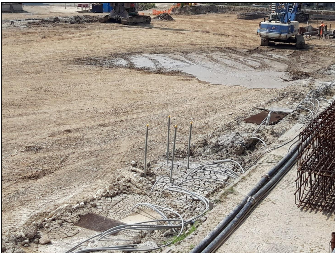
Figura 6.13: tubi da cross-hole, per test geofisici
