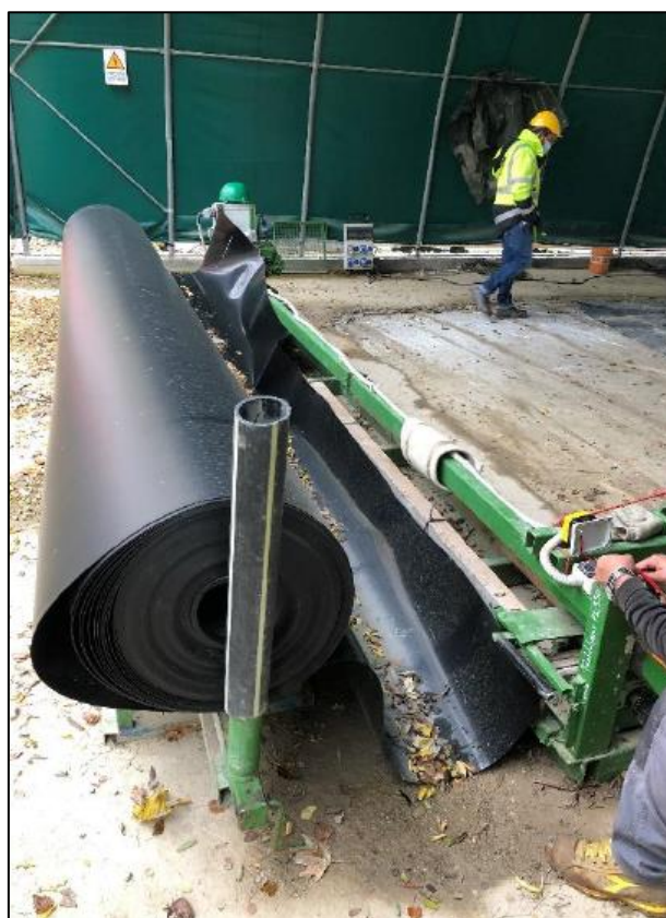
Figura 2.10: telo in HDPE pronto per l'operazione di saldatura dei giunti
