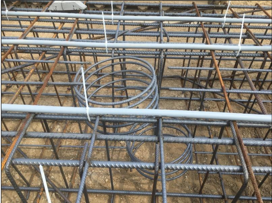
Figura 4.1: alloggiamenti tiranti nella gabbia metallica
