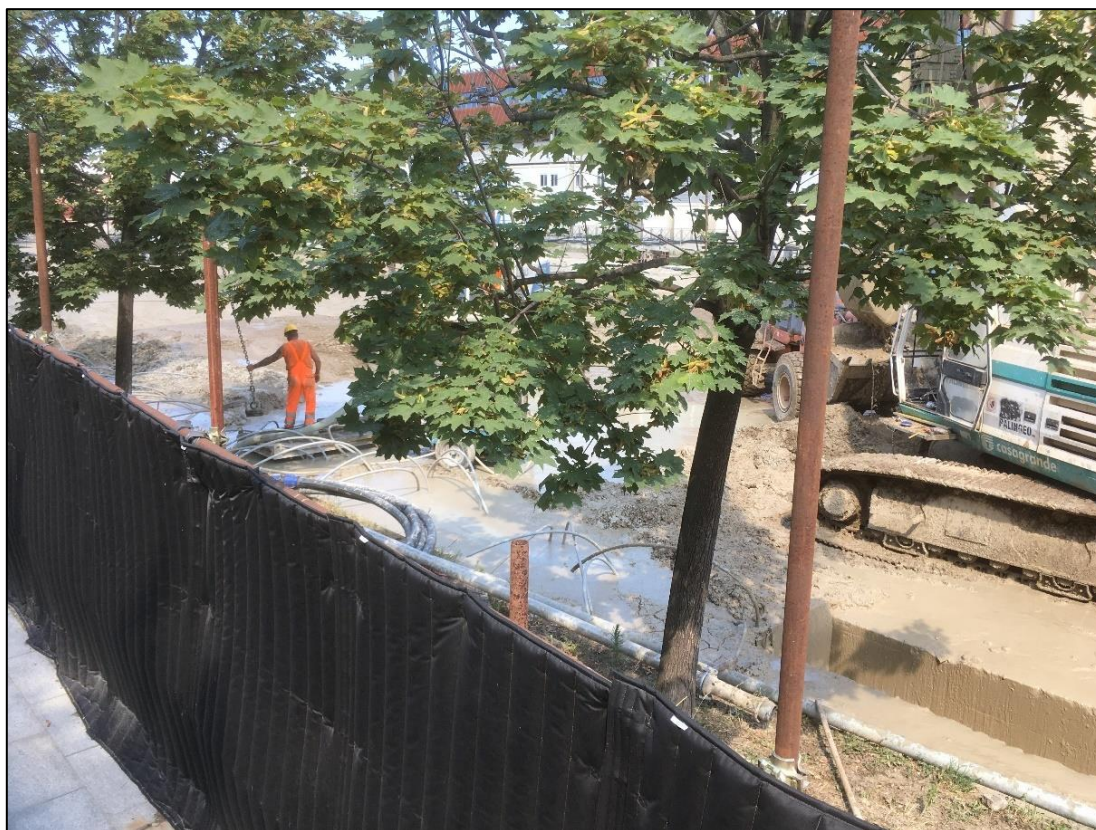
Figura 5.3: in basso è possibile vedere l'uso di recinzioni con funzione di antirumore e antipolvere
