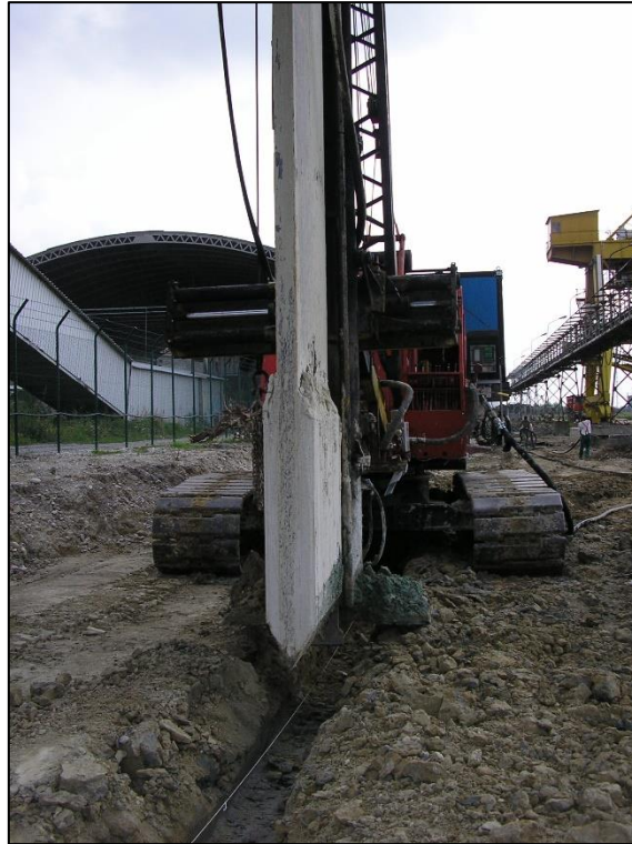
Figura 2.6: inserimento dell'elemento prefabbricato nello scavo
