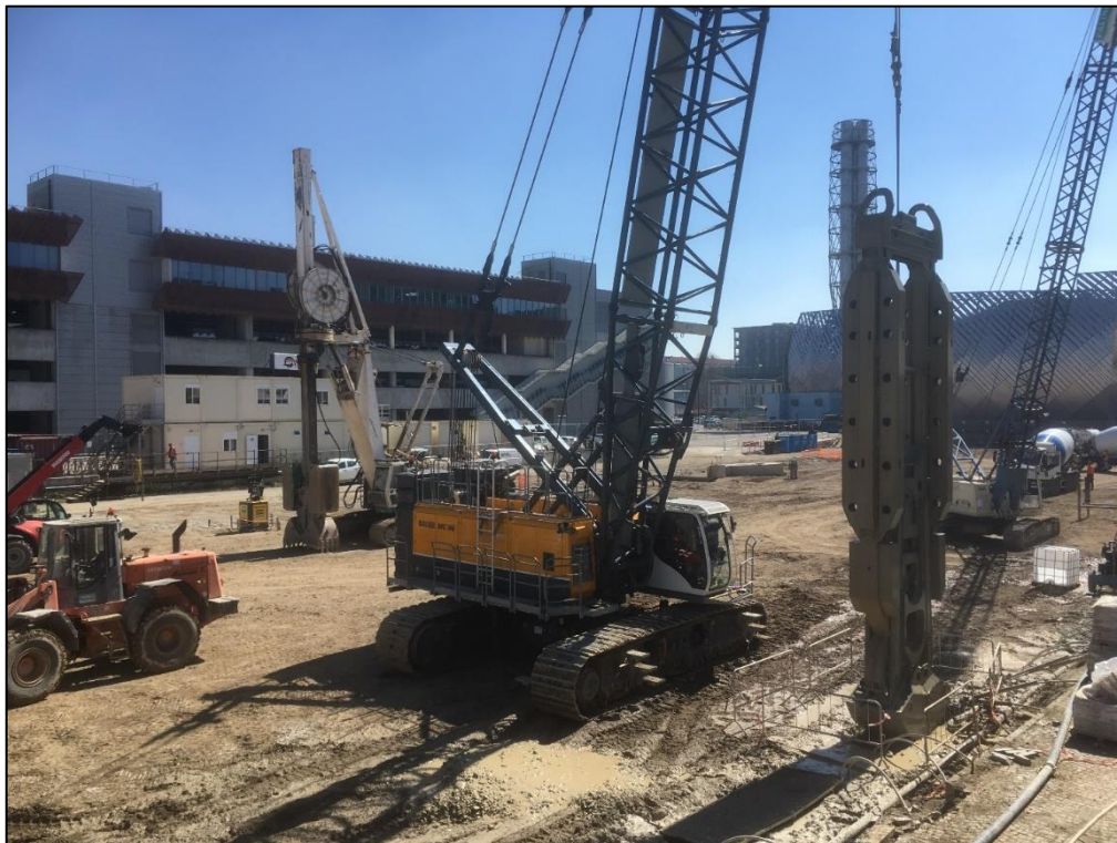
Figura 16.4: Bauer MC 96 con benna da 24 tonnellate
