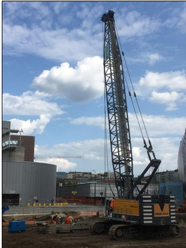
Figura 8.4: Bauer MC 96 a funzionamento semi-idraulico con le funi (con benna da 24 tonnellate a terra)
