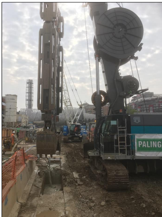
Figura 6.1: operazione di scavo del diaframma strutturale tramite l'ausilio di benna mordente
