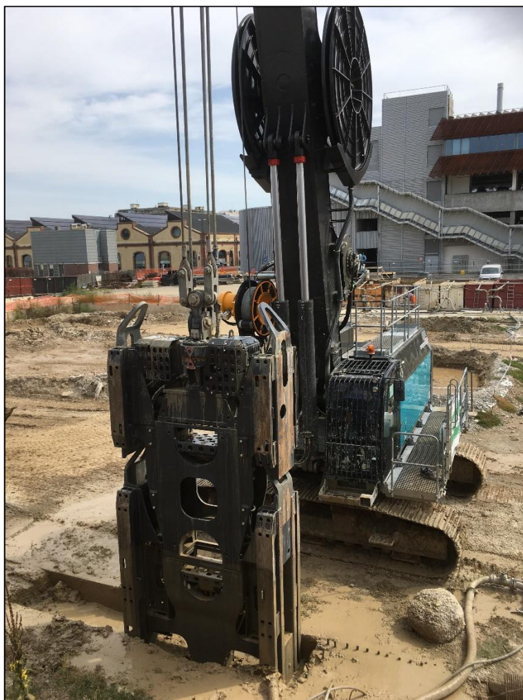
Figura 16.5: Casagrande B300 con benna da 24 tonnellate
