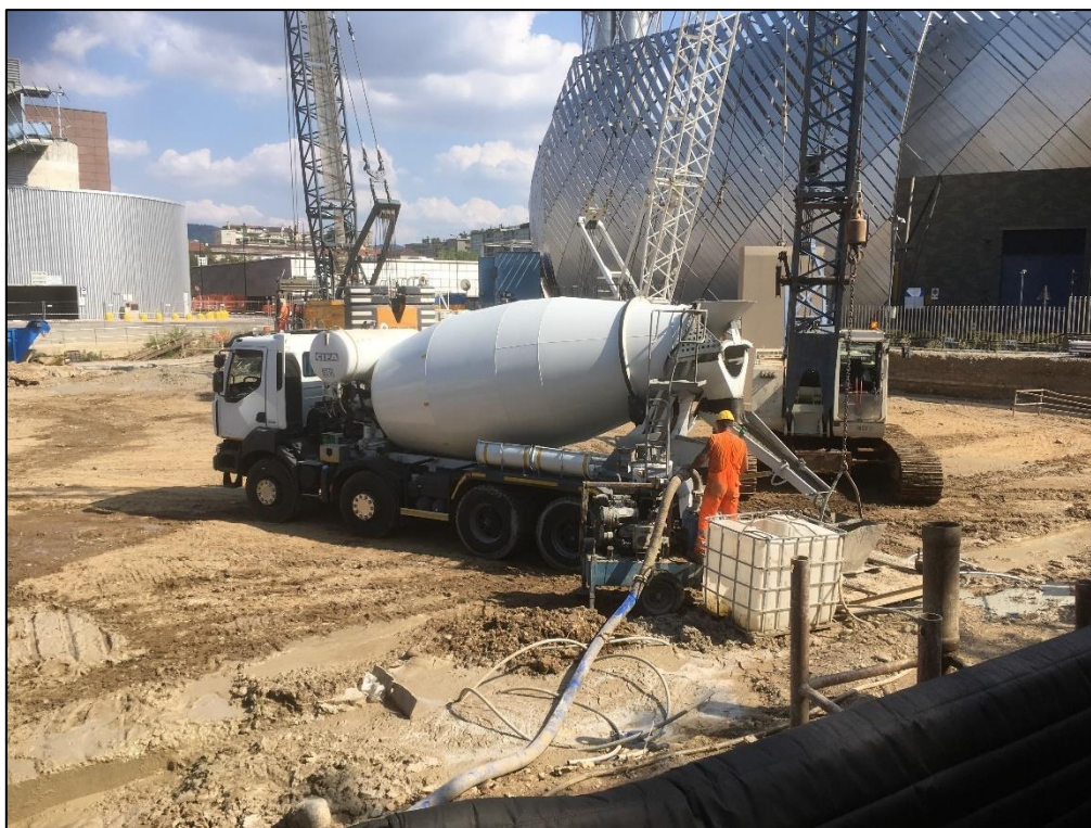
Figura 6.8: iniezione del calcestruzzo tramite betoniera
