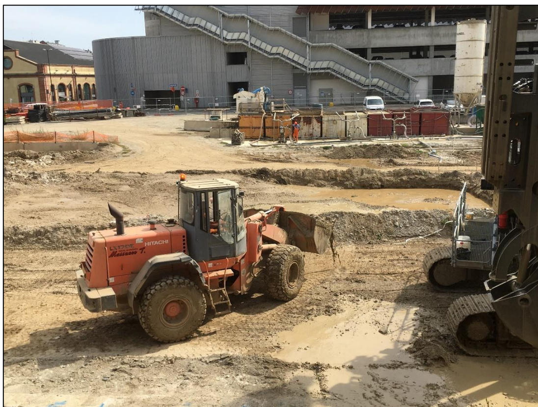
Figura 9.3: operazione di scaricamento del materiale dalla pala caricatrice nella vasca di decantazione
