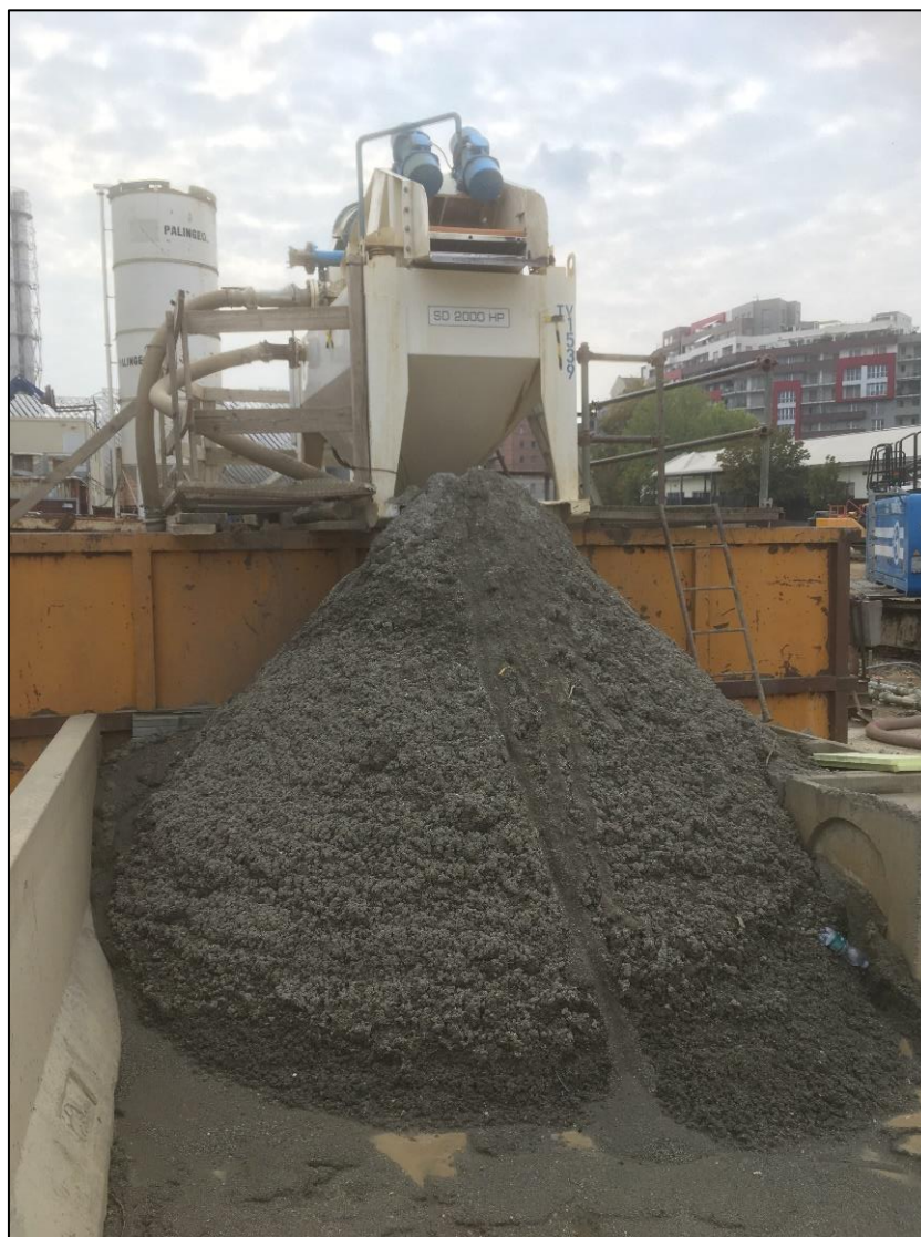
Figura 11.1: deposito di sabbia ottenuto dopo il processo di dissabbiatura della miscela fango bentonitica
