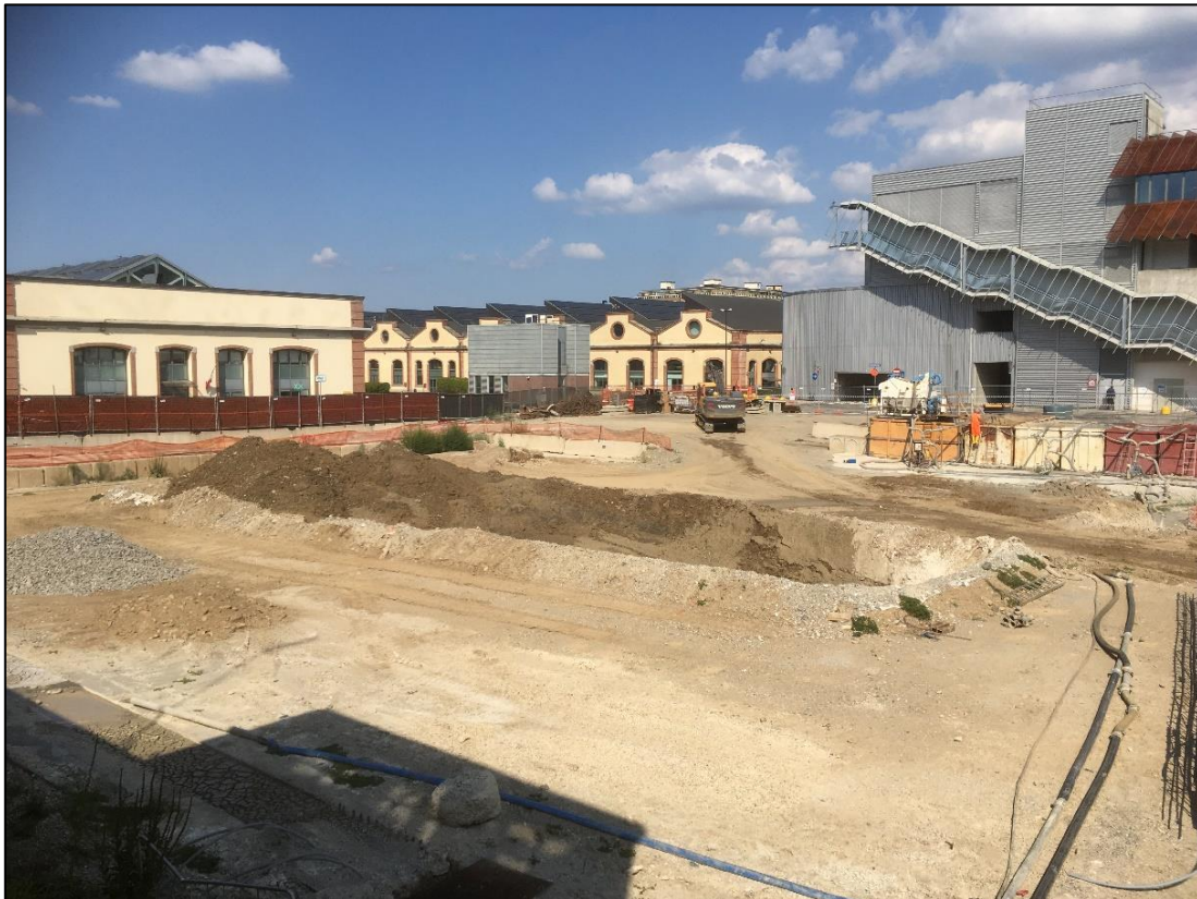
Figura 9.1: localizzazione della vasca di decantazione (deposito fanghi) all'interno del cantiere in esame
