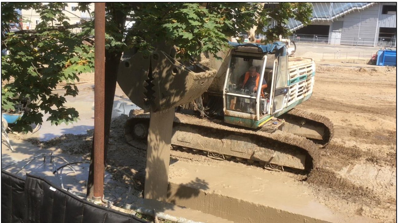
Figura 6.5: estrazione del terminale laterale
