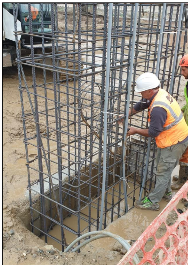
Figura 6.7: inserimento della gabbia di armatura all'interno del foro
