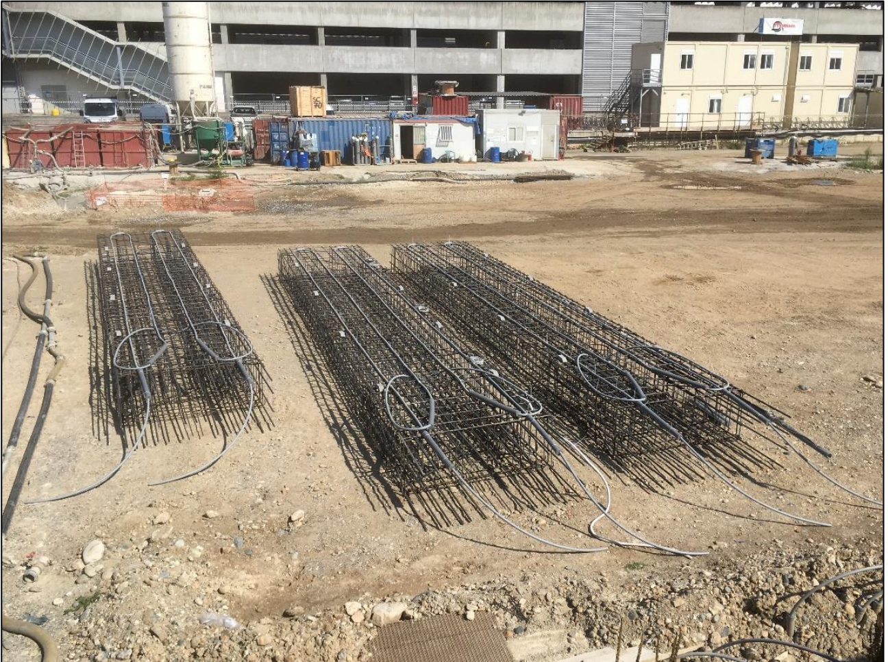
Figura 6.6: tre gabbie di armatura pronte per essere inserite all'interno dello scavo
