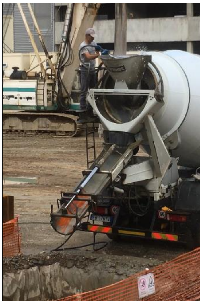
Figura 16.10: operazione di lavaggio della betoniera dopo aver effettuato il getto di calcestruzzo
