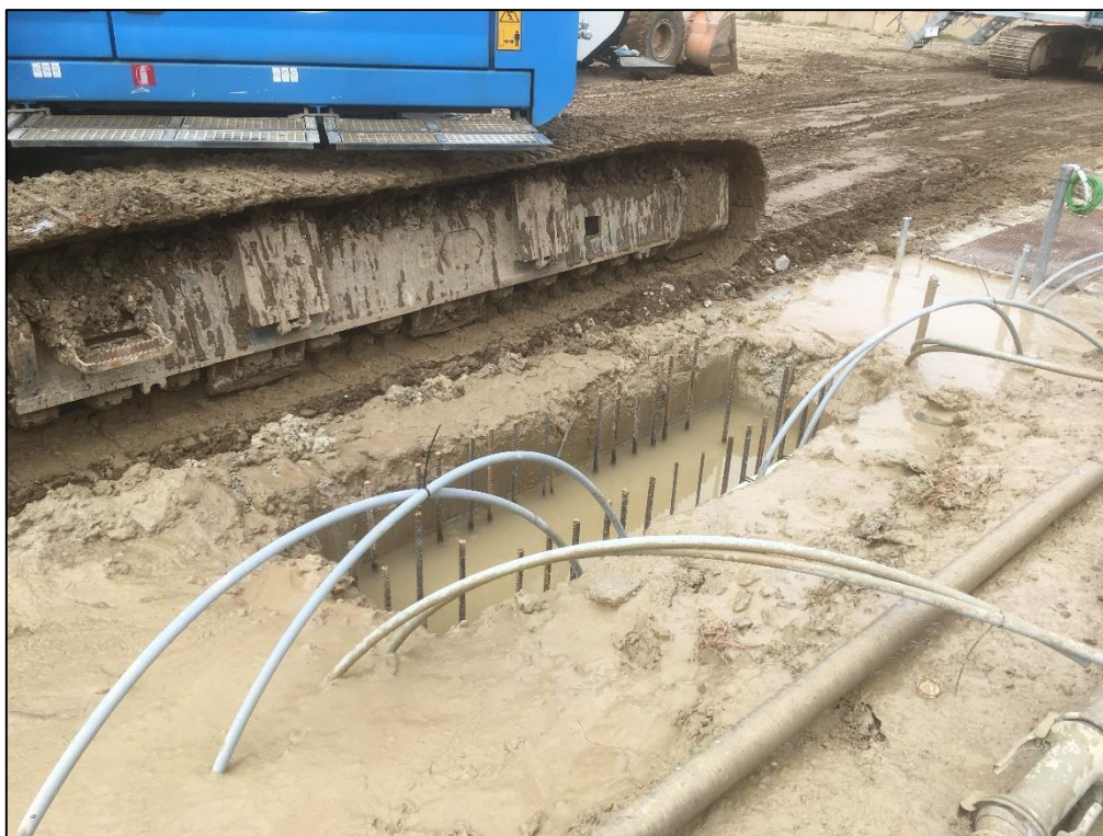
Figura 16.7: gabbia di armatura immersa completamente nello slurry all'interno dello scavo
