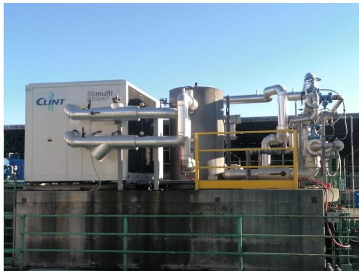
Fig. 54- Chiller per il raffreddamento e riscaldamento del refluo in alimento alle n.2 vasche biologiche.
