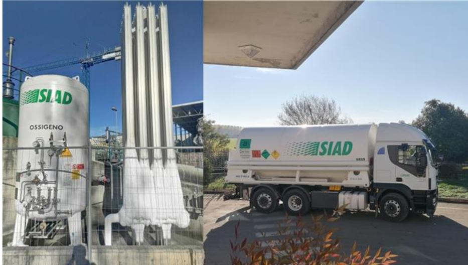
Fig. 58- Serbatoio di stoccaggio dell'ossigeno liquido e sistema di rigassificazione (sx), autotrasportatore ossigeno liquido (dx) di SIAD.
