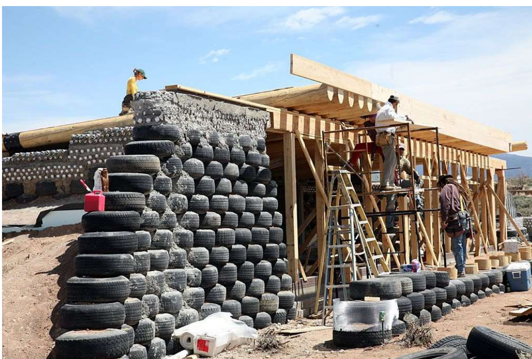
Figura 17 Autocostruttori all'opera nella realizzazione di una earthship . Fonte: blog.bcasa.it
