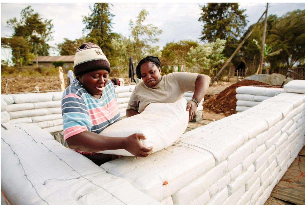
Figura 42 Autocostruzione di una casa a Nakuru, in Kenya, con l'impiego dei sacchi di terra per la realizzazione dei muri. Fonte: www.designindaba.com .
