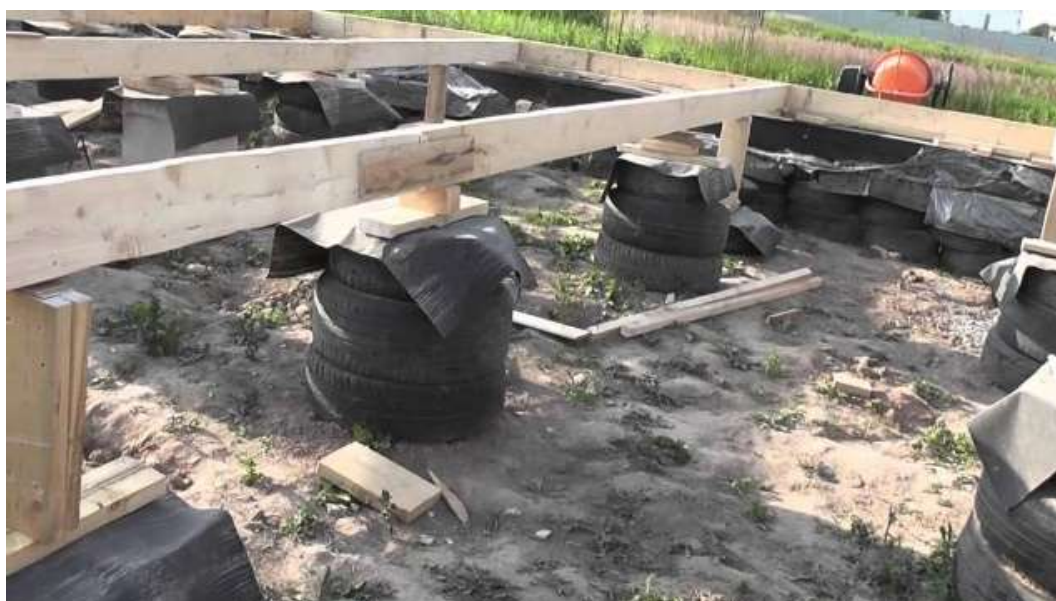
Figura 32 Esempio di fondazioni realizzate con pneumatici usati come casseri a perdere. Fonte: itn.decorexpro.com .
