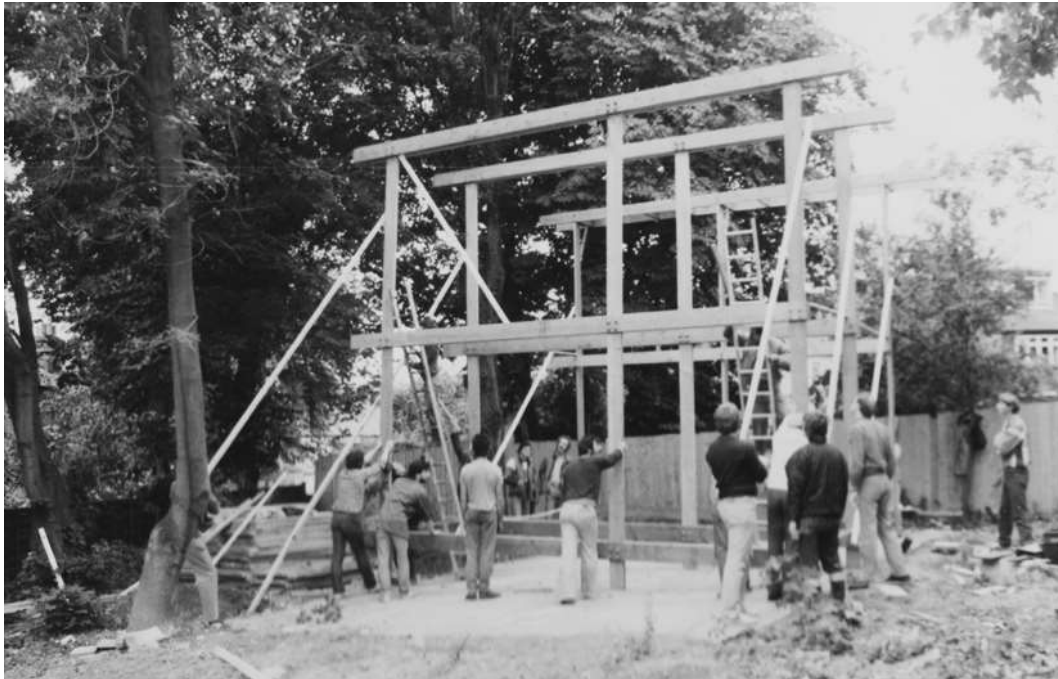
Figura 12 Sollevamento manuale di una struttura realizzata con il metodo Segal. Fonte: memberevents.aaschool.ac.uk .
