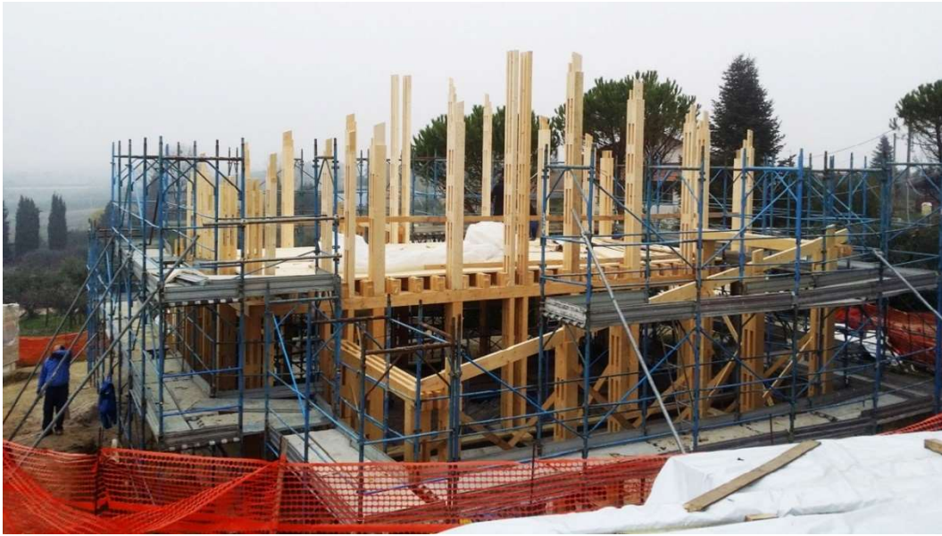
Figura 21 Cantiere in autocostruzione a Rimini, promosso da A.R.I.A. familiare. Fonte: www.centropagina.it .
