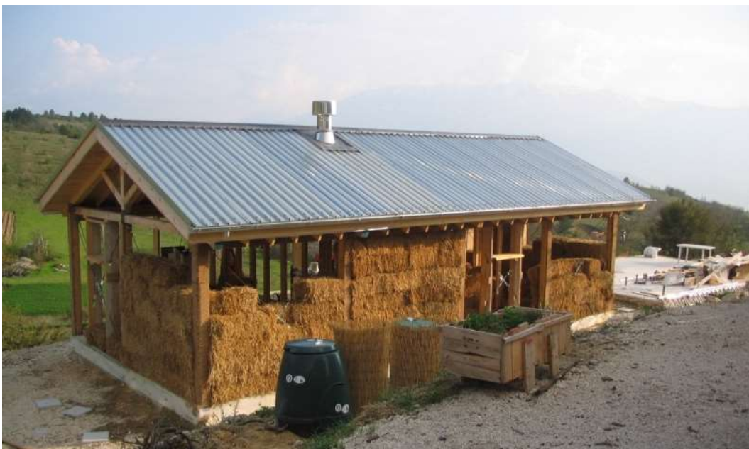
Figura 22 Progetto EVA (Eco Villaggio Autocostruito) realizzato a Pescomaggiore (AQ) dopo il terremoto de L'Aquila. Fonte: www.teknoring.com .
