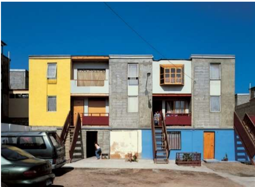
Figura 20 Progetto residenziale a Quinta Monroy, Cile, prima (in alto) e dopo (in basso) il completamento realizzato dagli abitanti in autocostruzione. Fonte: www.archdaily.cl .
