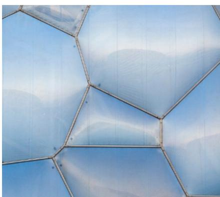
L'etilene tetrafluoroetilene è definito "vetro del futuro"<sup>[96]</sup> poiché presenta caratteristiche di trasparenza assimilabili a quelle del vetro, ma ha una densità decisamente inferiore. La manutenzione richiesta dai pannelli realizzati con questo materiale è piuttosto irrilevante, in quanto si tratta di un
