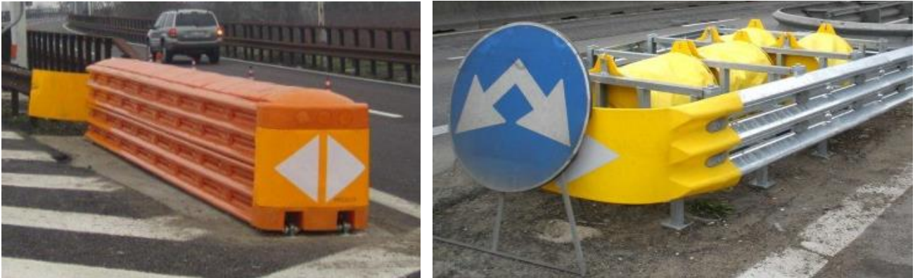
Figura 2.15: Attenuatore d'urto di tipo inerziale a sinistra e di tipo cinetico nell'immagine di destra
