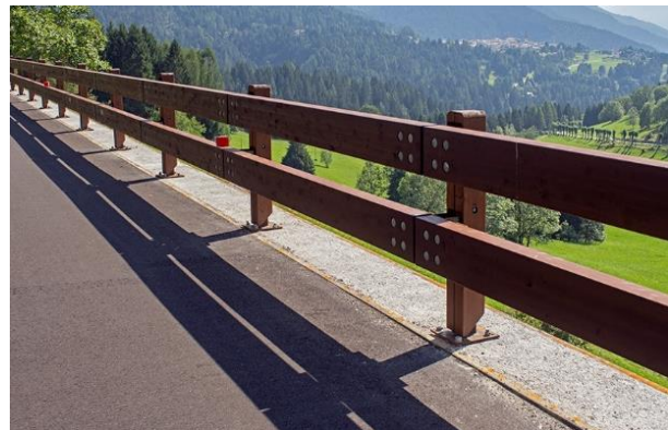
Figura 2.10: Barriere miste acciaio-legno
