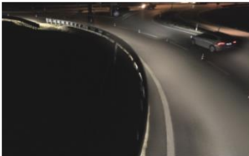
Figura 5.23: Sistema Guardled posto in prossimità di una rotatoria
