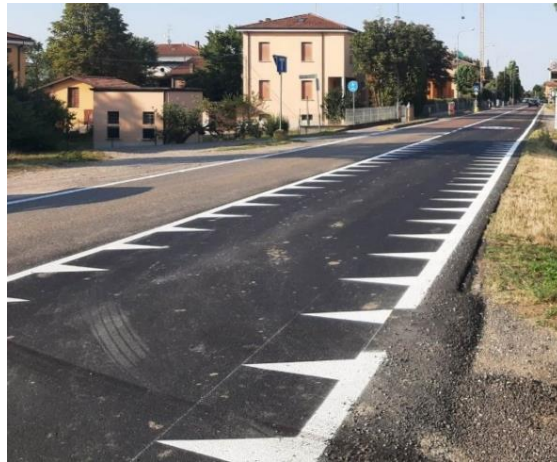
Figura 5.21: Segnaletica orizzontale Denti di Drago
