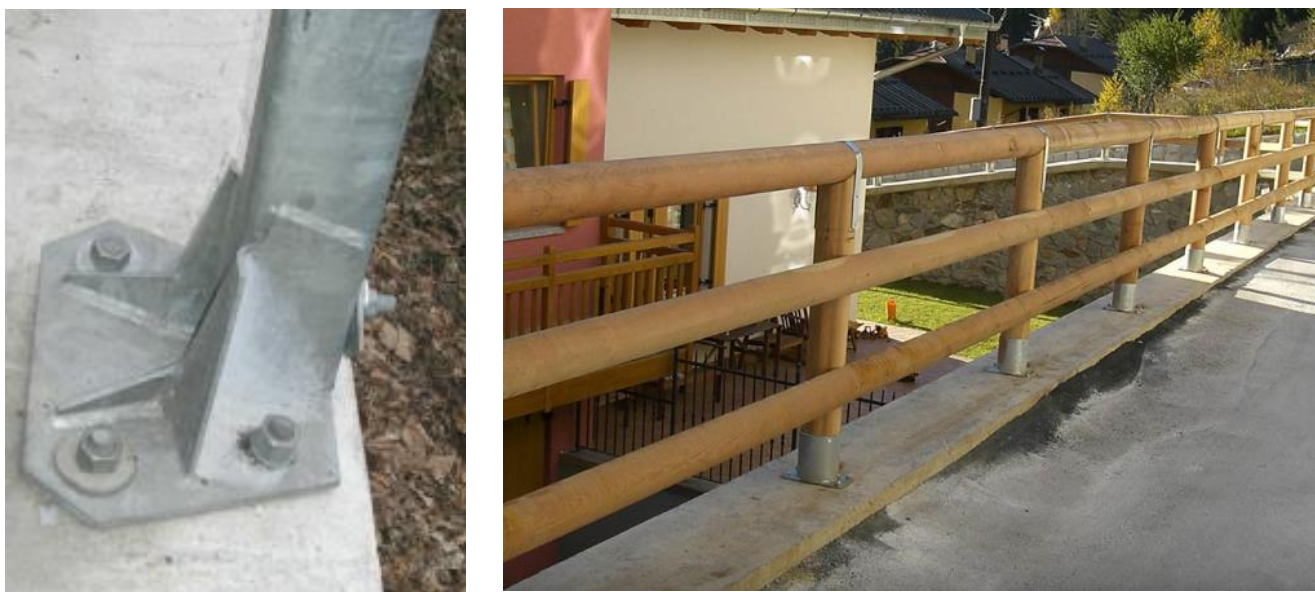
Figura 2.2: Particolare di montanti pullonati al suolo
