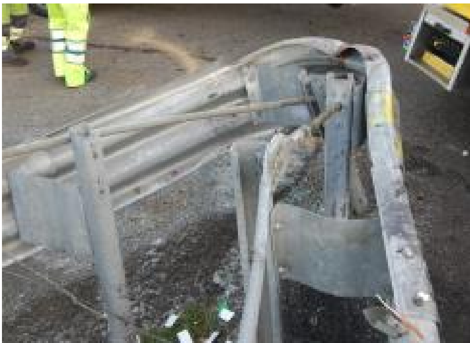
Figura 4.4: Dettaglio rinforzo in metallo cuspid
