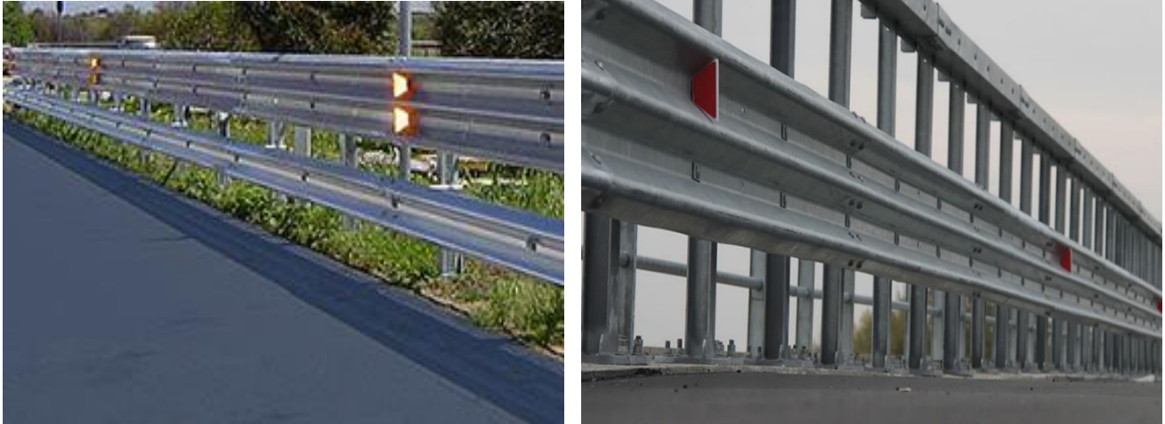
Figura 2.3: Esempi di barriere metalliche
