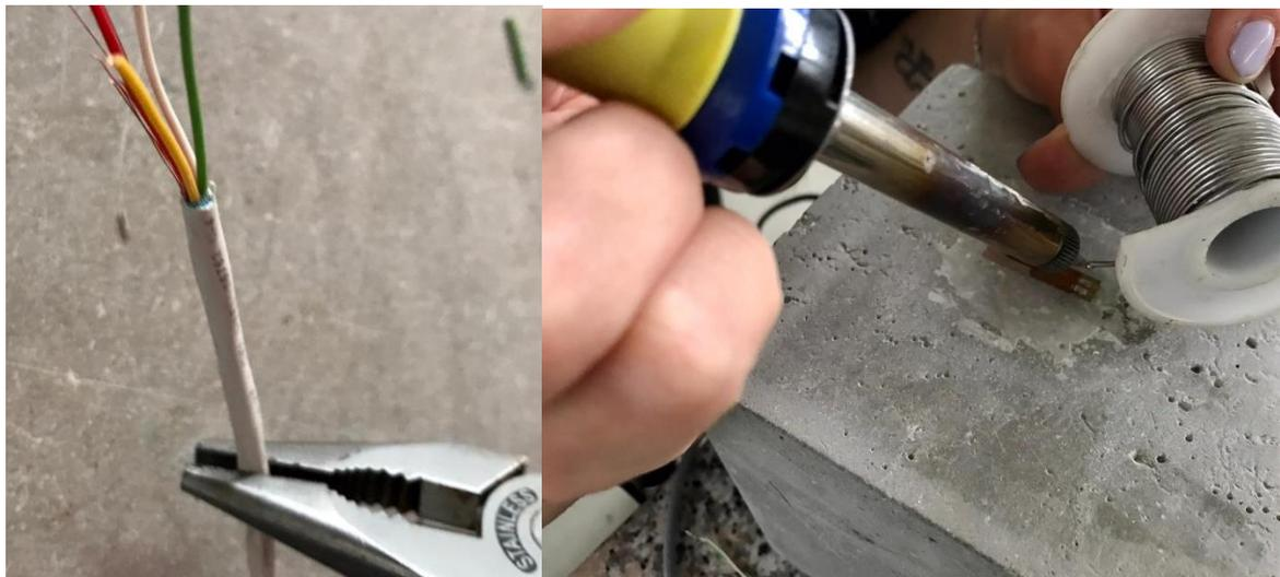
**Figure 4.13** : Procedura di saldatura cavi
