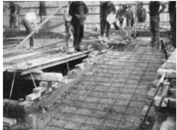
*Figura 12- Crollo campanile di San Marco (sinistra) ricostruzione rampe in cemento armato (destra)*
