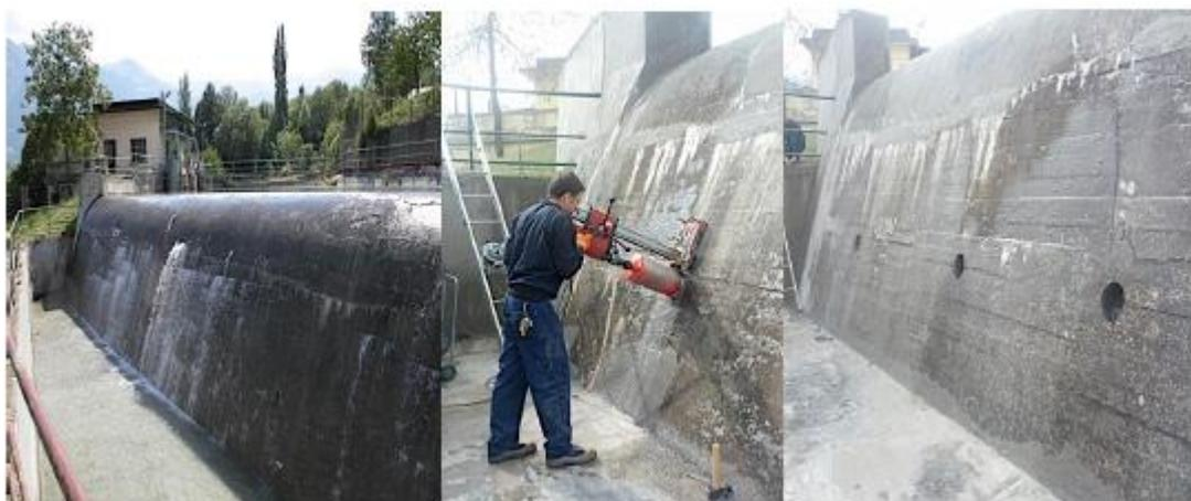
Figura 33 - Paramento diga prima e dopo il carotaggio
