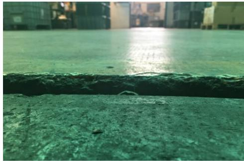
*Figura 2.16 Criticità pavimentazione dell'ex stabilimento di Rivoli*
