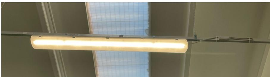
*Figura 3.9 Dettaglio proiettore led e presa blindosbarra Orbassano Plant*
