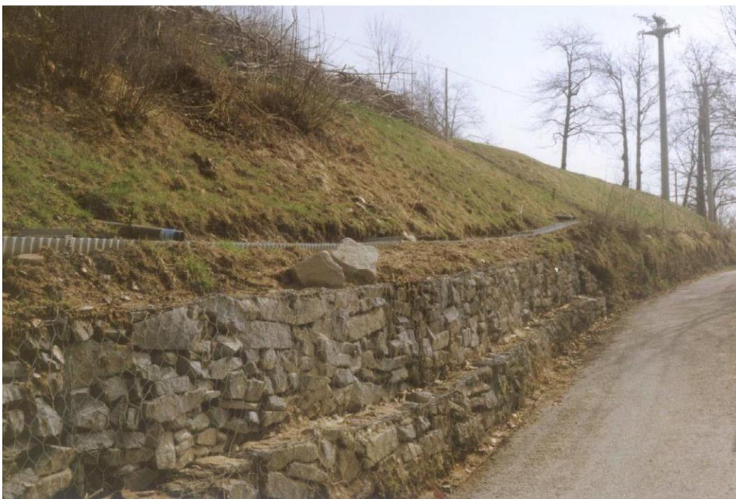
*Figura 22 Interventi di sistemazione sul corpo di frana: gabbionata nel settore inferiore, dreni e canaletta superficiale*
