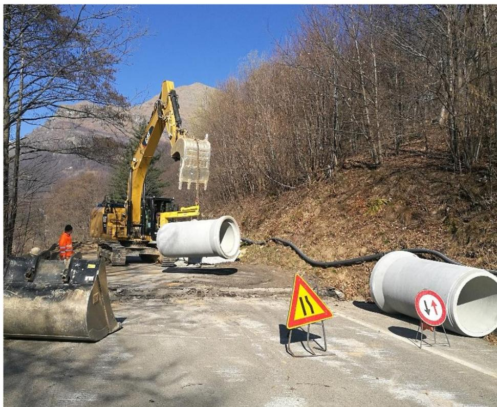
*Figura 28 Realizzazione dei canali per la regimazione delle acque posti sotto la sede stradale*
