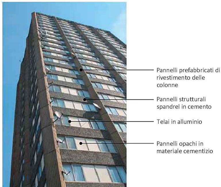
*Figura 2- 2: Rivestimento esterno prima della ristrutturazione*
