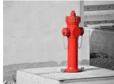
Figura 3.7 Idrante soprasuolo
