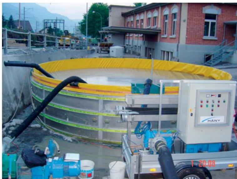
**Figura 3.9** Vasca mobile di raccolta acque di spegnimento<sup>19</sup>
