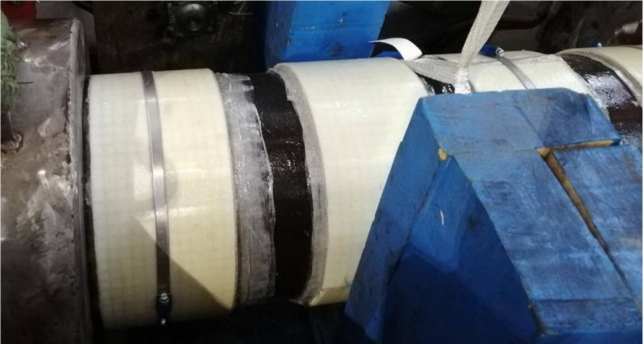
Figura 32. Tubo posizionato all'interno del macchinario.
