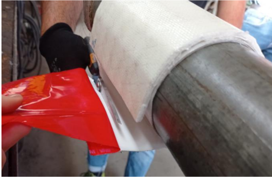
Figura 28. Applicazione del sandwich MadFlex accoppiato al nastro biadesivo.
