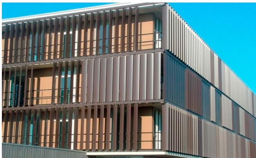
**Figura 3.5: Side shading system - Schermatura verticale/orizzontale.** Fonte: "Schermature Solari Orizzontali E Verticali - Tende - Schermature Solari." 2022. Rifaidate.it. 2022. <https://www.rifaidate.it/arredamento/tende/schermature-solari-orizzontali-e-verticali.asp>.
