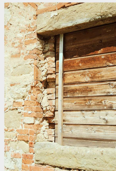
Dettaglio | Vista dell'"interno" della cornice grazie al piedritto e alle pietre dello sgancio (in cui erano inseriti i cardini degli infissi) mancanti.
