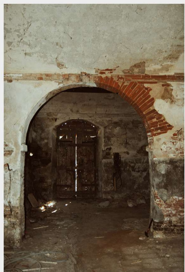
Ambiente 0.07 | Dettaglio cornice d'imposta e sviluppo consecutivo delle volte comunicanti grazie a portali con arco a tutto sesto.
