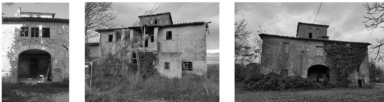
Figura 11 Leopoldine con apertura della loggia tamponata. A sx Leopoldina del Podere Primo di Brolio. [foto realizzate dall'autrice, estratto Tav. 2]
