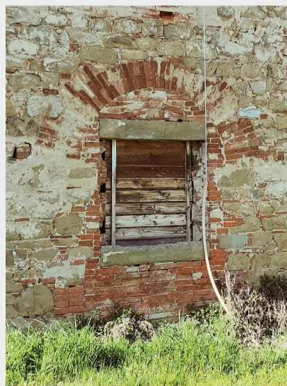
Vista esterna | Visione d'insieme dell'apertura presa in analisi.
