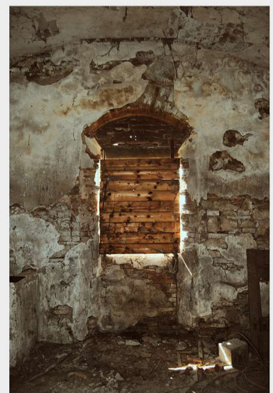
Ambiente 0.07 | Vista interna dell'apertura presa in analisi nella quale si può capire il metodo di tamponatura dell'arco di scarico all'interno.
