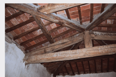
Ambiente 2.01 | Capriata lignea con paradossi angolari e arcarecci addossati ad essi con chiodatura di connessione visibile e non sufficiente rispetto le dimensioni degli elementi.
