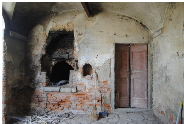
Figura 24 Forno e porta di accesso al corpo scale [ambiente 0.01]
