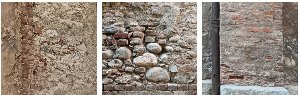
**Figg. 3, 4 e 5\_** Dettaglio di un angolo, con muratura di laterizi a due teste disposte ad angolo retto. / Dettaglio della tessitura muraria della facciata est, con pietrame non lavorato di diversa pezzatura e corsi di spianamento in laterizio apparecchiati con malte a base di calce idraulica naturale e sabbia. / Dettaglio di una parasta della facciata sud, con laterizi a correnti sfalsati allettati con malte a base di calce idraulica naturale e sabbia.
