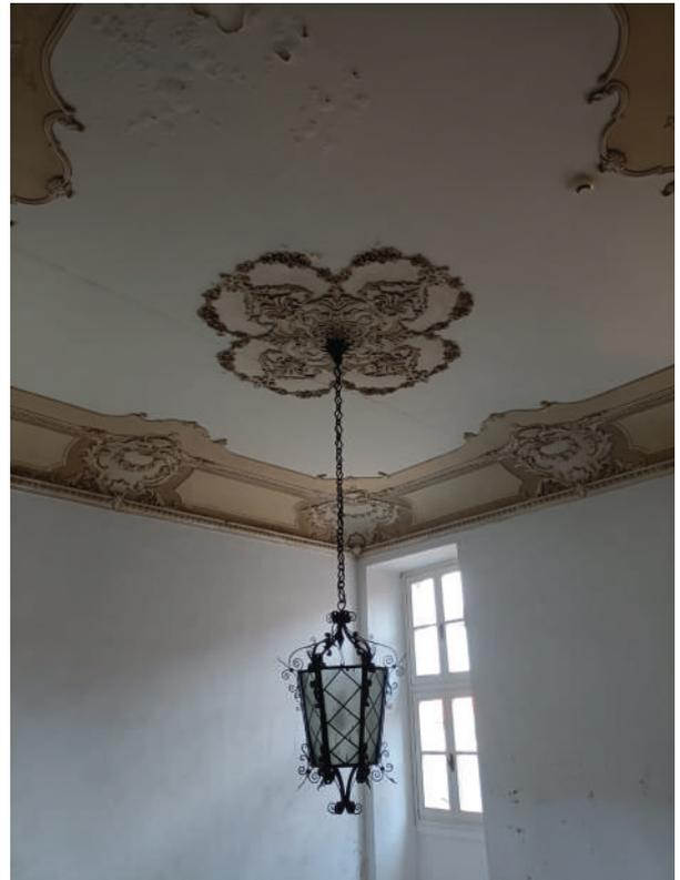
**Figg. 63 e 64** *Decorazioni in stucco di un solaio al piano terreno. / Volta dello scalone, con decorazioni floreali e cornice all'imposta della volta.*
