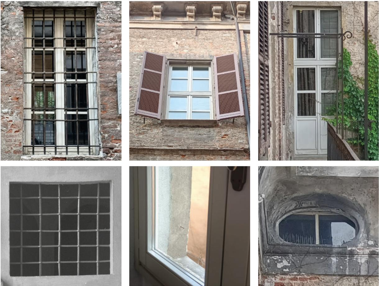
**Figg. 24, 25, 26, 27, 28 e 29** Finestra del piano terreno a doppio battente in legno verniciato di colore avorio, con inferriata. / Finestra del primo piano a doppio battente con persiane in legno tinteggiate. / Porta finestra con sopraluce di accesso al balcone del cortile interno. / Apertura del vano scala con inferriata, in una foto storica. Fonte: MCC, Archivio fotografico. / Dettaglio del serramento con doppio vetro. / Oculo del sottotetto con serramento costituito da vetro singolo.
