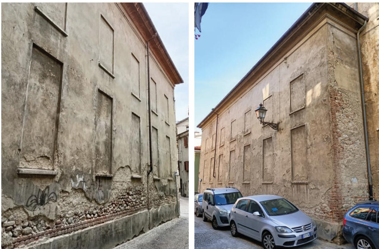
**Figg. 72 e 73** Facciata est e facciata nord, in cui si manifesta l'esfoliazione e il distacco dell'intonaco, in particolare fino all'altezza del piano terreno.
