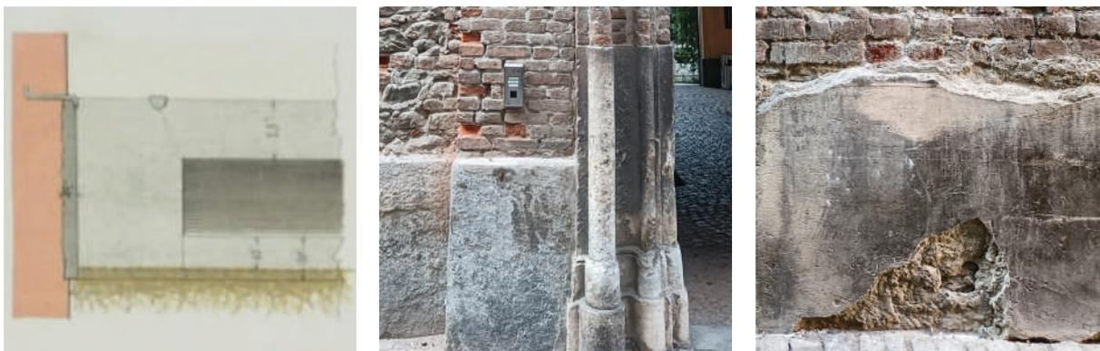
**Figg. 47, 48 e 49** \_Dettaglio di lastra di pietra applicata al muro. Fonte: Musso, G. e Copperi, G. (1885). *Particolari di costruzioni murali e finimenti di fabbricati*, Torino, G. B. Paravia, tav. IX. / Zoccolo in pietra, alla base della facciata principale su via Cacciatori delle Alpi. / Zoccolo in calcestruzzo.
