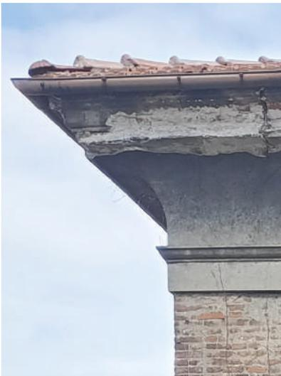
**Figg. 44, 45 e 46** *Cornicione della facciata su via Cacciatori delle Alpi, ultimato con gronda e modiglioni. / Dettaglio di cornicione. Fonte: Musso, G. e Copperi, G. (1912). Particolari di costruzioni murali e finimenti di fabbricati, Torino, G. B. Paravia, tav. XIII. / Cornicione a gola dei prospetti secondari.*
