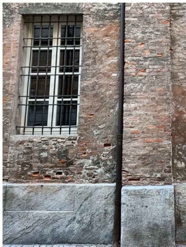
**Figg. 76 e 77** *Inferriata ossidata / Parte terminale del pluviale ossidato.*
