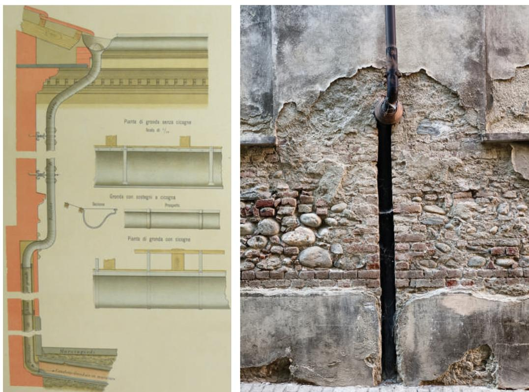
**Figg. 65 e 66** \_ Sistema di smaltimento delle acque meteoriche. Fonte: Musso, G. e Copperi, G. (1912). *Particolari di costruzioni murali e finimenti di fabbricati*, Torino, G. B. Paravia, tav. XXX. / Pluviale parzialmente incassato nella muratura.
