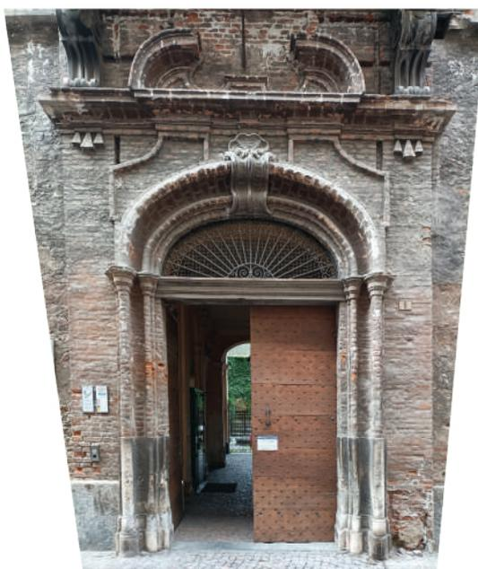
**Fig. 1** *Foto raddrizzamento di una porzione di facciata. Ingresso da via Cacciatori delle Alpi, 9.*
