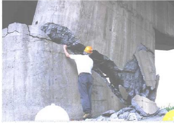
Figura 11: Il collasso per taglio che anticipa quello per flessione
