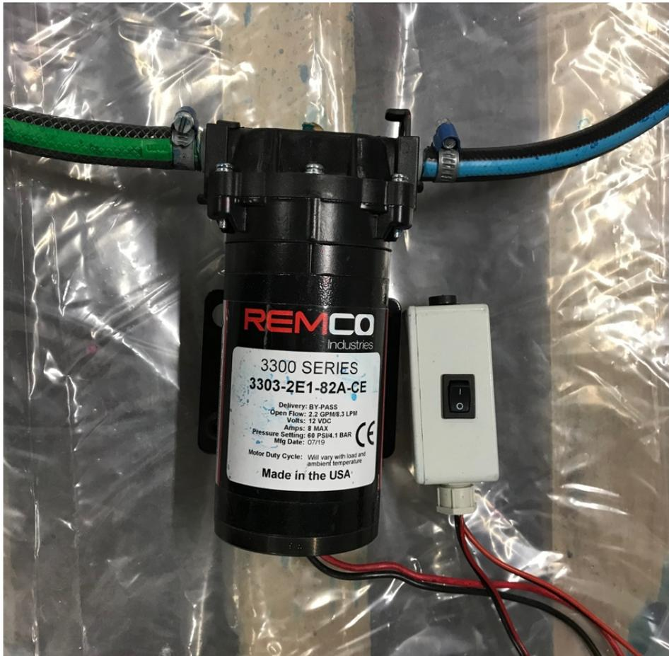
Figura 3-3 Pompa del circuito con il proprio interruttore
