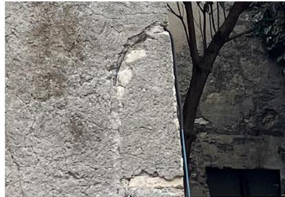
Consiste nella formazione di soluzioni di continuità nel materiale e che può provocare lo spostamento reciproco delle parti con conseguente distacco. Questo fenomeno avviene nel momento in cui il materiale è sottoposto ad un'eccedenza nel carico che potrebbe sopportare.
