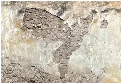
Si intende una forma di alterazione che consiste nella perdita di adesione tra i diversi strati che compongono una struttura, riguarda principalmente, come nel caso in esame, gli intonaci.
