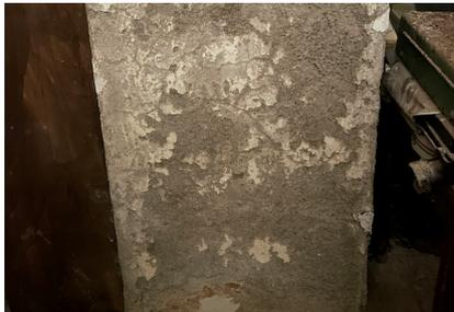
Massima altezza raggiunta dall'umidità di risalita capillare all'interno delle murature, con formazione dei tipici danni come la formazione di efflorescenze e sub-efflorescenze saline, la disgregazione e polverizzazione dei giunti di malta e l'esfoliazione dei mattoni o conci di pietra. La muratura sottostante assume invece una colorazione più scura dovuta alla presenza di acqua.
