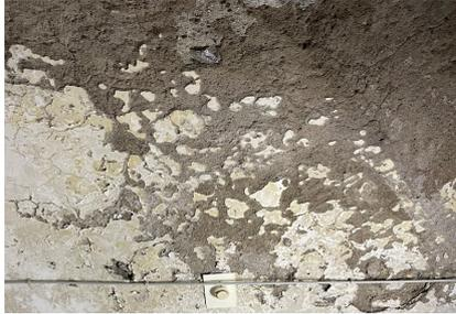
Disfacimento del materiale per cause fisiche, che può portare alla perdita delle caratteristiche originarie dello stesso. Decoesione con caduta di materiale sotto forma di polvere o minutissimi frammenti. Dovuto a fenomeni di umidità ascendente e dilatazioni tra materiali di supporto e finitura.
