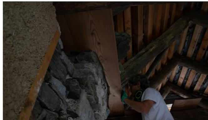
Fig. 153 - Fissaggio dell'asse accertandosi che sia contro il muro.
