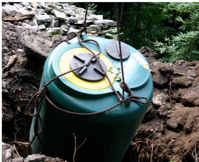
Fig. 59 - Foto durante il posizionamento della vasca Imhoff. (Foto di Maurizio Cesprini)
