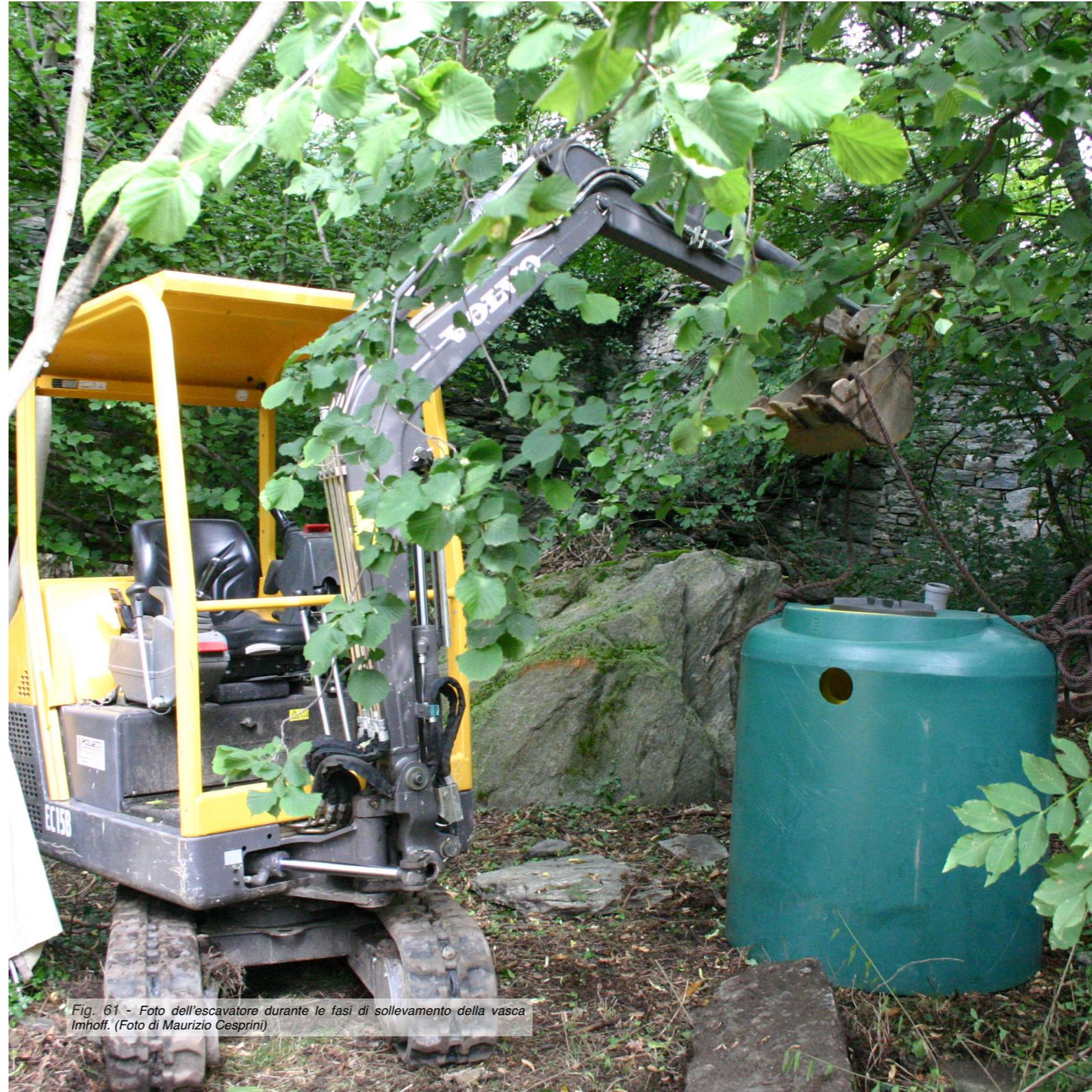
Fig. 61 - Foto dell'escavatore durante le fasi di sollevamento della vasca Imhoff. (Foto di Maurizio Cesprini)
