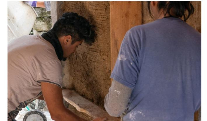
Fig. 97 - Rimozione dell'eccesso di termointonaco. (Foto di Mattis Riccardo)
