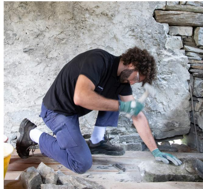
Fig. 76 - Fase di sbozzatura di un sasso per il completamento delle cuciture puntuali. (Foto di José Luis Reyes Mesias)
