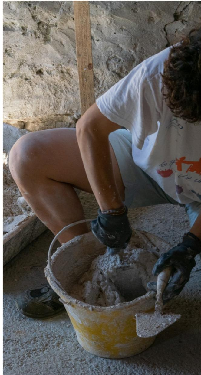
Fig. 95 - Dopo aver preso l'impasto dalla betoniera lo studente miscela ulteriormente prima di procedere alla posa del termointonaco (Foto di José Luis Reyes Mesias)
