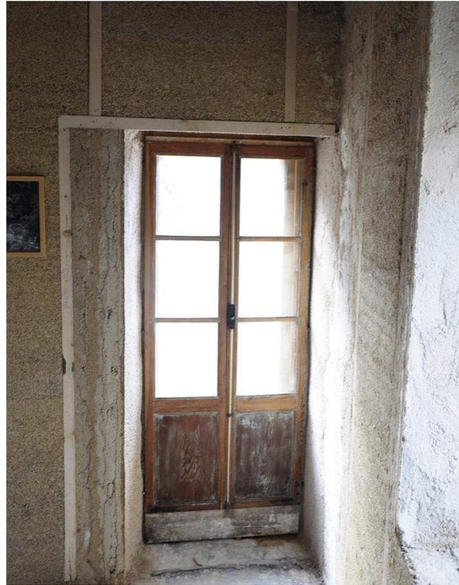
Fig. 139 - Posizionamento montatni porta Sud.
