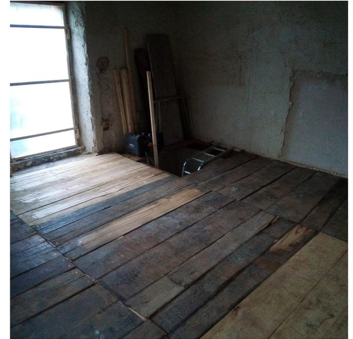
Fig. 199 - Tavolato inferiore del solaio interpiano (Foto di Yann Crivelli)
