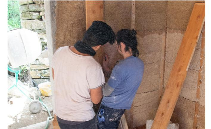
Fig. 97 - Fissaggio del cassero per definire le spalle della porta. (Foto di Mattis Riccardo)
