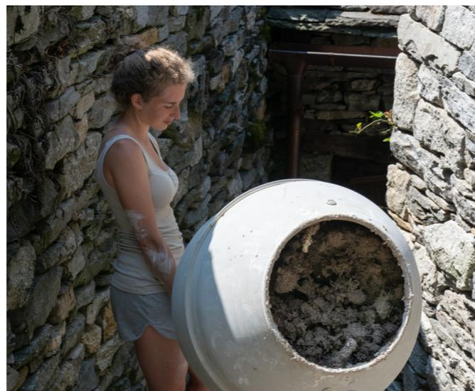
Fig. 82 - Durante le fasi di miscelazione in betoniera, uno stendente inclinava la betoniera per amalgamare la miscelazione. (Foto di José Luis Reyes Mesias)
