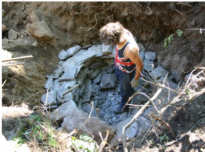
Fig. 60 - Foto della costruzione della botte invertita per la stabilità della vasca. (Foto di Maurizio Cesprini)
