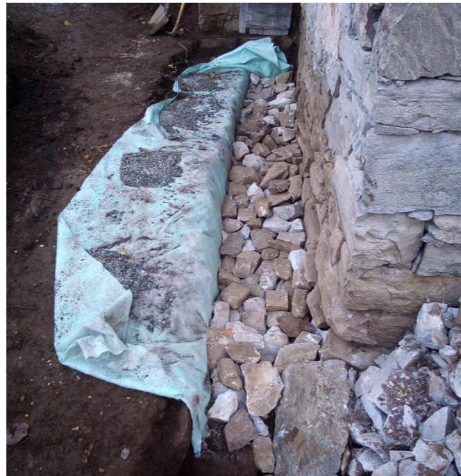
Fig. 202 - Trincea angolo Sud-Est con riempimento sassi di risulta e geotessuto (Foto di Yann Crivelli)
