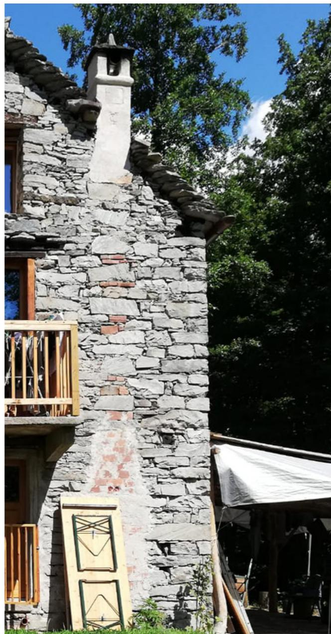
Fig. 206 - Cucitura del muro esterno in mattoni (Foto di Yann Crivelli)
