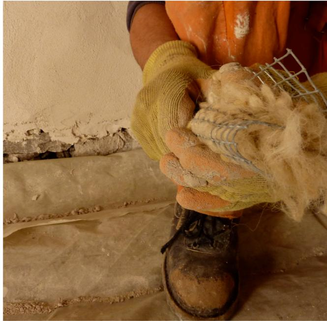
Fig. 44 - Foto durante la preparazione dei rotoli di lana. (Foto di Maurizio Cesprini)
