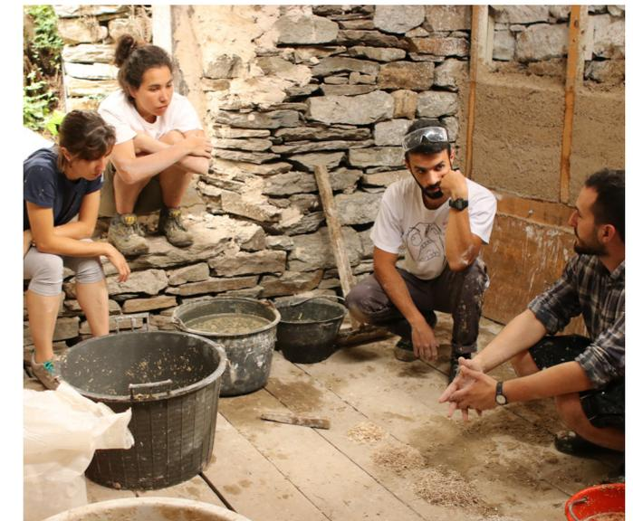
Fig. 81 - Fasi di apprendimento sull'applicazione del termo intonaco. Team studentesco “La Termitière”.
