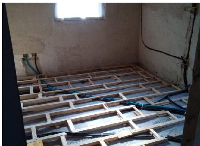
Fig. 226 - Distribuzioni interna delle tubazioni (Foto di Yann Crivelli)
