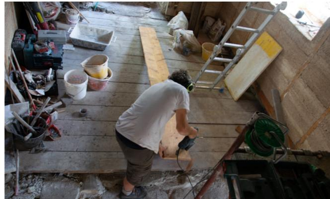
Fig. 152 - Rifilatura con il seghetto alternativo della prima asse.
