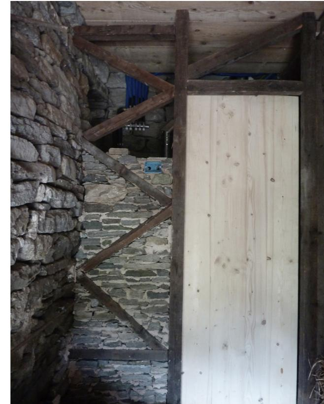
Fig. 51 - Foto durante i lavori di costruzione della partizione interna al piano terra in pietra e legno. (Foto di Maurizio Cesprini)
