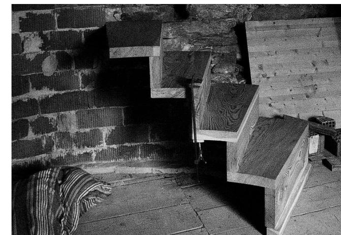
Fig. 55 - Foto delle prime fasi durante il montaggio della scala. Si notano i morsetti che vengono usati per fissare al meglio le assi (Foto di Maurizio Cesprini)
