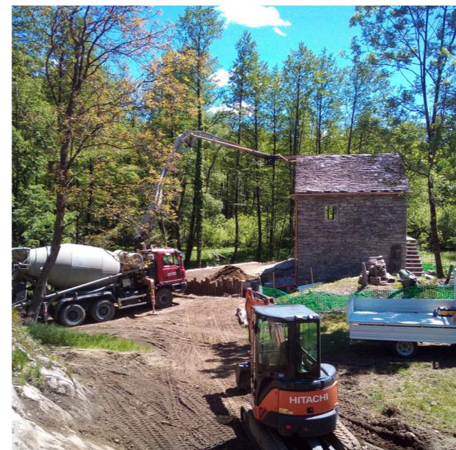
Fig. 195 - Arrivo della betoniera per il getto del cls (Foto di Yann Crivelli)
