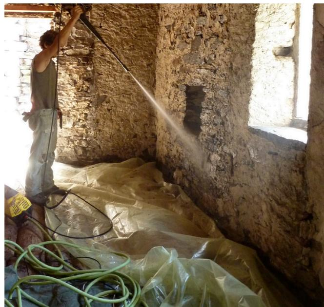
Fig. 46 - Foto di Maurizio durante la pulizia interna del muro usando l'idropulitrice. (Foto di Arnaldo Abba)
