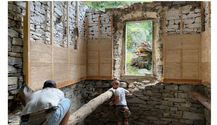
Fig. 73 - Altra veduta dell'artigiano Cantaluppi durante le fasi di sostituzioni delle travi principali. (Foto di Maurizio Cesprini)
