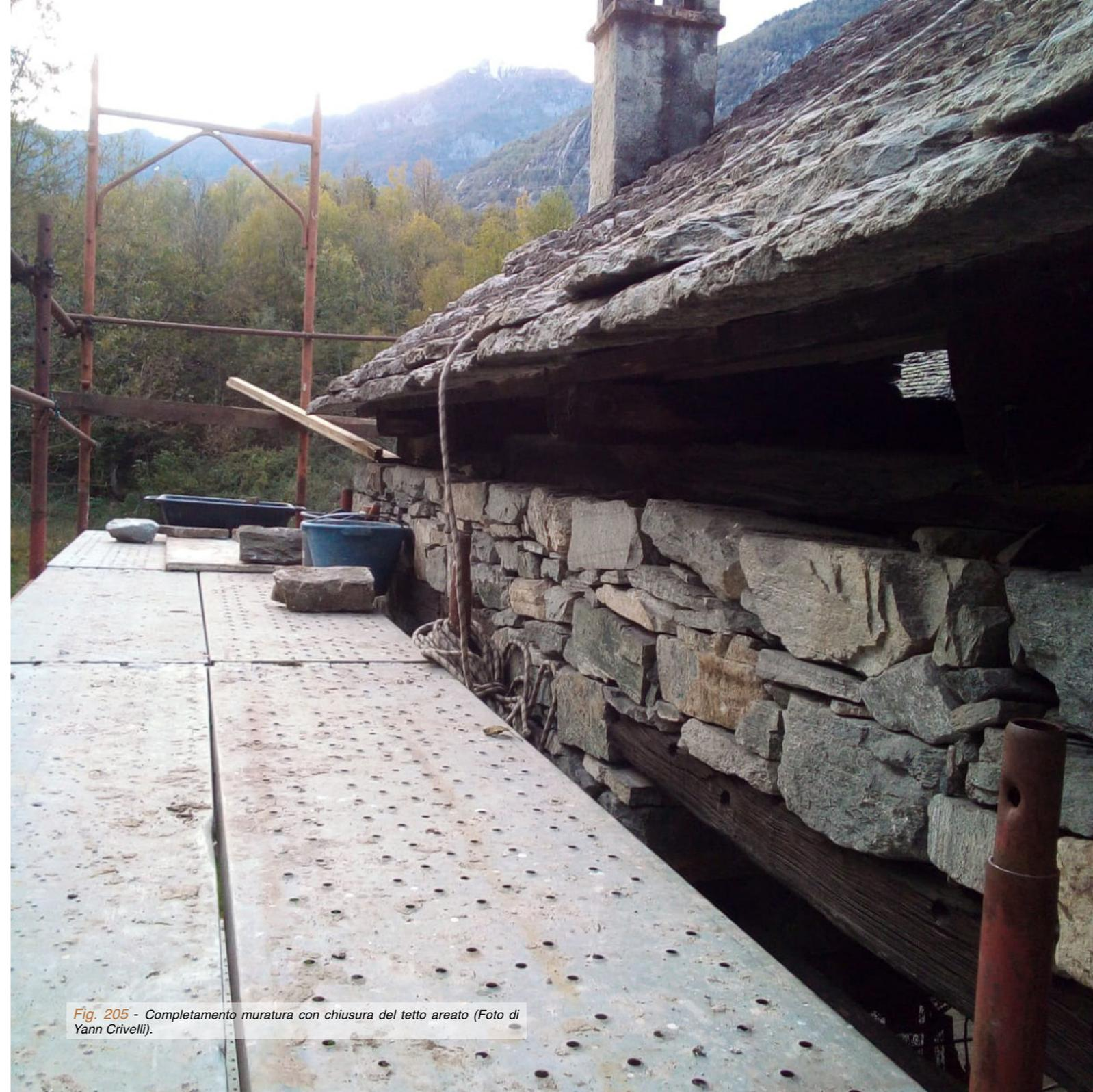
Fig. 205 - Completamento muratura con chiusura del tetto areato (Foto di Yann Crivelli).
