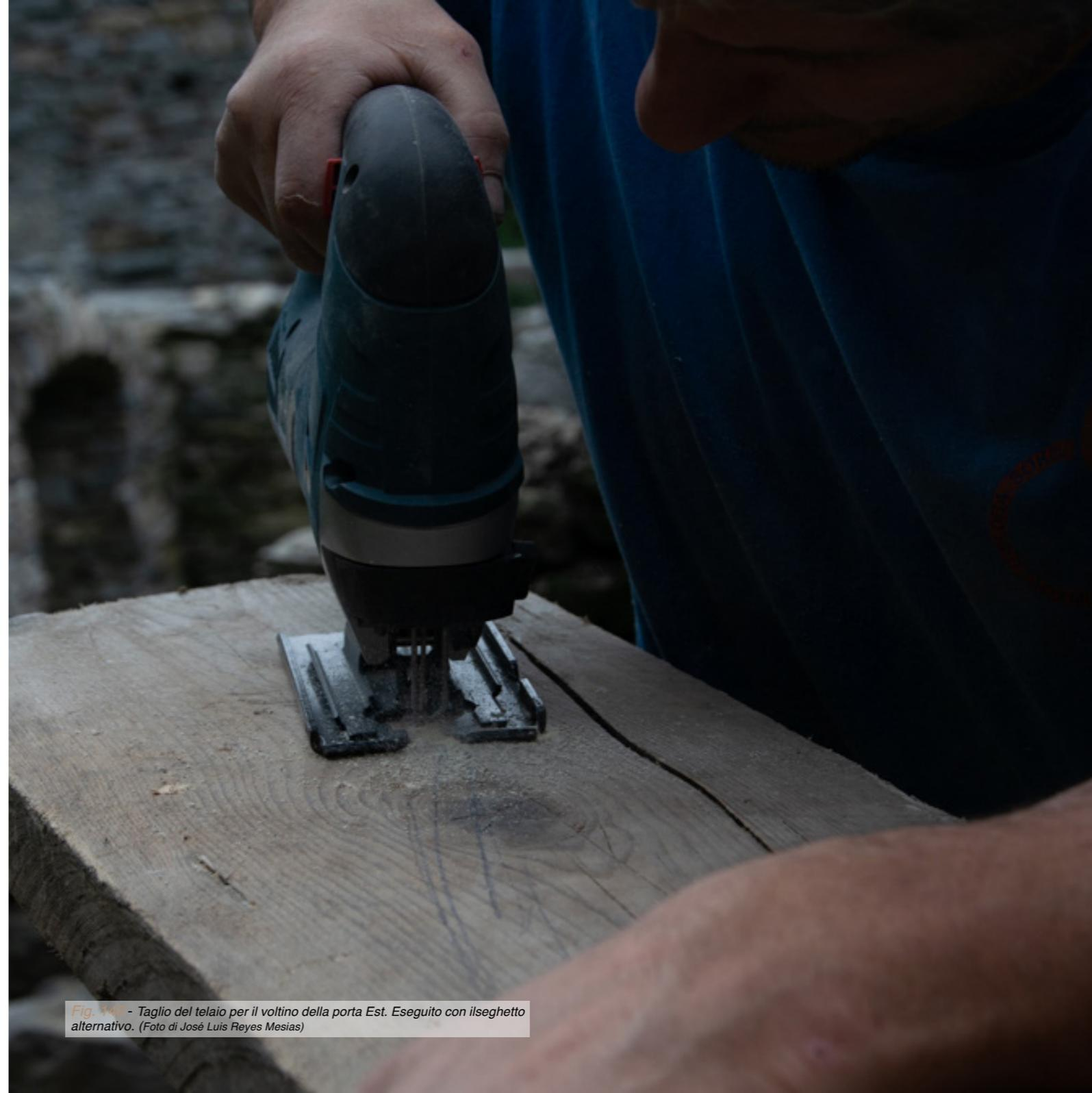
Fig. 140 - Taglio del telaio per il voltino della porta Est. Eseguito con il seghetto alternativo. (Foto di José Luis Reyes Mesias)
