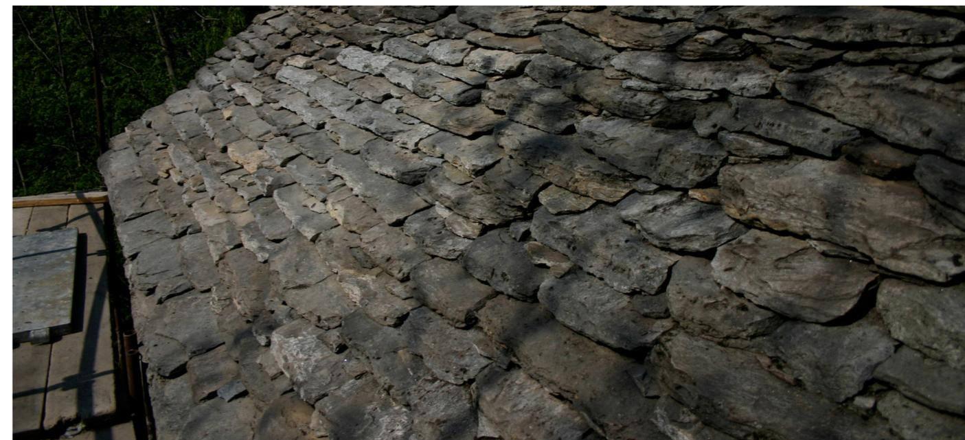
Fig. 28 - Foto dello stato del tetto post-intervento. (Foto di Maurizio Cesprini)
