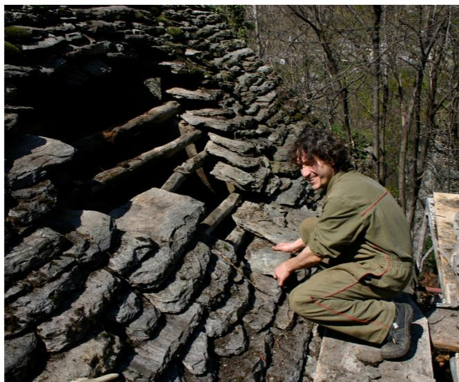
Fig. 26 - Foto Maurizio durante la riparazione delle beole del tetto. (Foto di Maurizio Cesprini)
