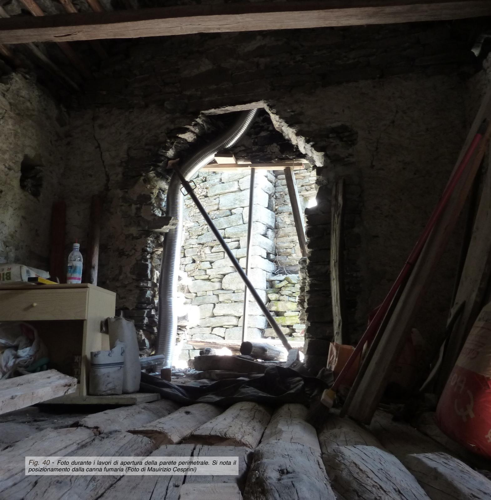
Fig. 40 - Foto durante i lavori di apertura della parete perimetrale. Si nota il posizionamento della canna fumaria (Foto di Maurizio Cesprini)
