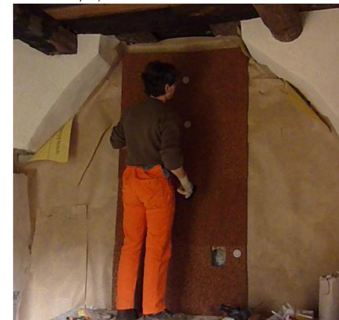
Fig. 49 - Foto di Maurizio durante il posizionamento dei pannelli di isolametro in sughero nel caminetto al primo piano. Lato Nord. (Foto di Maurizio Cesprini)
