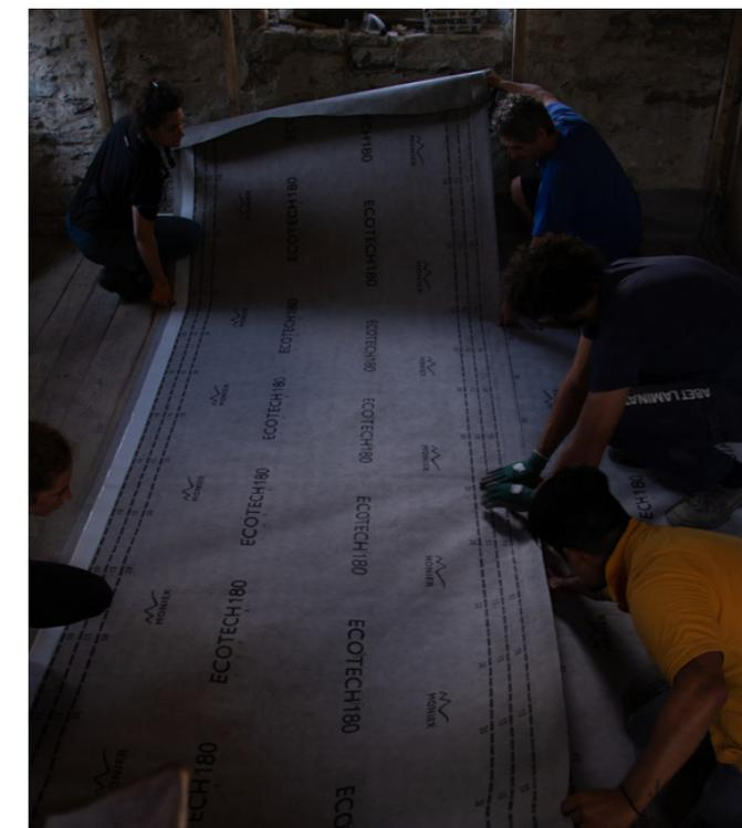
Fig. 166 - Posa delle barriera al vapore. (Foto di Redina Mazelli)
