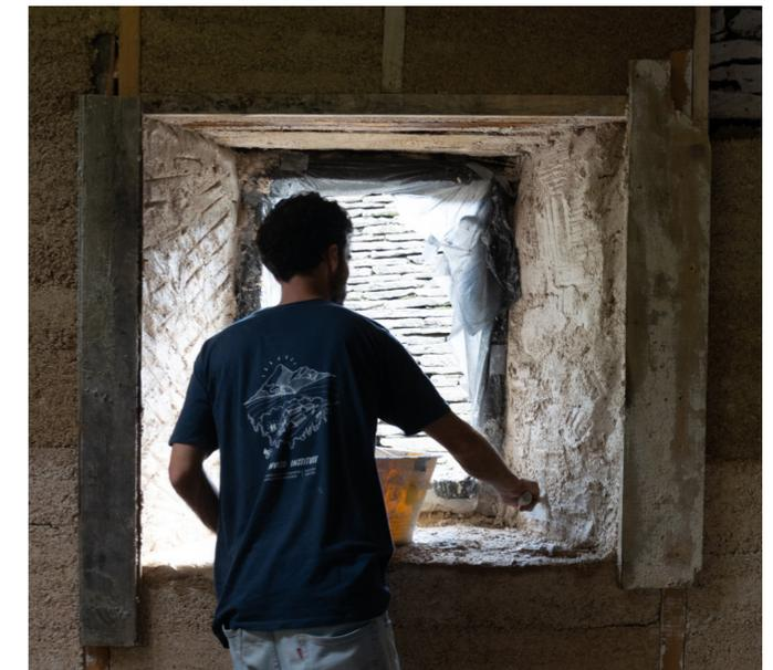
Fig. 137 - Posizionamento montanti finestra Sud.
