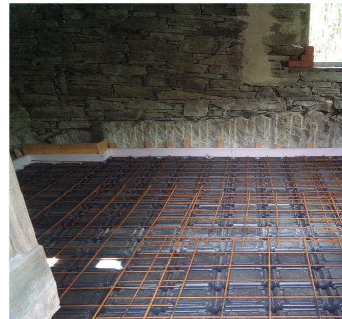
Fig. 194 - Posa degli igloo e della rete metallica per il massetto (Foto di Yann Crivelli)
