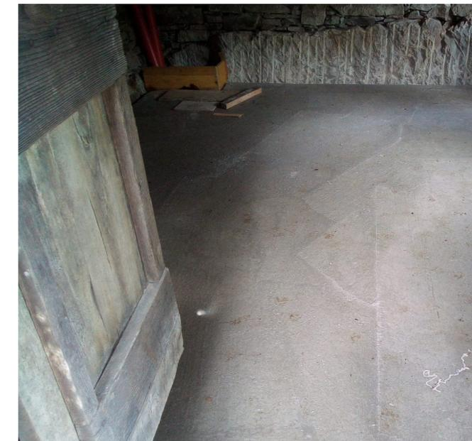
Fig. 196 - Posa massetto in cls (Foto di Yann Crivelli)
