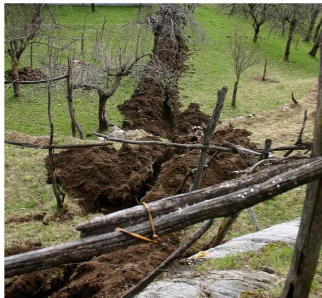
Fig. 62 - Foto degli scavi per la posa delle tubazioni per i collegamenti elettrici e idrici. (Foto di Maurizio Cesprini)
