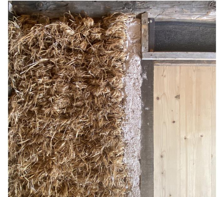
Fig. 52 - Foto di dettaglio della partizione in legno e paglia al piano terra. (Foto di Maurizio Cesprini)
