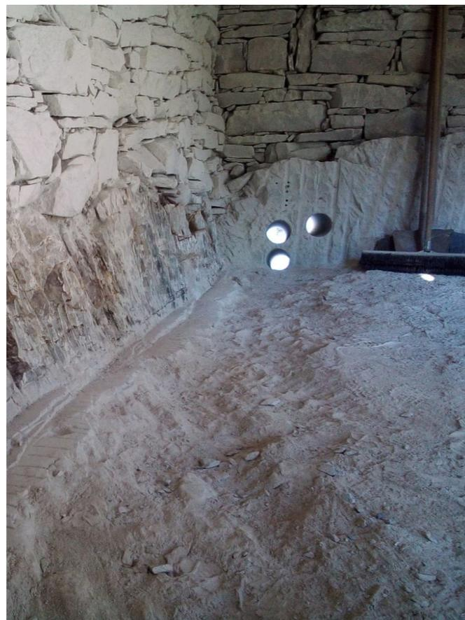
Fig. 193 - I tre fori eseguiti nella roccia da cui passeranno le tubazioni di scarico delle acque nere, i tubi di aerazione forzata e scarico delle acque accumulate. (Foto di Yann Crivelli)
