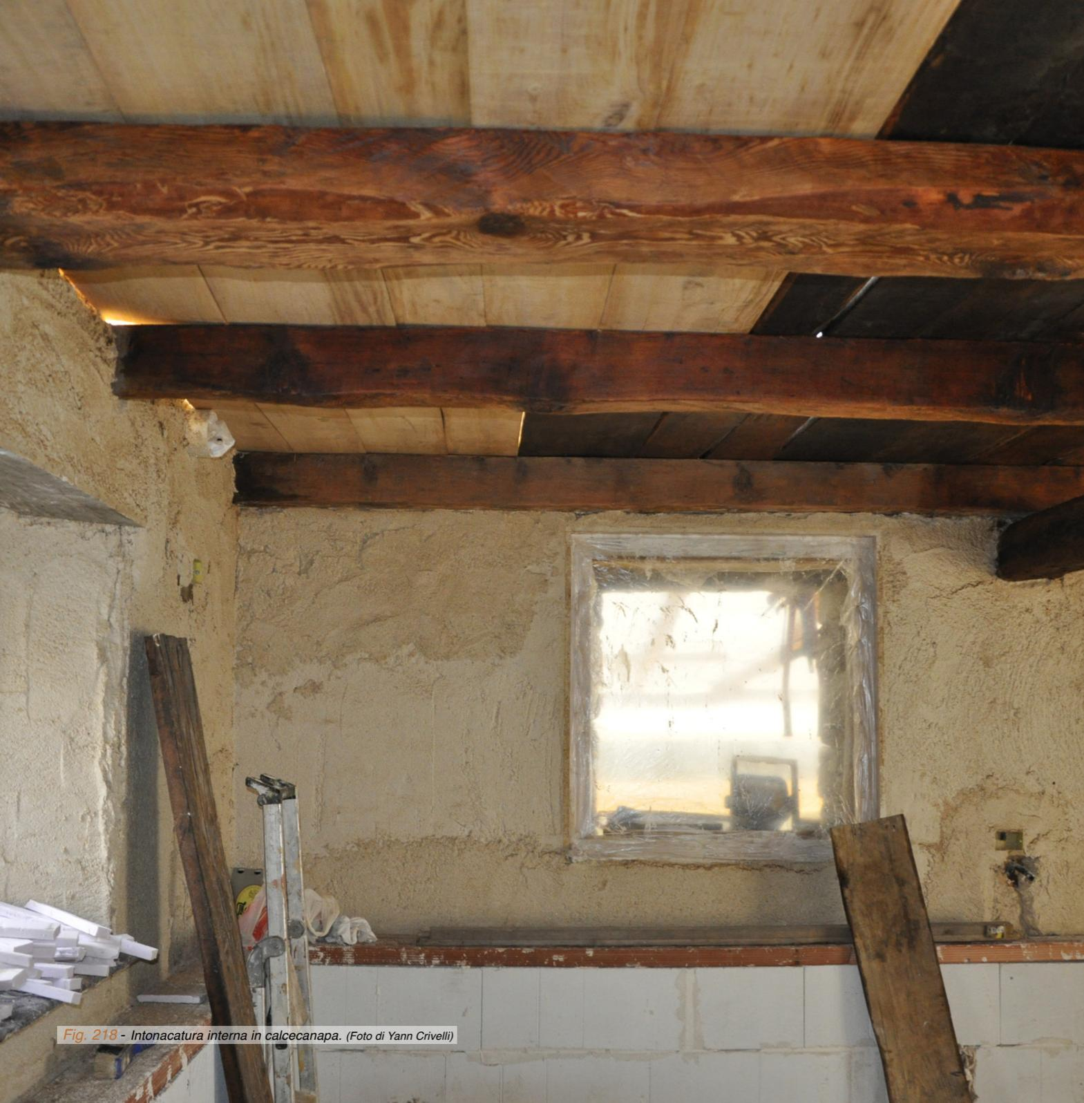
Fig. 218 - Intonacatura interna in calcecanapa. (Foto di Yann Crivelli)
