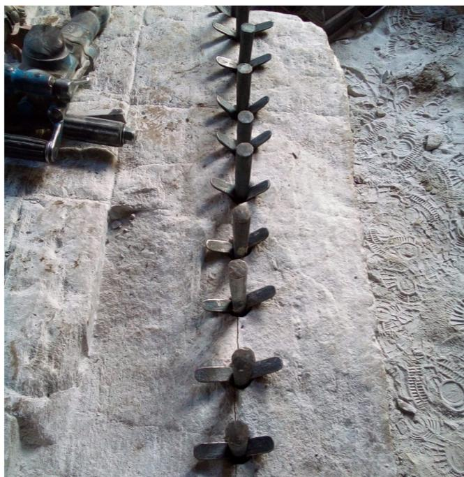
Fig. 190 - Asportazione roccia tramite l'utilizzo di cunei inseriti in fori eseguiti con trapani. (Foto di Yann Crivelli).
