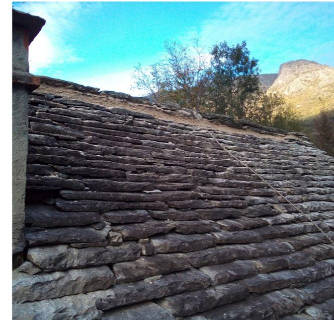
Fig. 221 - Tetto post-intervento (Foto di Yann Crivelli)
