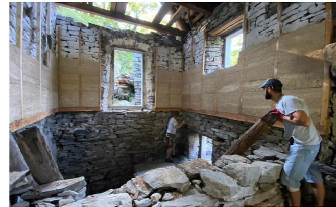
Fig. 72 - L'artigiano Cantaluppi durante le fasi di sostituzioni delle travi principali. (Foto di Maurizio Cesprini)
