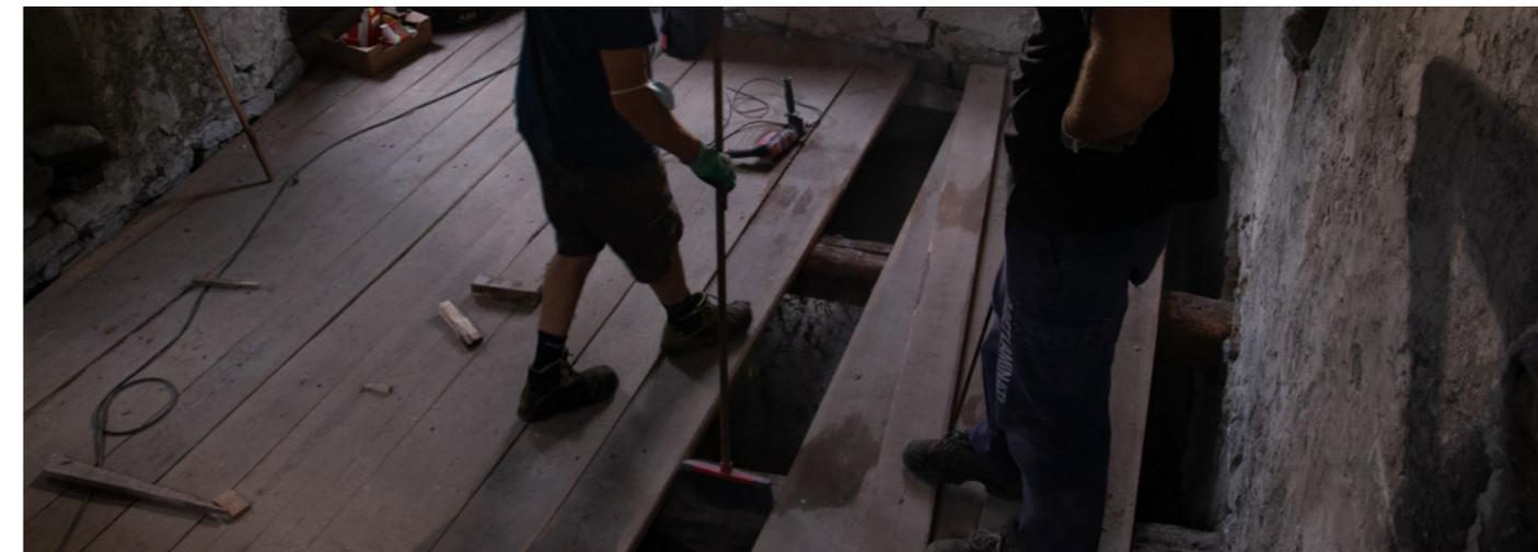
Fig. 144 - Montaggio e smontaggio delle assi. (Foto di José Luis Reyes Mesias)
