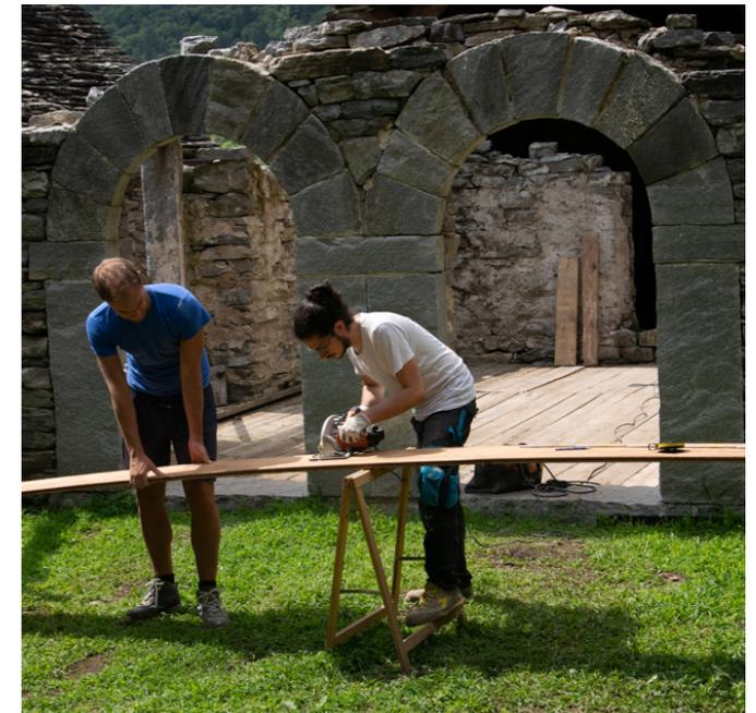
Fig. 156 - Taglio delle assi a misura tramite la sega circolare.
