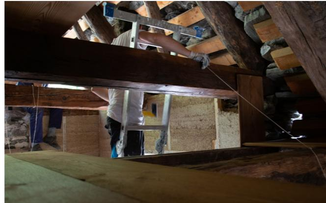
Fig. 151 - Tracciamento per il posizionamento della prima asse.
