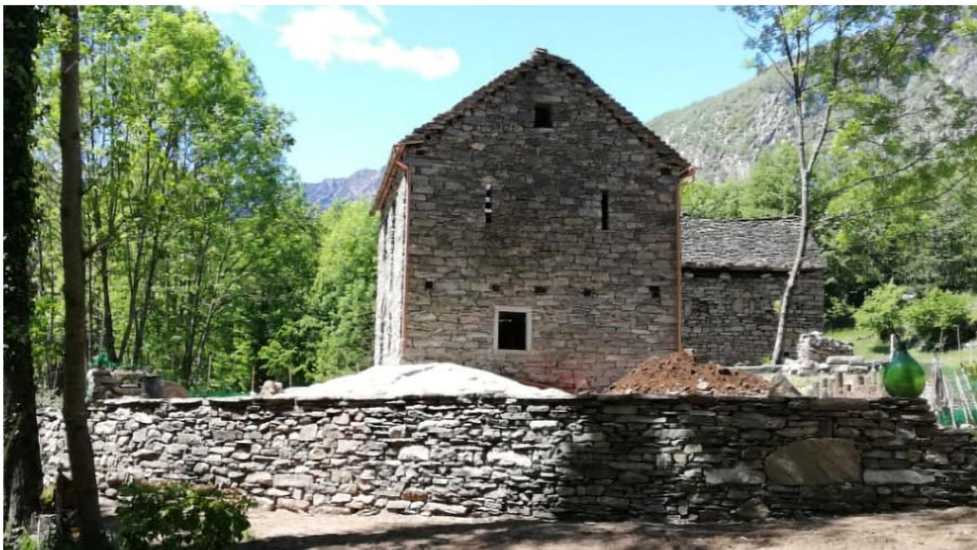
Fig. 204 - Muretto di contenimento post-intervento (Foto di Yann Crivelli)
