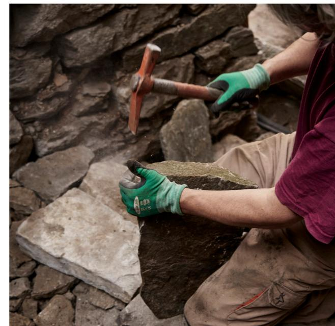
Fig. 9 - Sbozzatura di un sasso eseguita da Maurizio (Foto di Armando Abba)
