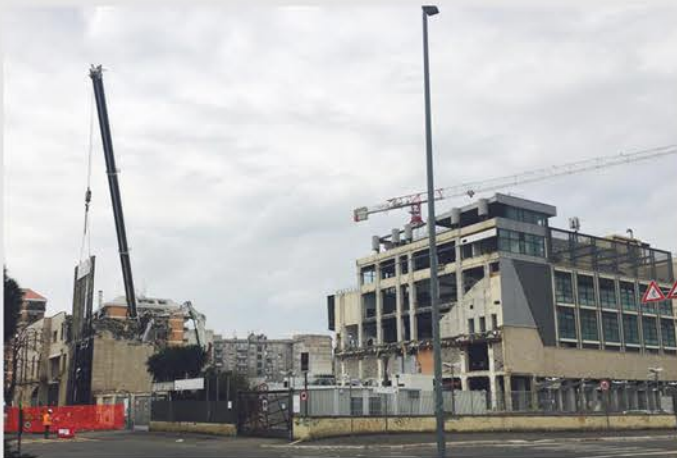
La demolizione della Città del gusto, 2017.
