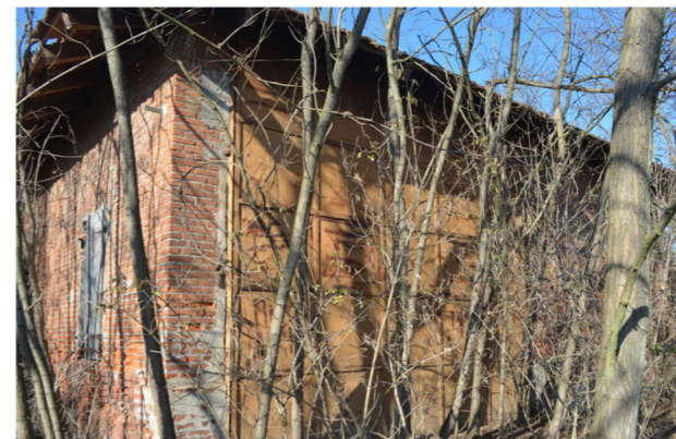
| Il portellone presente sul prospetto sud-est.
