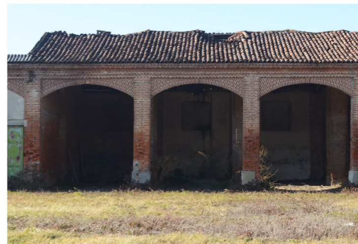
| Gli archi ribassati aperti sulla corte interna della tettoia ovest.
