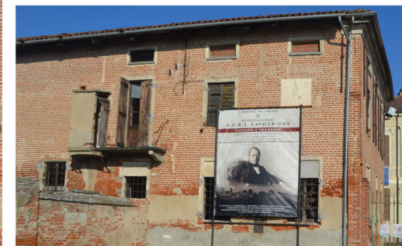
| La facciata sud.
