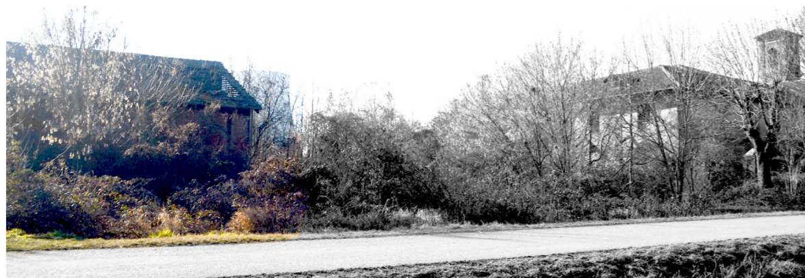
| L'edificio del refettorio (a sinistra) visto dal dormitorio. Sullo sfondo una delle torri della centrale.
