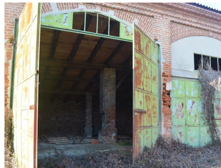
| Le aperture della tettoia ovest chiuse da porte in metallo.
