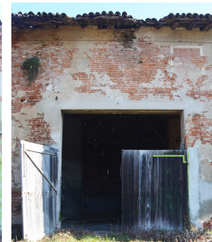
| Uno degli accessi della tettoia est.
