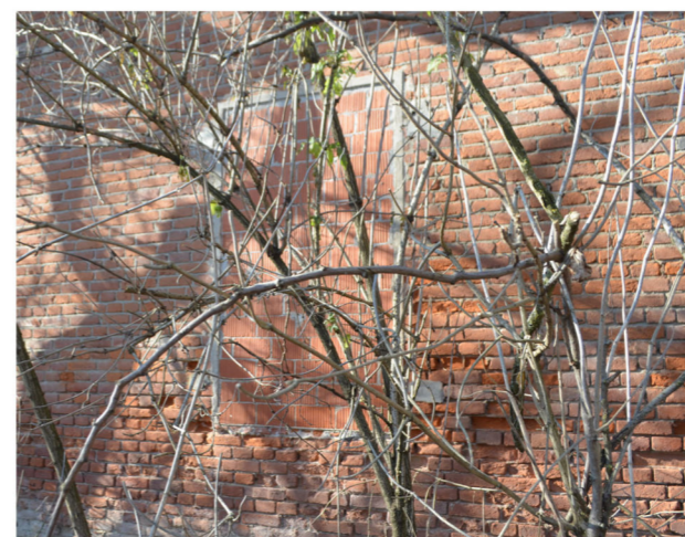
| Il mattone a vista e il tamponamento di un'apertura.
