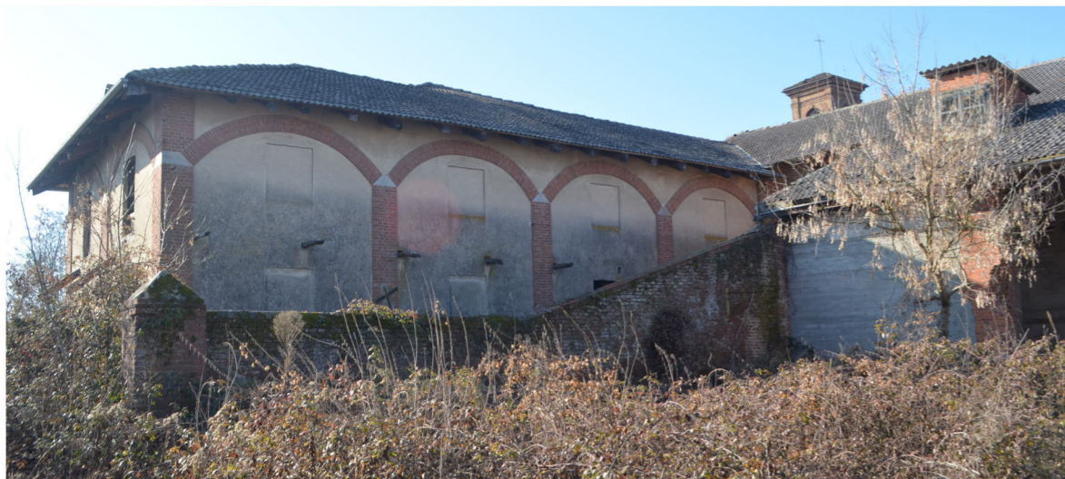
| Le arcate in mattoni del corpo del magazzino .
