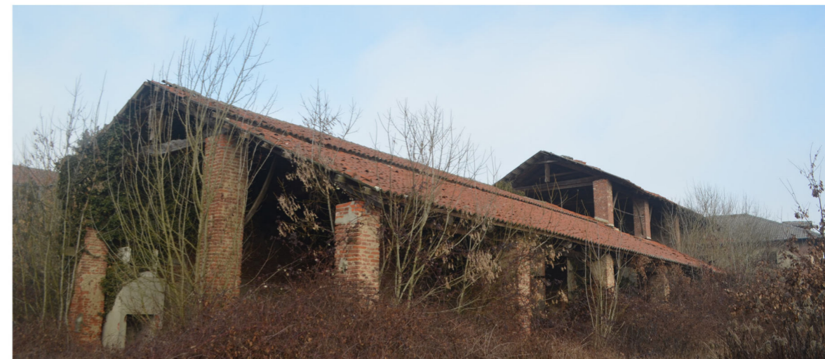
| Le due tettoie e la loro diversa altezza.
