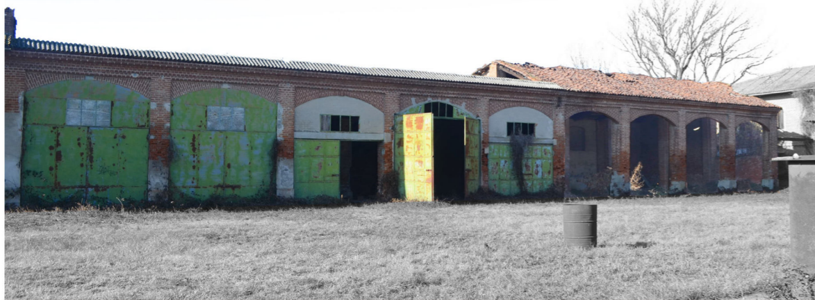
| Le due tettoie della manica ovest viste da dentro la corte.
