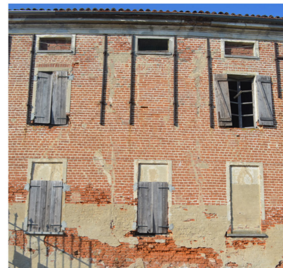
| La simmetria delle aperture nella facciata est.
