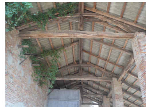
| Il sistema di copertura della prima tettoia.
