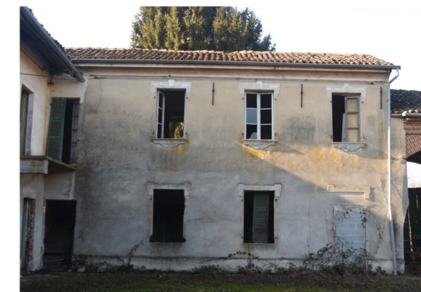
| La facciata est dell'abitazione.
