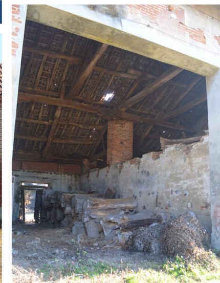
| L'interno della tettoia est.
