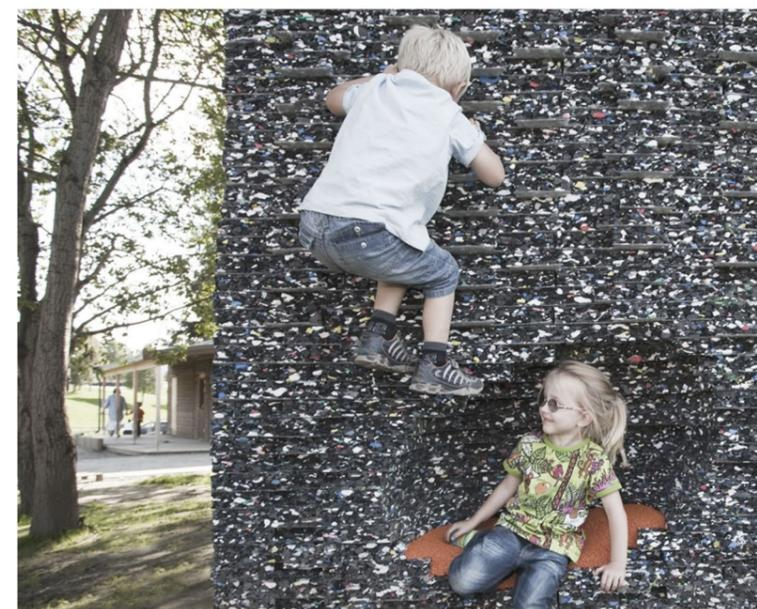
**Fig.5** - Nicchia utilizzata come zona di sosta. Le pareti usate per arrampicarsi grazie alla stratificazione dei pannelli che creano appoggi per poter salire.
