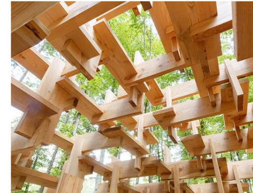
Fig. Dettaglio dell'incastro tra i vari componenti in legno.
