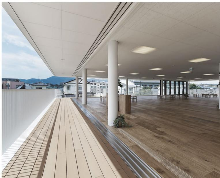
**Fig.4** - Sistema tecnologico a binari delle aperture per creare uno spazio di connessione tra indoor e outdoor.
