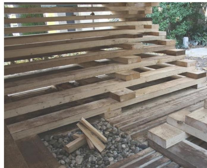
**Fig.2** - Dettaglio interno dell'incastro delle travi.
