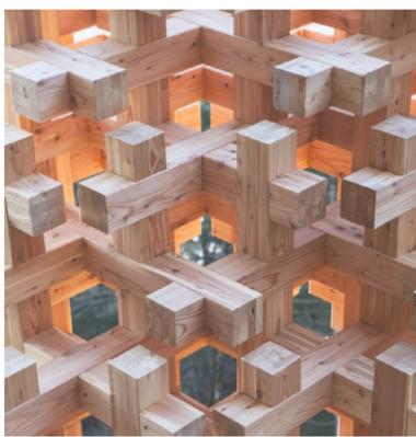
Fig. Dettaglio dell'incastro tra i vari componenti in legno.
