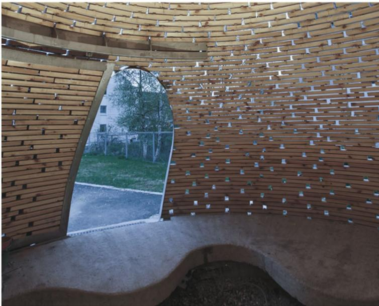
**Fig.2** - Visione interna nel quale si vede il basamento in calcestruzzo e la parete semipermeabile nel quale si notano i fori generati dalla disposizione dei blocchi in legno in modo irregolare.
