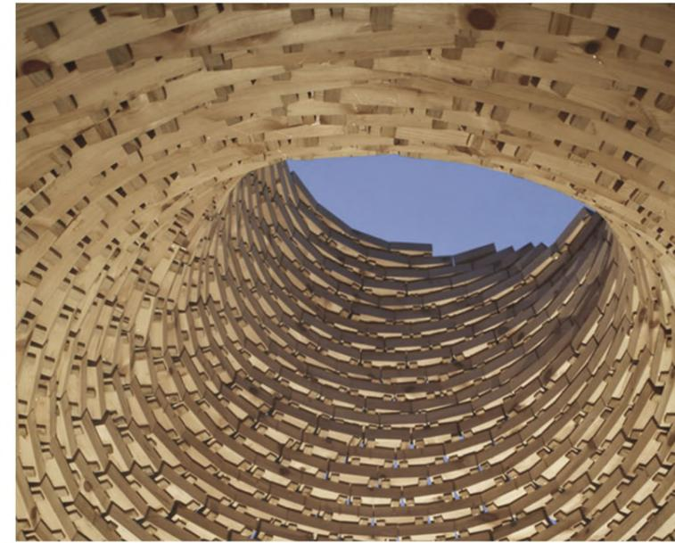
**Fig.5** - Sommità della struttura con foro che lo rende un pozzo di luce naturale ma allo stesso tempo camino.
