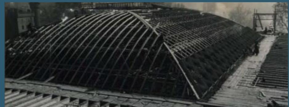
Fig. 30 Struttura in fase di cantiere del Padiglione 3 (da studio di fattibilità, Sezione A- Relazione illustrativa generale)
