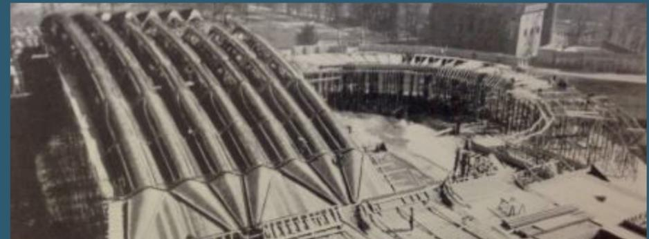
Fig. 29 Foto di cantiere del Padiglione B (da studio di fattibilità, Sezione A- Relazione illustrativa generale)
