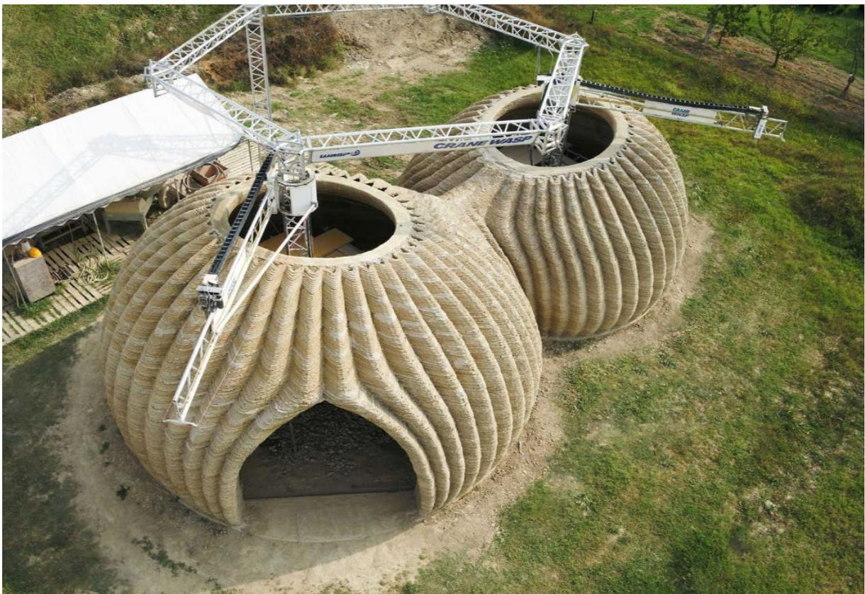
Figura 26: Struttura in terra cruda realizzata con la stampante Crane WASP. Settesere (2021), "Massa Lombarda, la Wasp completa il primo eco-habitat stampato in 3D".
