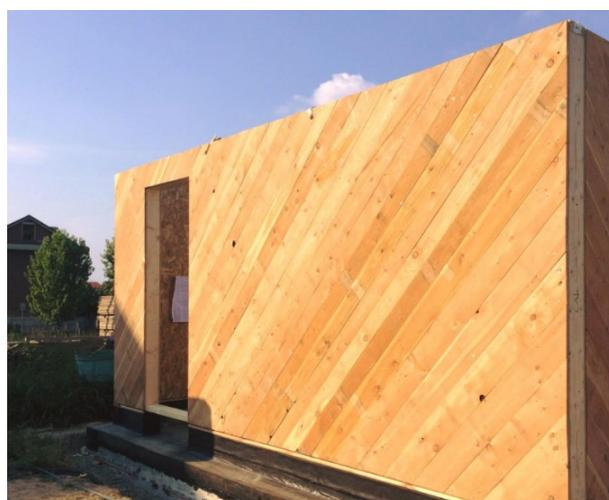
Figura 42: Parete a telaio con tavole a 45° posizionate sul lato esterno. (Abitare.Case e strutture in legno)
