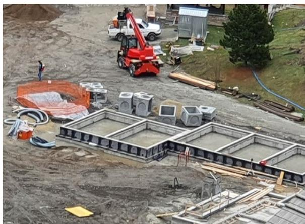
Figura 45: Foto del basamento delle strutture lignee. Si possono notare i cordoli, dove verranno posizionate in seguito le pareti, più alti della quota del terreno. Prigelato (Abitare. Case e strutture in legno)
