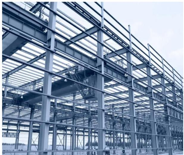
Figura 12: Struttura in acciaio formata da elementi monodimensionali prefabbricati. Calcolo strutturale.com (2018), "L'acciaio".
