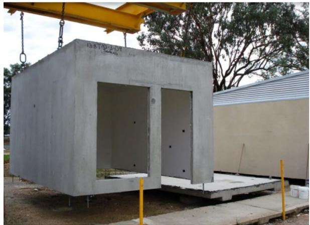
Figura 11: Modulo abitativo in calcestruzzo armato. Pianeta Design, Piegari M., "Case prefabbricate in cemento: modelli, vantaggi e costi".
