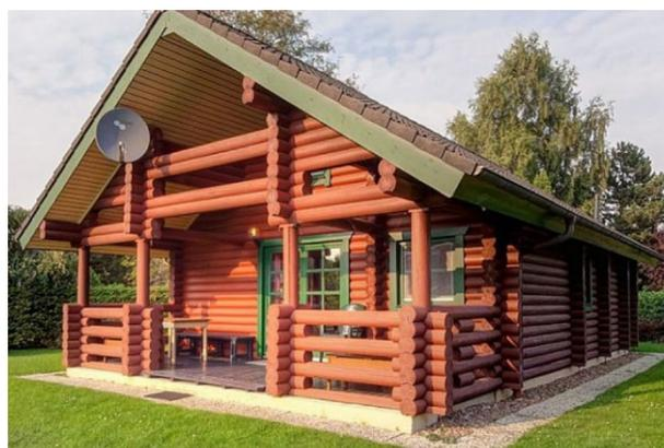
Figura 16: Edificio completamente realizzato attraverso il sistema Blockhouse.
