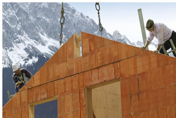
Figura 10: Esempio di pannello prefabbricato in muratura. Lignius (2019), "Case prefabbricate in muratura: prezzi e vantaggi".
