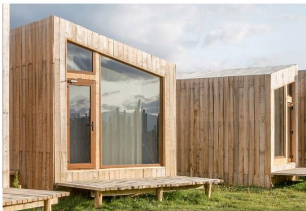
Figura 13: Moduli prefabbricati in legno. Aekitecture on web (2020), "Moduli abitativi prefabbricati in legno. Architettura omaggio al paesaggio cileno".
