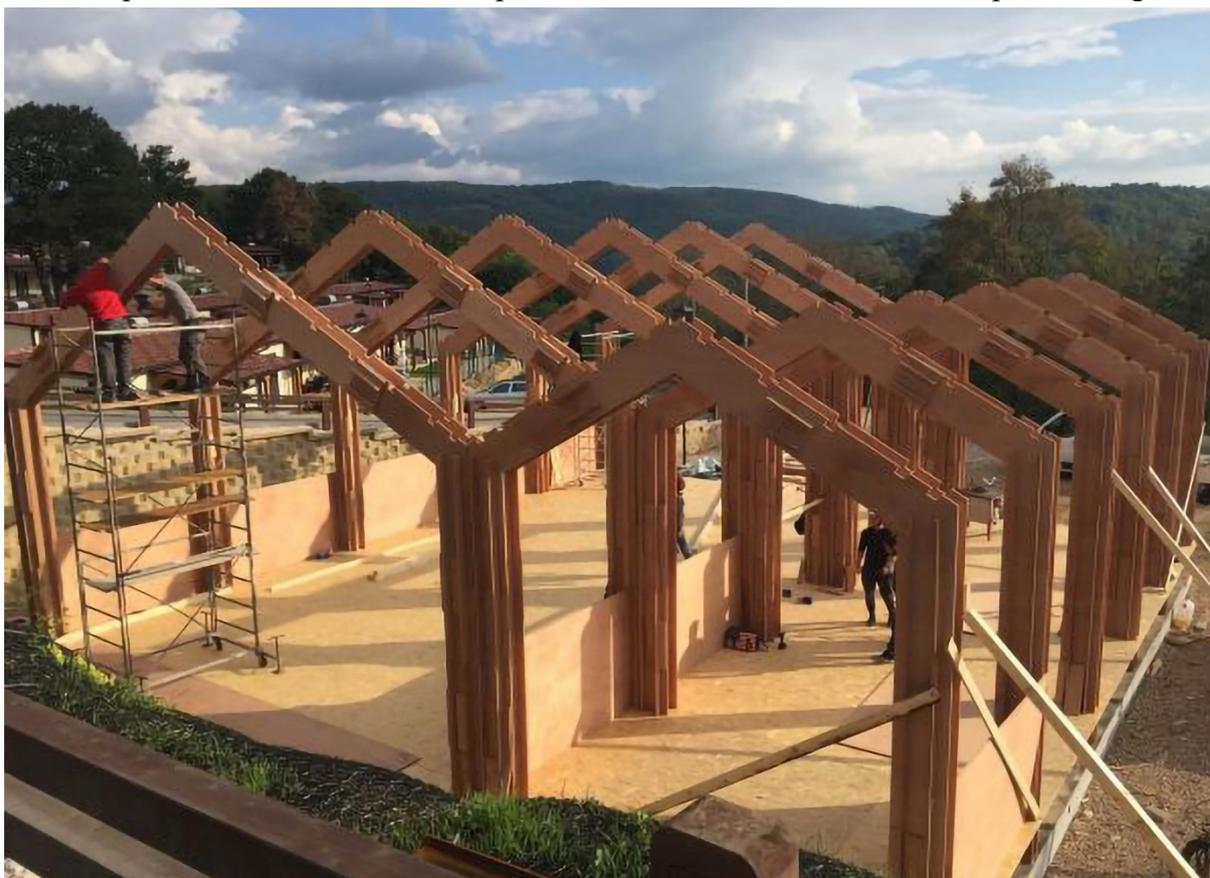
Figura 27: Struttura portante dell'edificio realizzata in compensato di okumè ignifugo. Info Build, Giacometti S., "Un progetto di origine giapponese fa rinascere la città di Accumoli".
