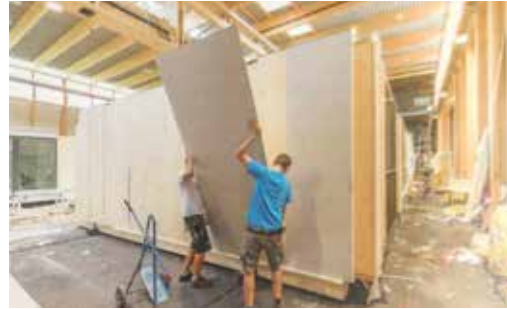
fig 3.5.8 Drywall construction
